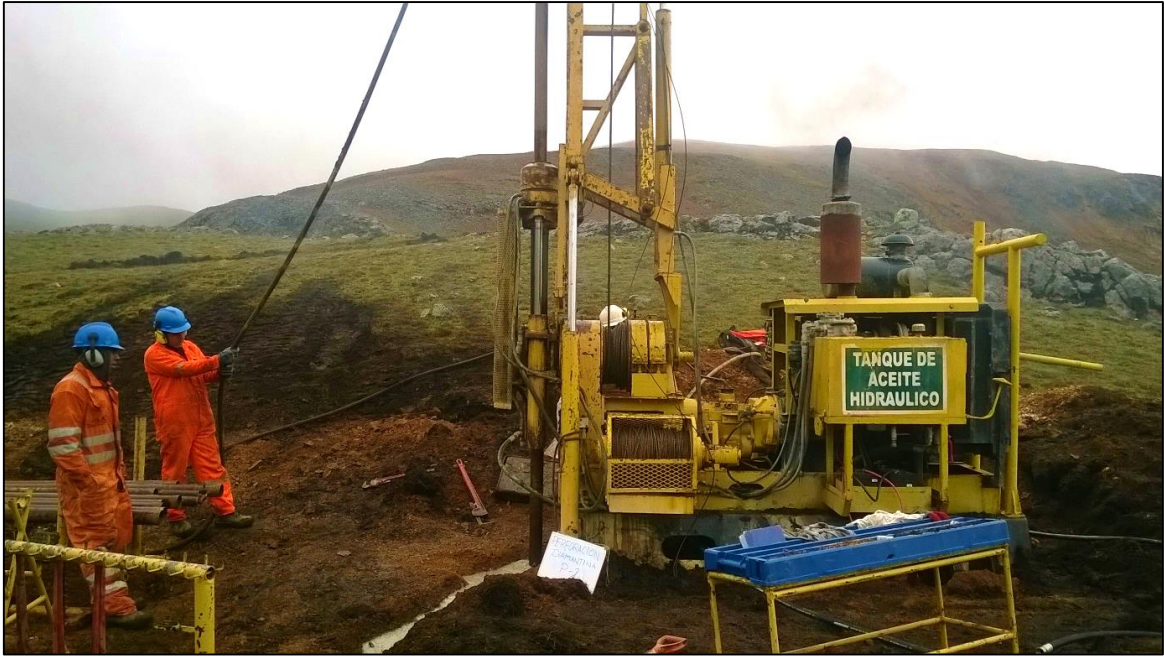
Figura 60: Punto de perforación P2.
