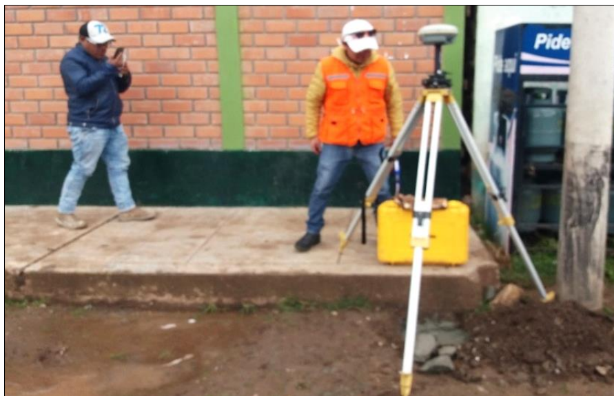
Figura 4: Trabajos topográficos de posicionamiento del GPS diferencial en la plaza principal de Laria
