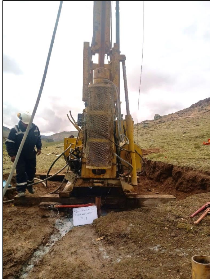
Figura 58: Punto de perforación P1
