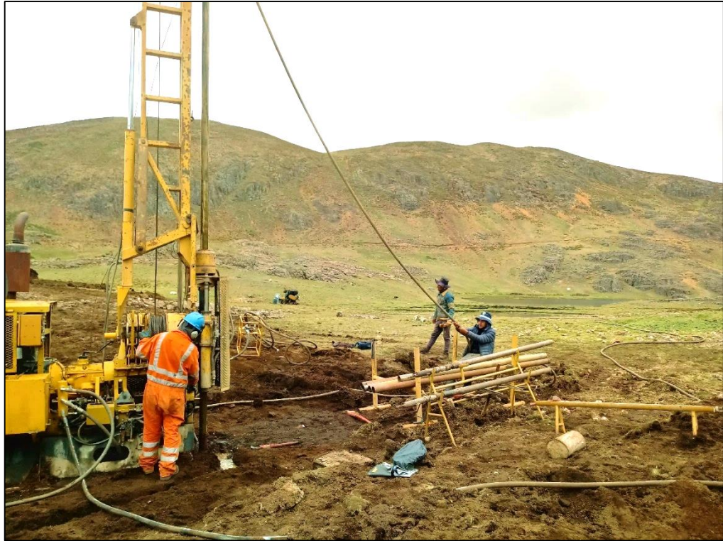
Figura 62: Punto de perforación P3
