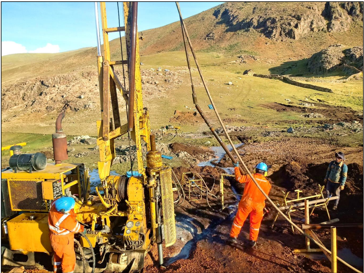
Figura 61: Punto de perforación P2.
