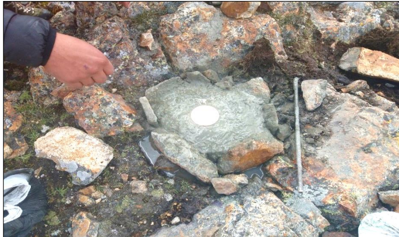
Figura 5: Trabajos topográficos. Monumentado de puntos geodésicos
