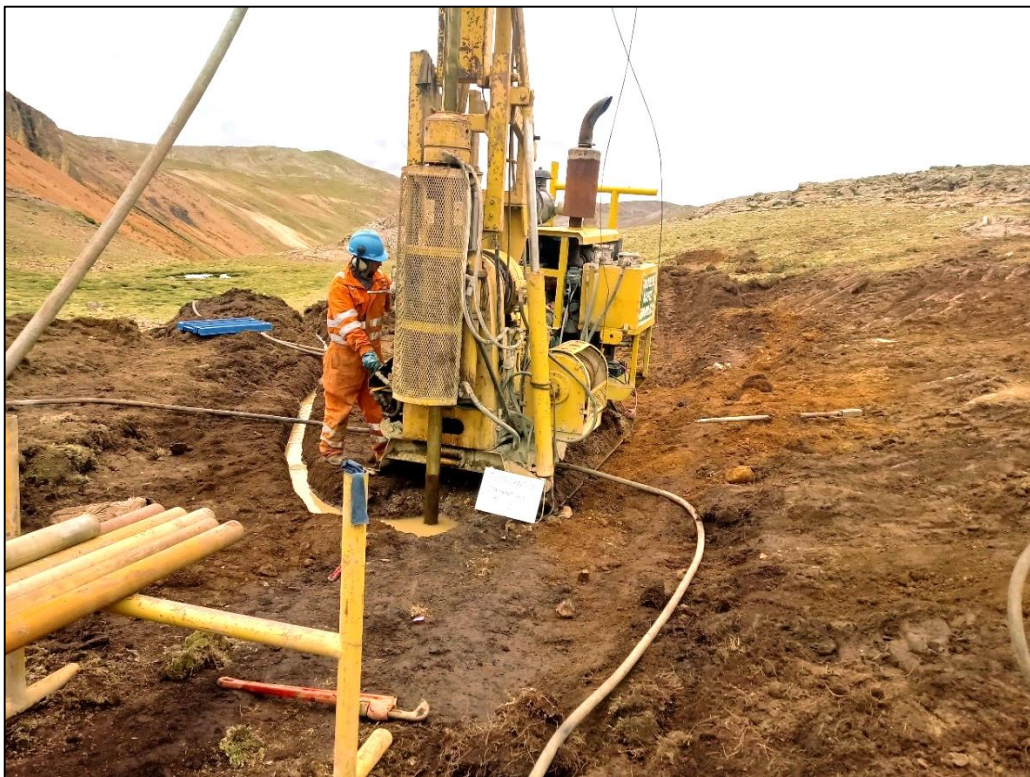
Figura 63: Punto de perforación P3
