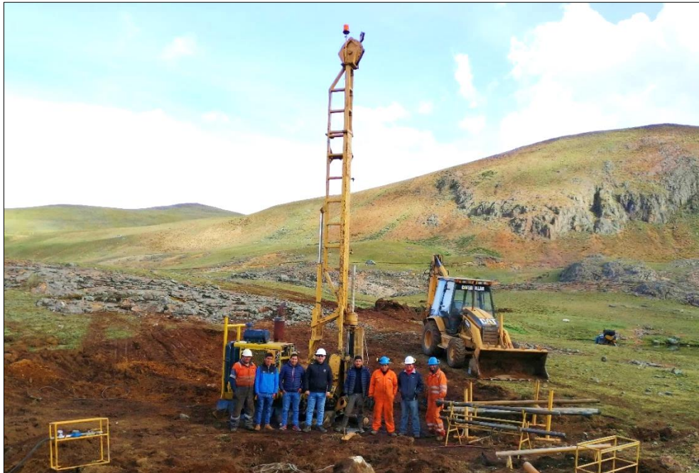
Figura 56: Punto de perforación P1
