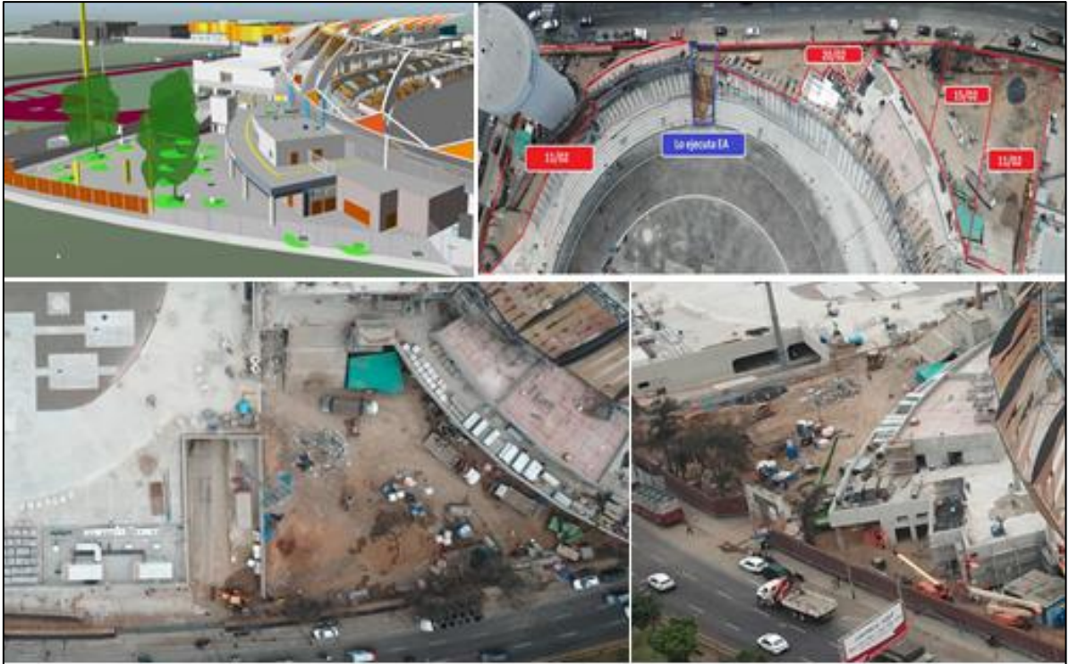
Figura 65: Comparación de las herramientas BIM y fotografías a tiempo real con el avance de obra en sector 2 fase 2
