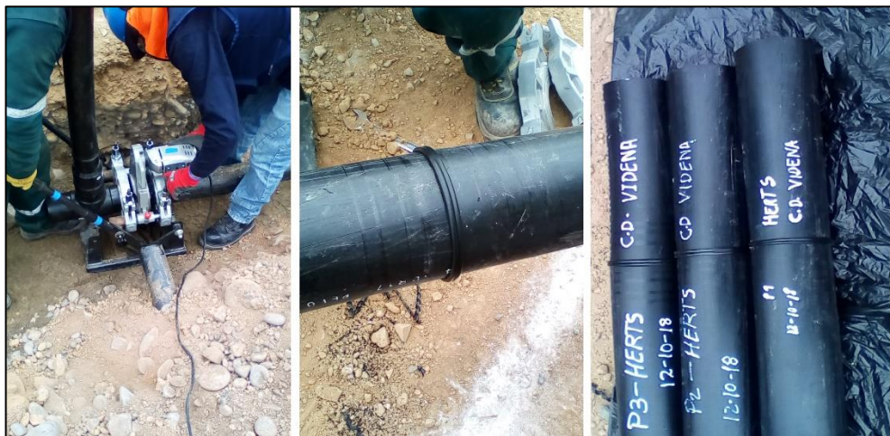
Figura 109: Inspección de tuberías termofusionadas
