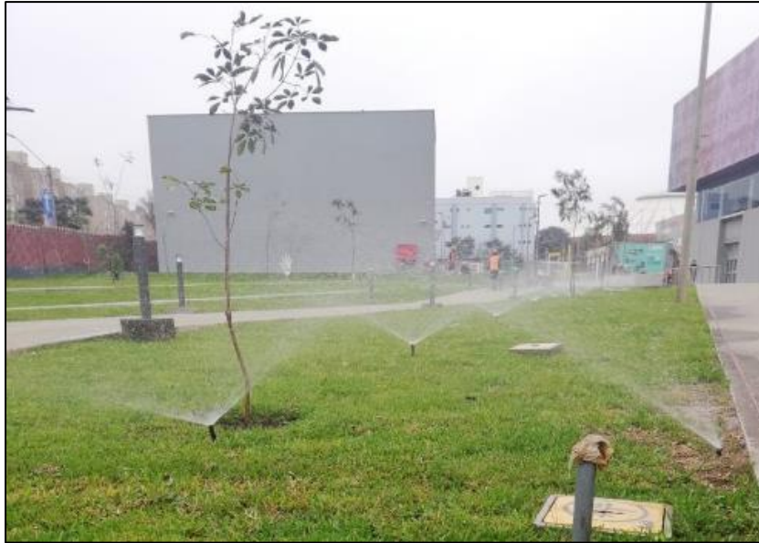
Figura 19: Riego por aspersión Obras Exteriores Zona A
