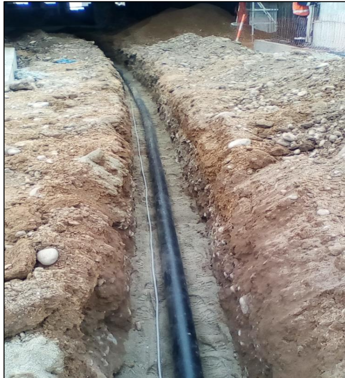
Figura 16: Instalación de manguera HDPE sobre cama de arena en obras exteriores
