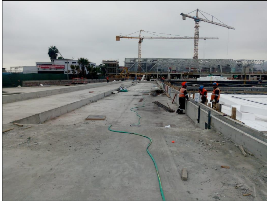
Figura 32: Instalación de tuberías HDPE en estadio de calentamiento
