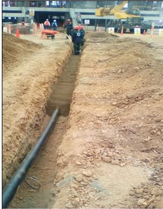
Figura 17: Instalación de manguera HDPE tapado con cama de arena en obras exteriores
