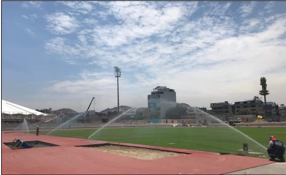
Figura 35: Prueba de emisores de riego en estadio de atletismo
