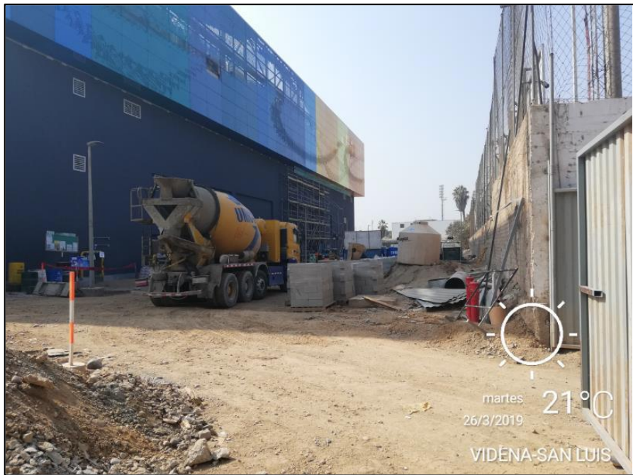
Figura 59: Frentes de trabajo en el sector 1 fase 2 con restricciones de ingreso
