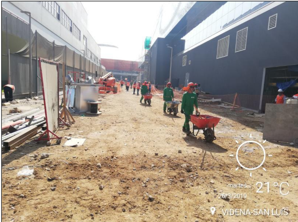
Figura 60: Frentes de trabajo en el sector 1 fase 2 con restricciones de ingreso
