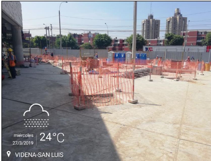
Figura 75: Frentes de trabajo en el sector 2 fase 2 con restricciones de ingreso
