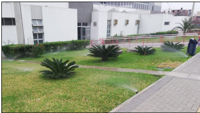
Figura 20: Riego por aspersión Obras Exteriores Zona A
