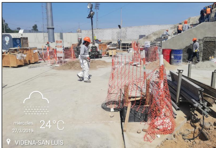
Figura 76: Frentes de trabajo en el sector 2 fase 2 con restricciones de ingreso
