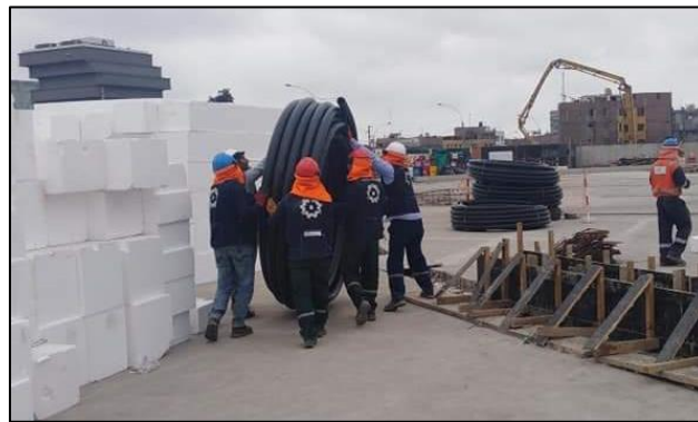
Figura 30: Movilización de tuberías HDPE para instalación en estadio de calentamiento
