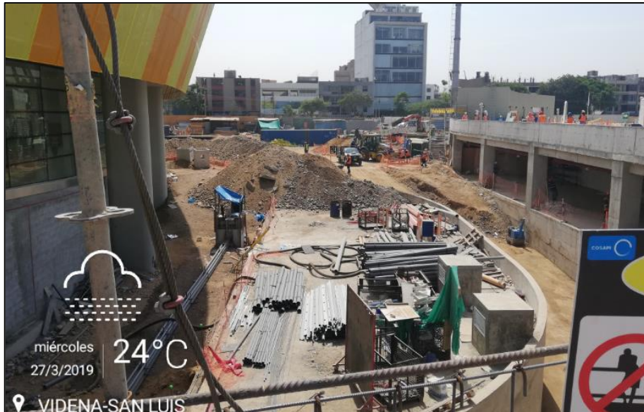
Figura 82: Frentes de trabajo en el sector 4 fase 2 con restricciones de ingreso
