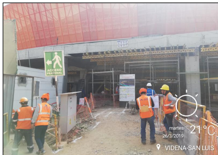
Figura 87: Frentes de trabajo en el sector 6 fase 2 con restricciones de ingreso
