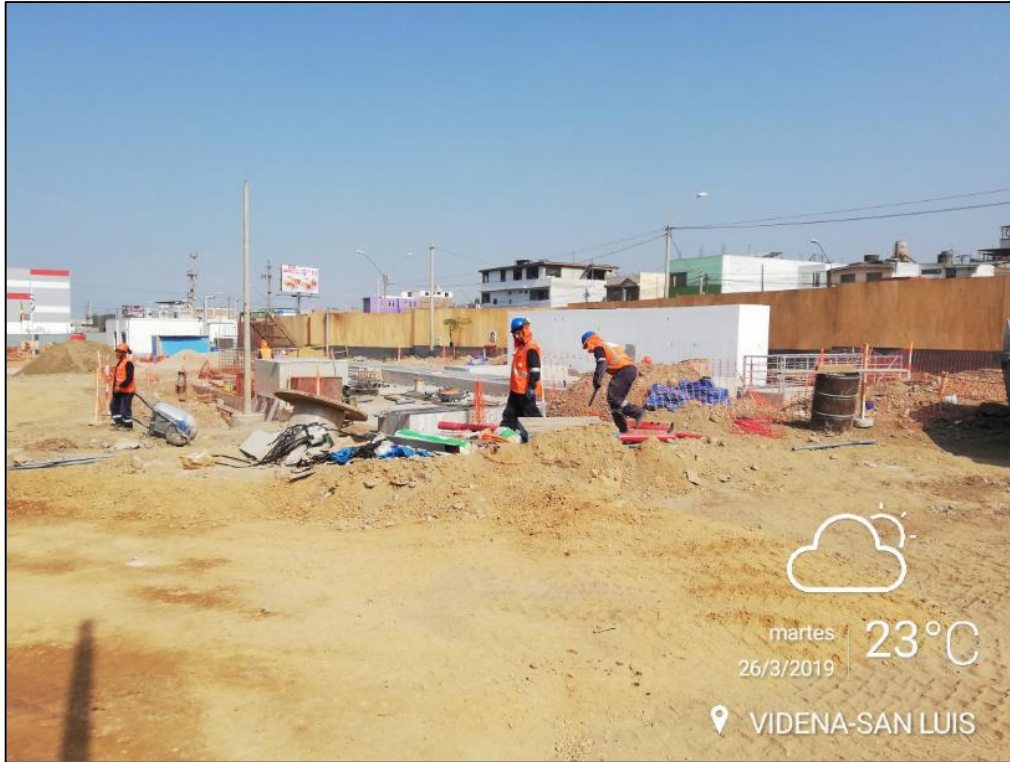
Figura 92: Frentes de trabajo en el sector 1 fase 5 con restricciones de ingreso
