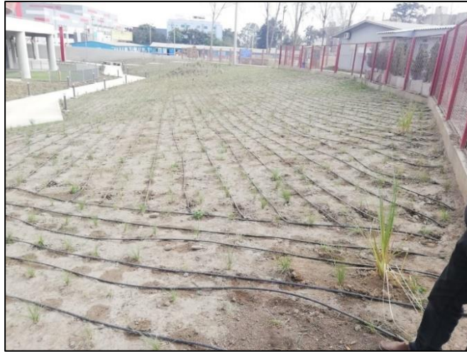
Figura 23: Riego por goteo obras exteriores zona B
