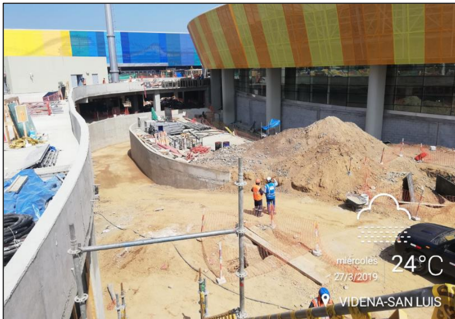
Figura 81: Frentes de trabajo en el sector 4 fase 2 con restricciones de ingreso
