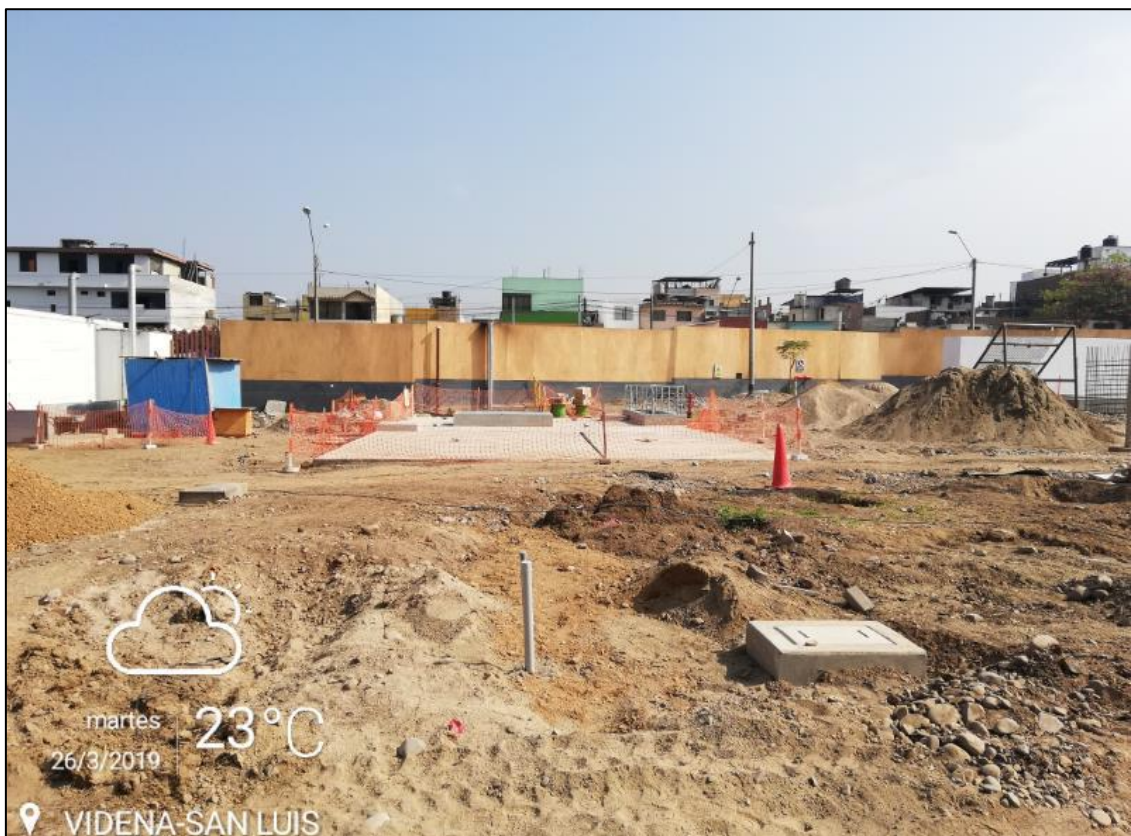
Figura 91: Frentes de trabajo en el sector 1 fase 5 con restricciones de ingreso
