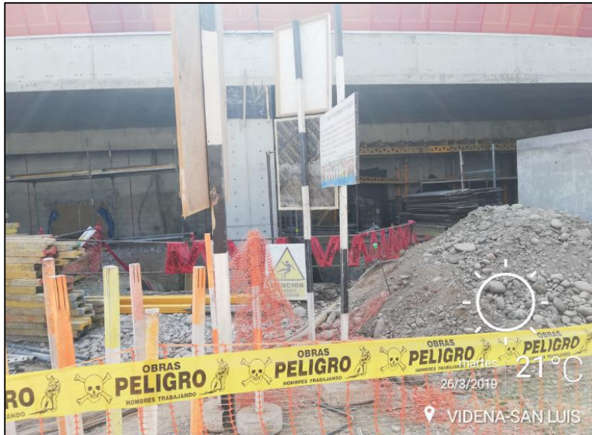
Figura 86: Frentes de trabajo en el sector 6 fase 2 con restricciones de ingreso
