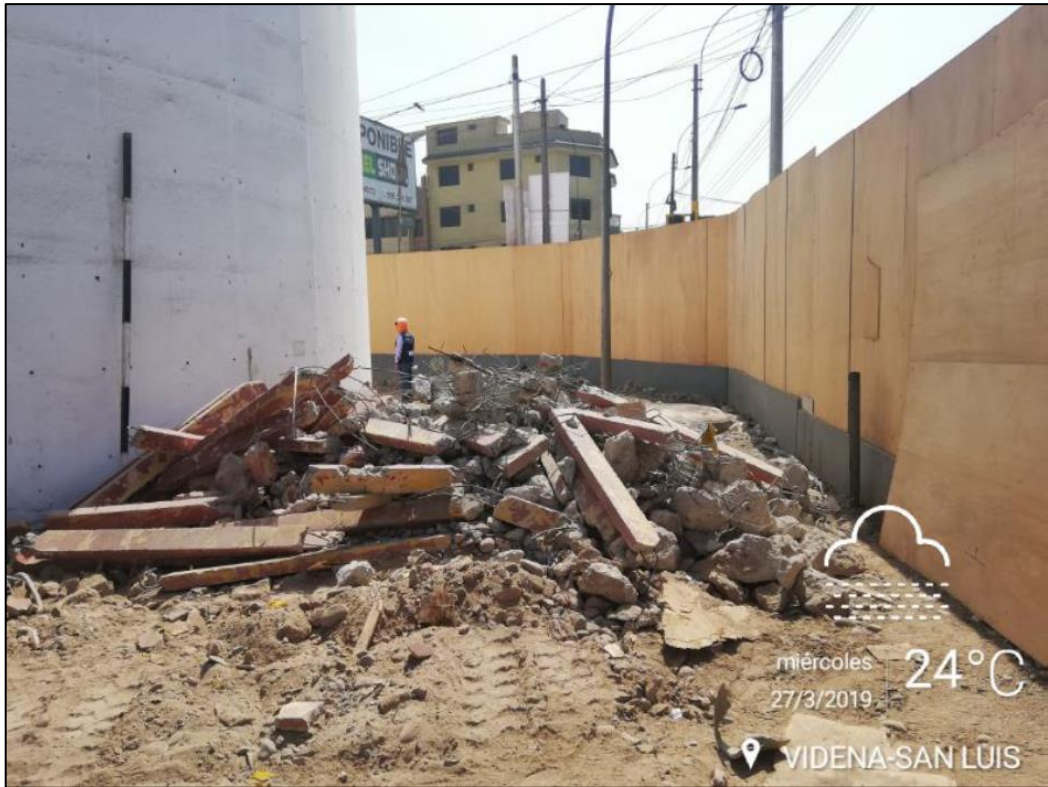
Figura 71: Frentes de trabajo en el sector 2 fase 2 con restricciones de ingreso
