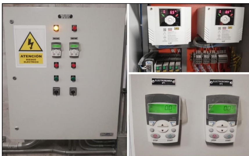
Figura 111: Inspección de tableros eléctricos
