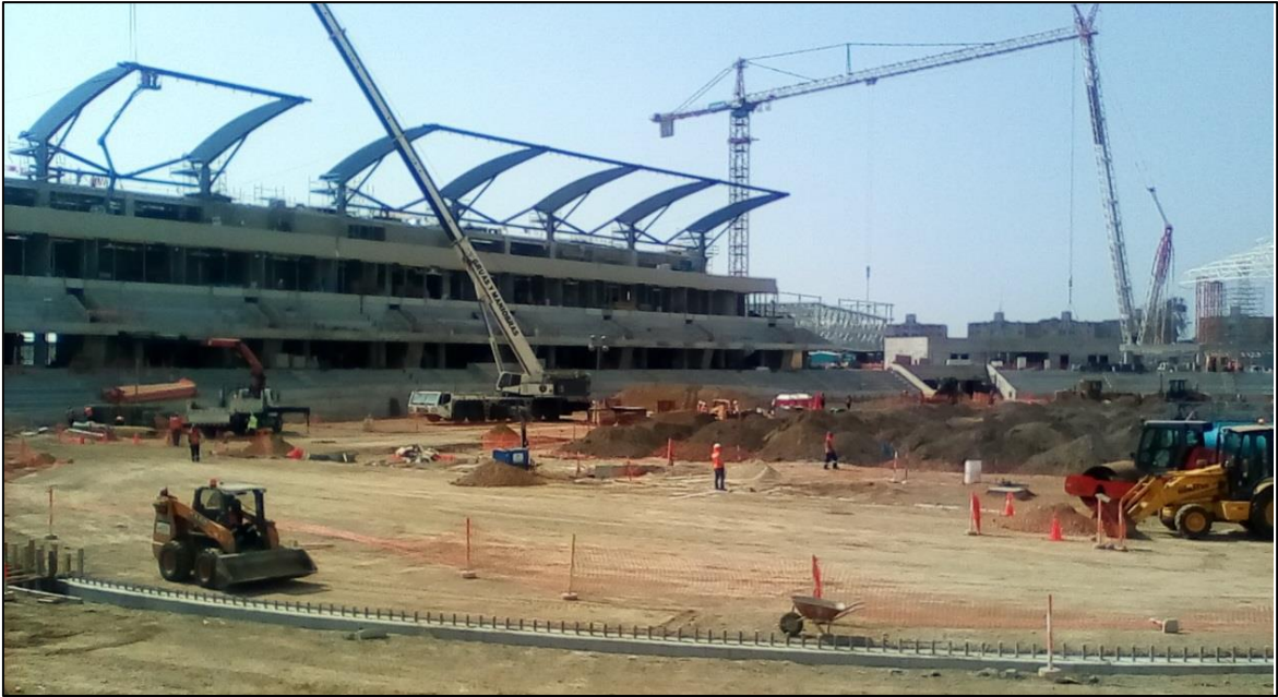
Figura 8: Trabajos en Estadio de Atletismo
