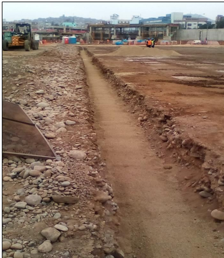
Figura 18: Compactación y cierre de zanja en obras exteriores
