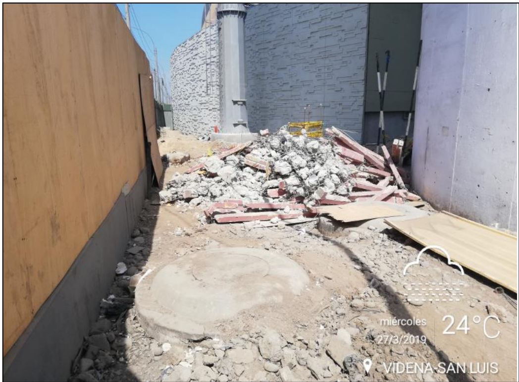
Figura 72: Frentes de trabajo en el sector 2 fase 2 con restricciones de ingreso
