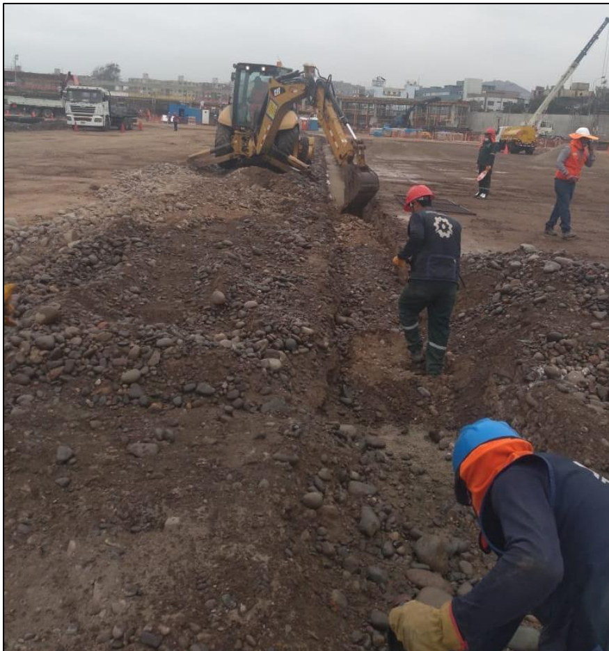
Figura 33: Instalación de tuberías HDPE en estadio de atletismo
