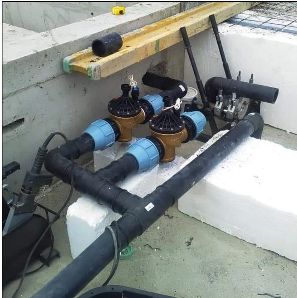
Figura 34: Instalación de válvulas de riego en estadios
