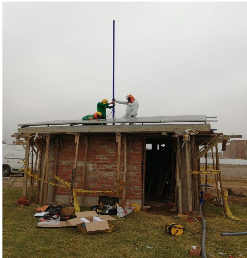
Figura 27: Instalación de tuberías SCH40 2" en pozo profundo.
