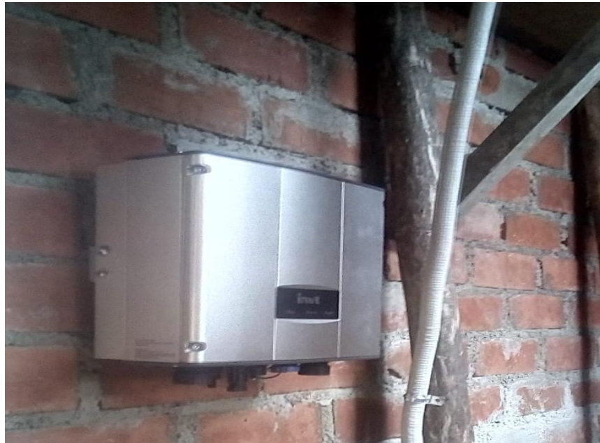
Figura 28: Instalación inversor o controlador.
