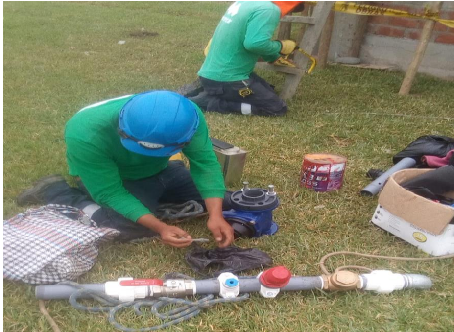
Figura 30: Instalación de válvulas en árbol de descarga de pozo.
