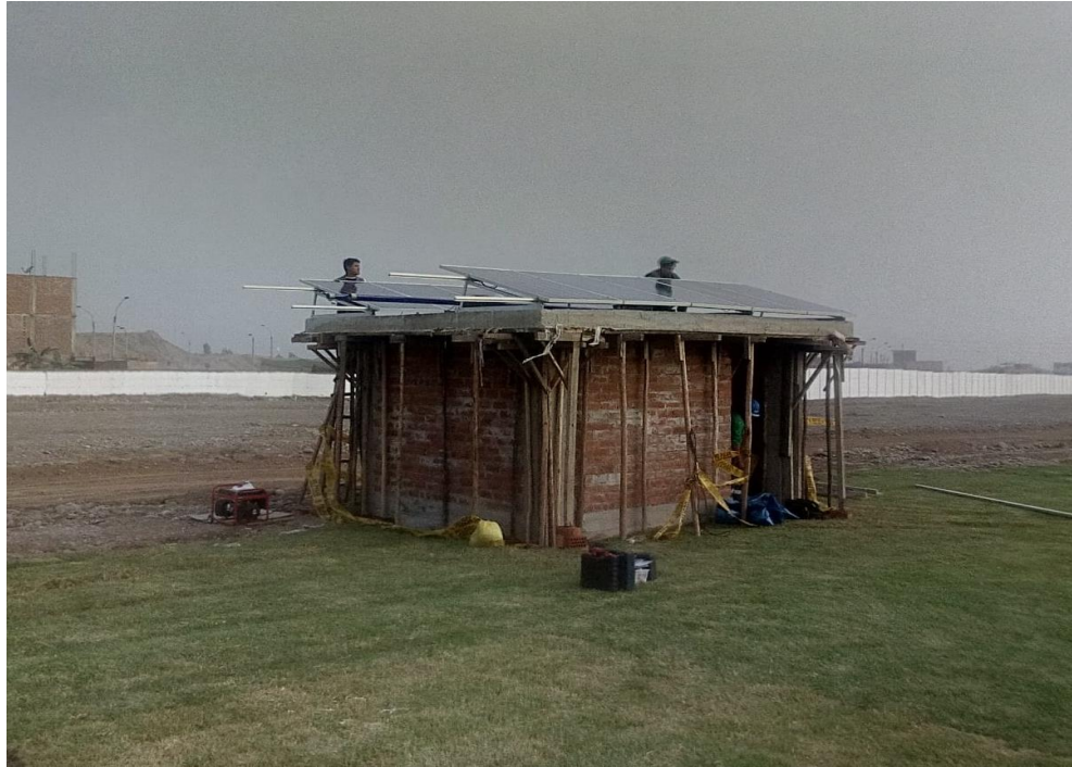
Figura 22: Instalación de 10 unidades paneles solares.
