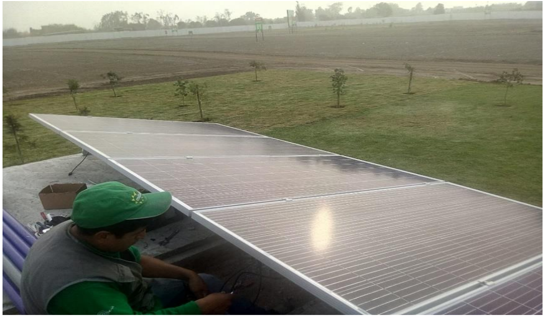
Figura 20: Instalación de 05 paneles frontales.
