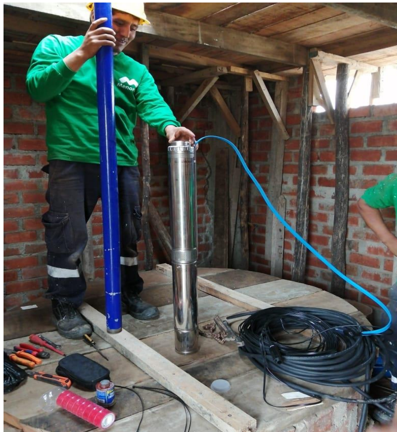
Figura 25: Instalación de electrobomba sumergible.
