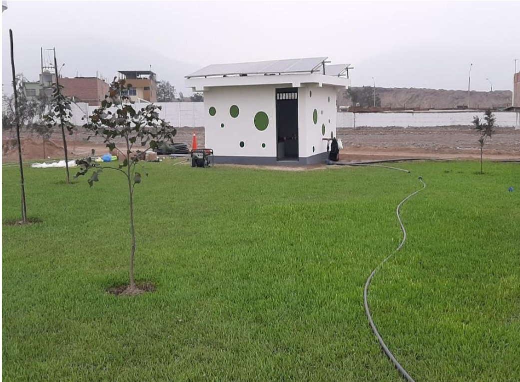
Figura 32: Caseta de pozo con sistema de bombeo fotovoltaico.
