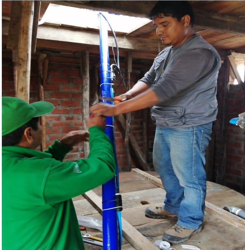
Figura 26: Instalación de cable eléctrico para conexión controlador-electrobomba.
