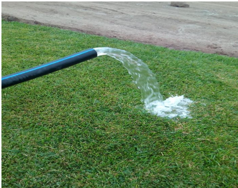
Figura 34: Prueba de bombeo de electrobomba sumergible.
