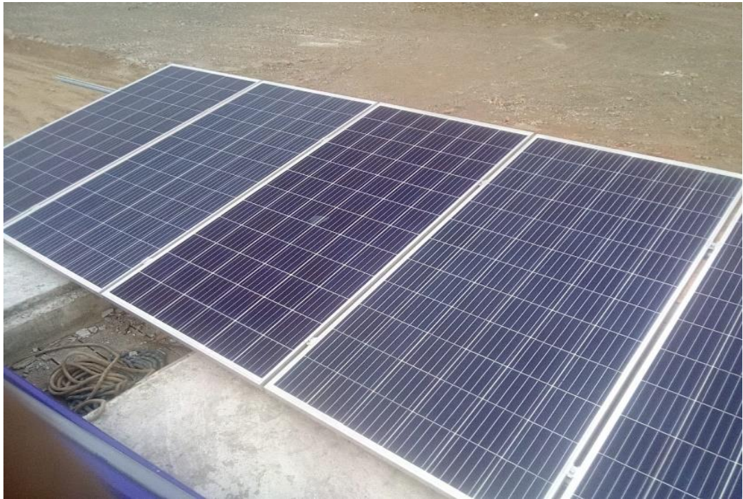
Figura 21: Instalación de 05 paneles posteriores.
