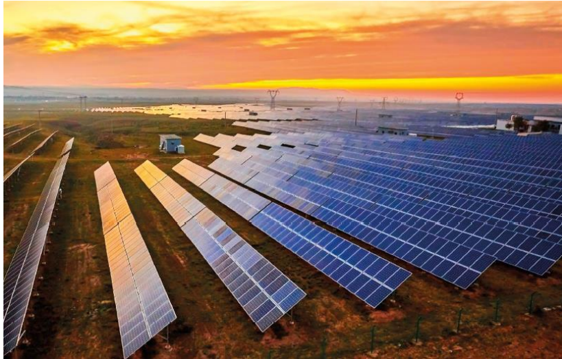
Figura 14: Planta solar fotovoltaica, Villa Bush Bolivia.
