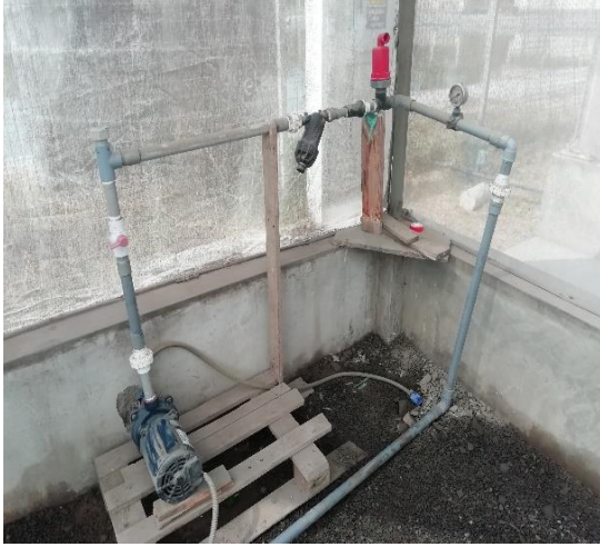
Instalación del sistema de riego
