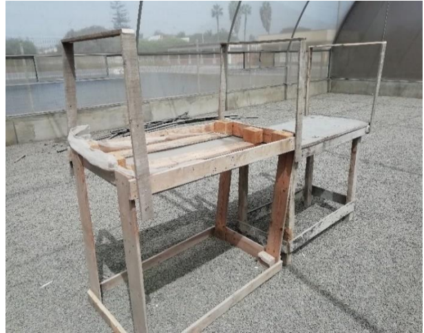
Construcción de almaciguera
