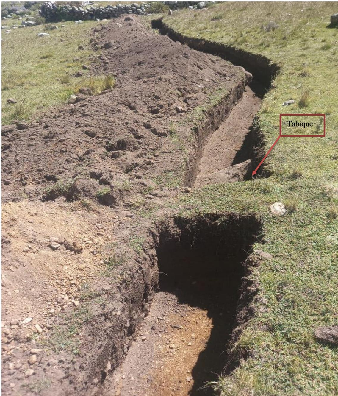
**Figura 4: Perfil longitudinal de una zanja de infiltración**
