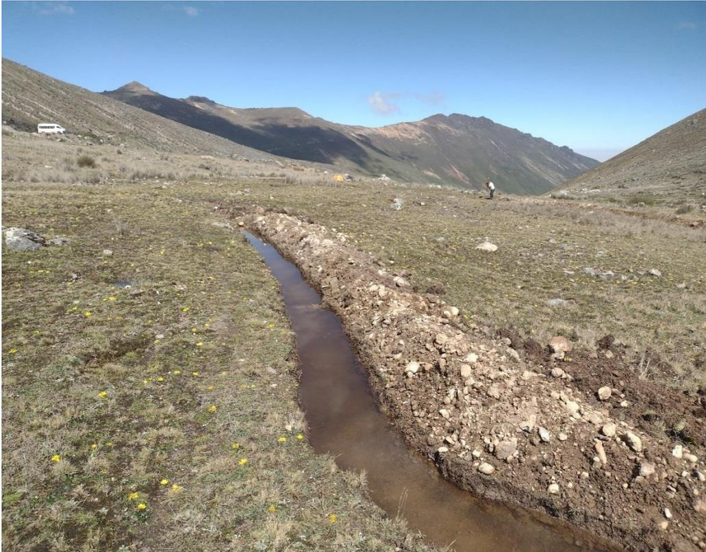
**Figura 29: Zanja de infiltración con bordo superior**
