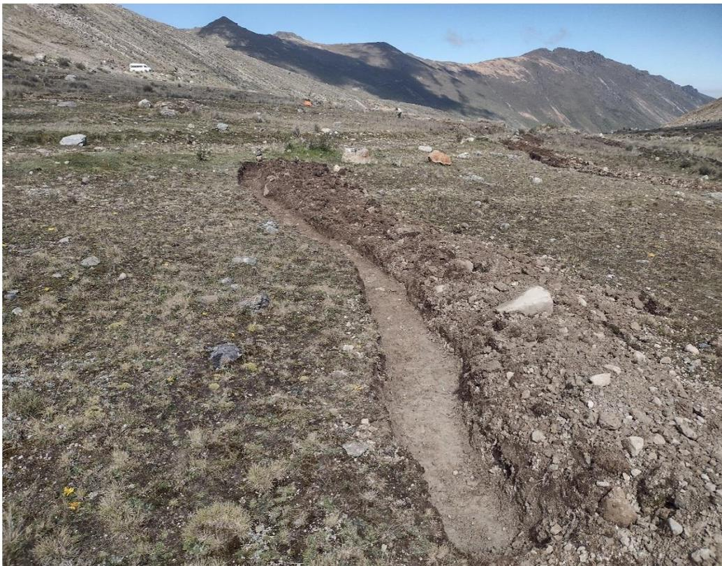
**Figura 30: Zanjas de infiltración en funcionamiento en la localidad de Shulluqocha**
