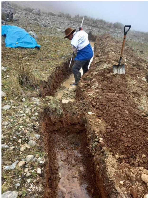
**Figura 28: Excavación de zanjas de infiltración**
