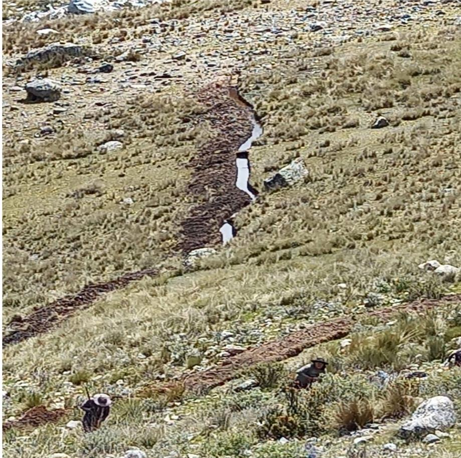
**Figura 25: Zanjas de infiltración en funcionamiento**
