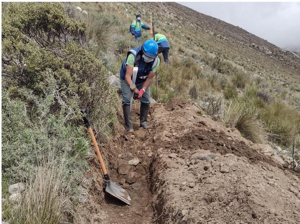
**Figura 17: Trazo de zanja de infiltración con nivel A**
