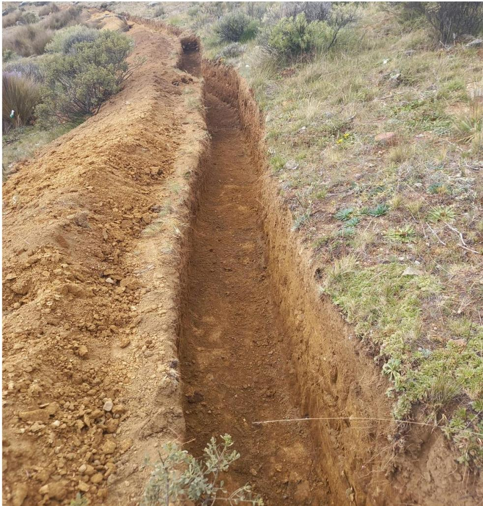
**Figura 14: Bordo inferior de la zanja de infiltración**
