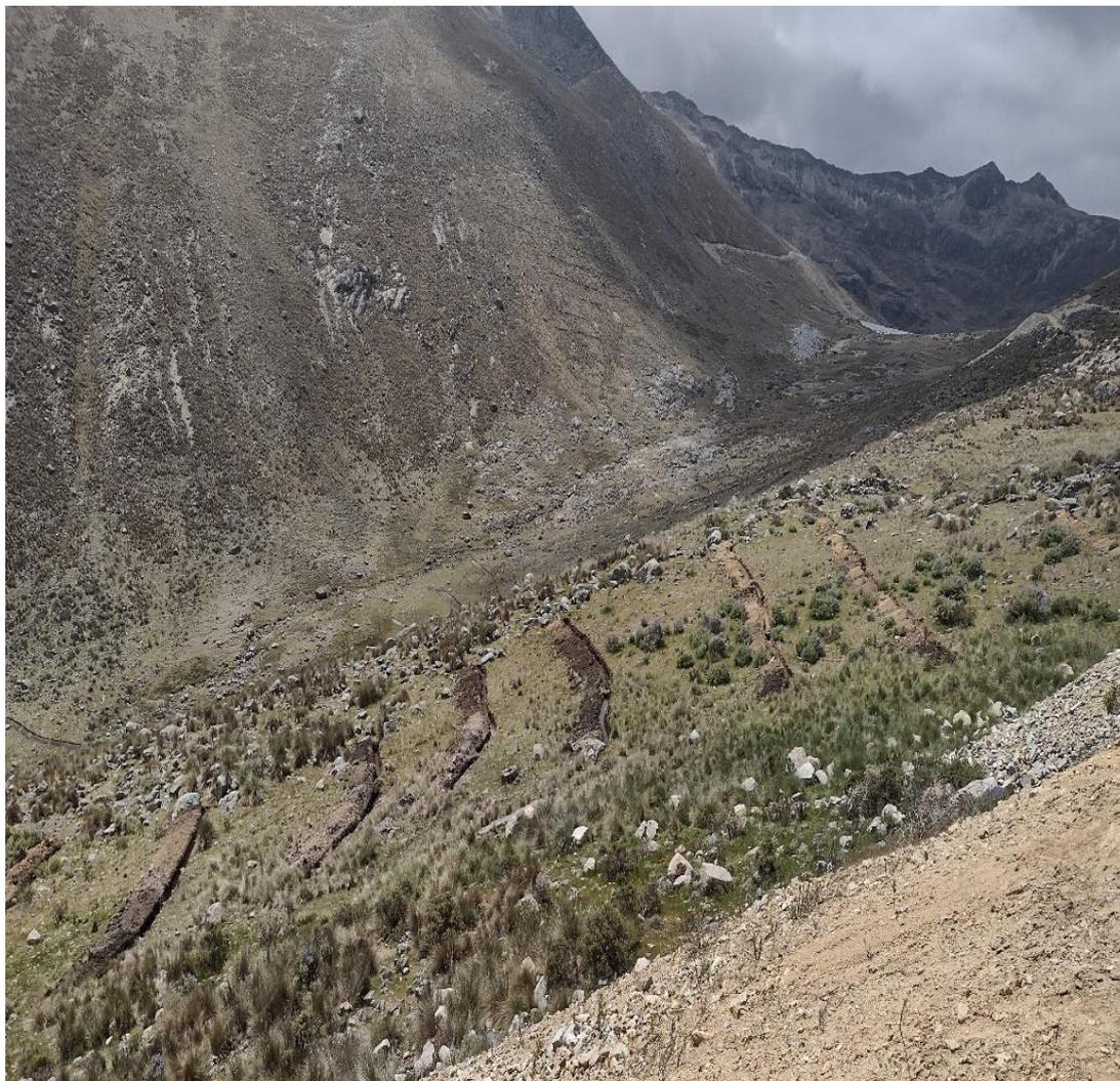
**Figura 13: Distanciamiento de zanjas de infiltración en la ladera de Shulluqocha**
