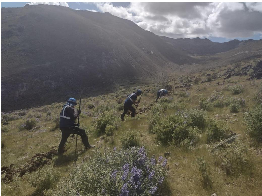
**Figura 20: Trabajo de excavación de zanjas de infiltración**
