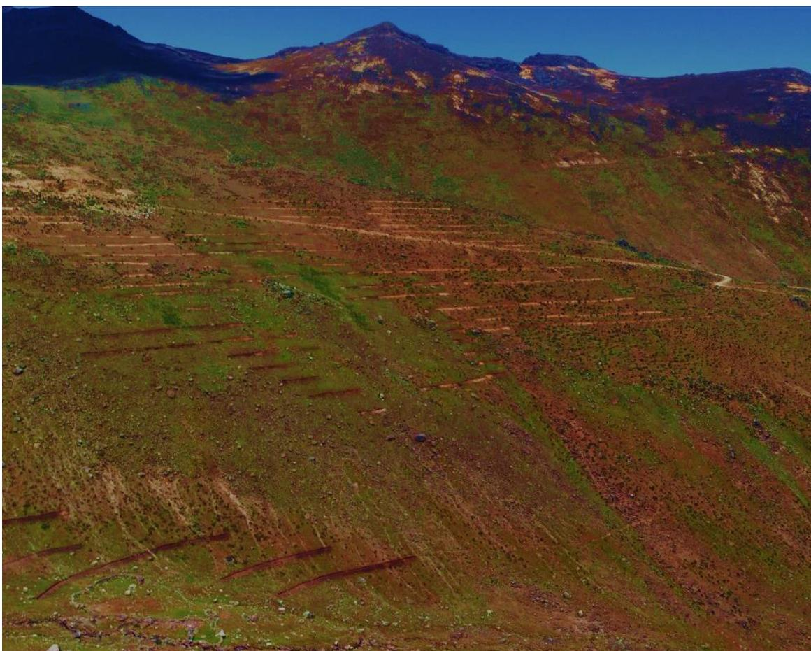
**Figura 3: Área tratada con zanjas de infiltración en Shulluqocha**
