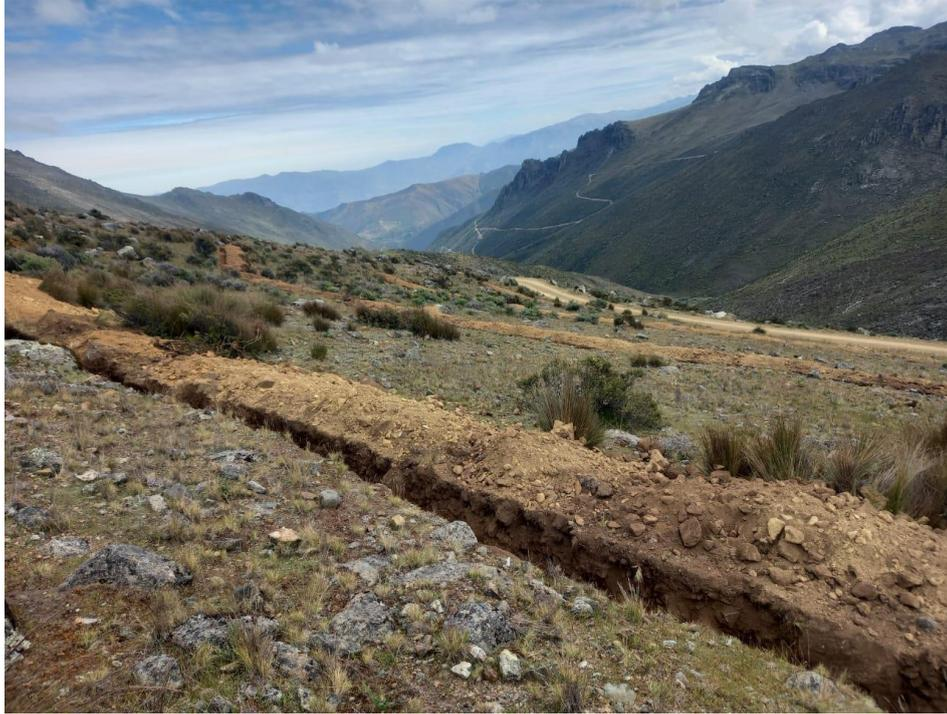
**Figura 21: Nivelación de borde en la zanja de infiltración**
