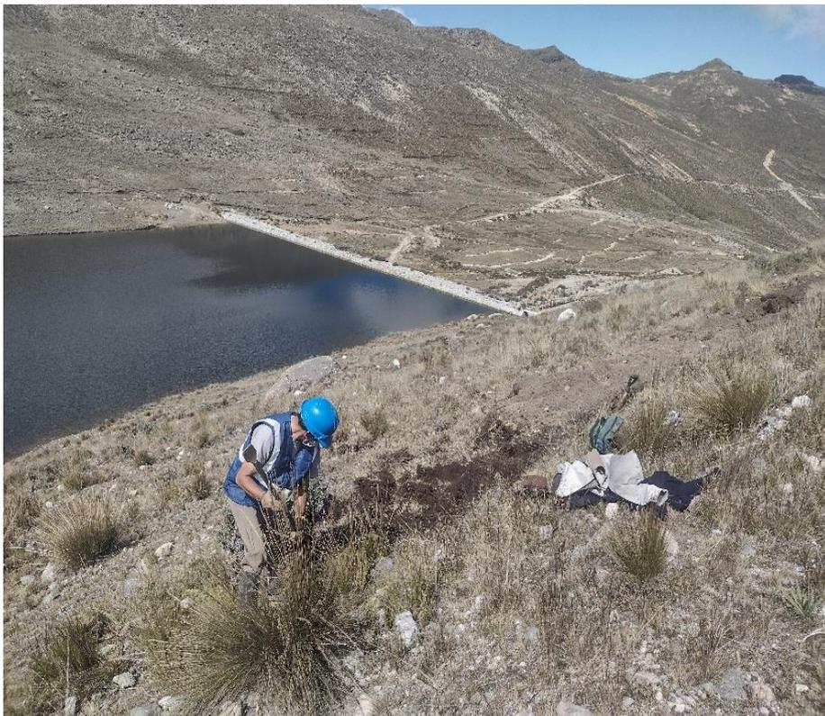
**Figura 26: Trabajo de excavación para la construcción de zanjas de infiltración**
