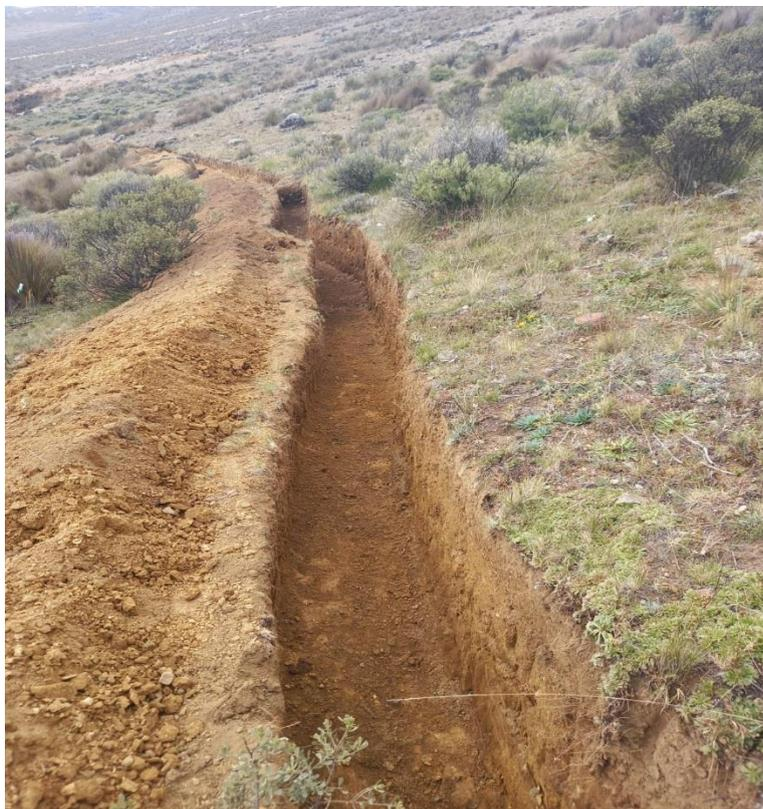
**Figura 24: Borde inferior con material extraído de la zanja de infiltración**
