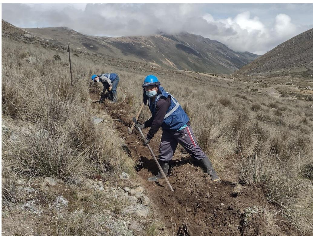
**Figura 18: Trabajo de excavación de zanjas de infiltración**
