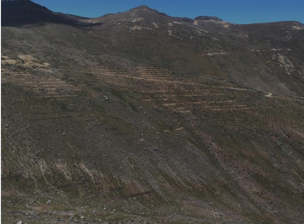
**Figura 32: Zanjas de infiltración en ladera izquierda**
