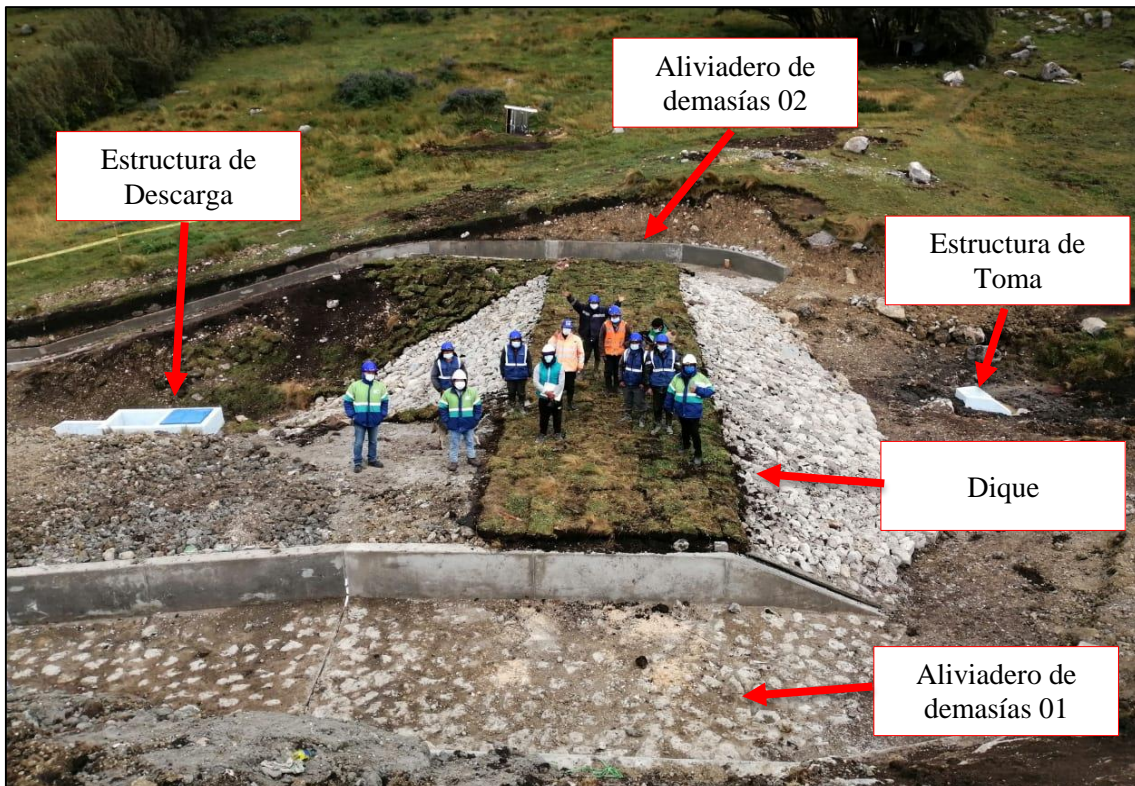
Figura 2: Metas físicas de la Qocha Ulimpampa 01
