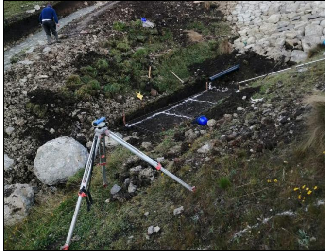
Figura 42: Perfilado y compactado de la rasante de la obra de descarga
