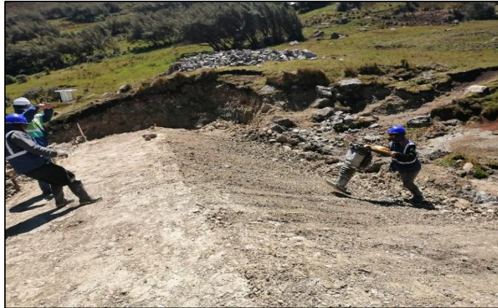
Figura 34: Refine de los taludes del dique
