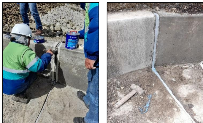
Figura 53: Colocación de juntas de dilatación
