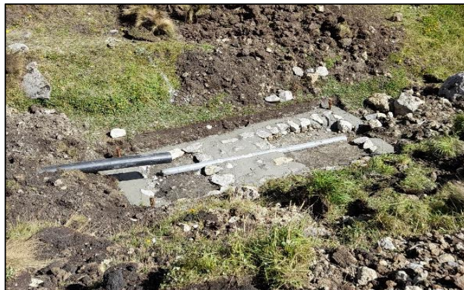
Figura 43: Colocación de tubería de drenaje en obra de descarga
