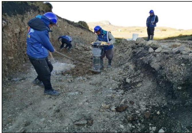
Figura 49: Compactación del fondo del aliviadero 01
