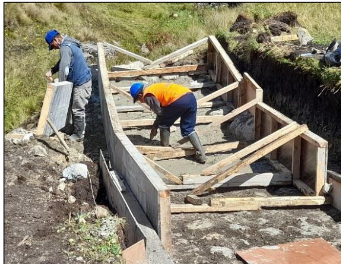
Figura 52: Encofrado de los muros del aliviadero 01
