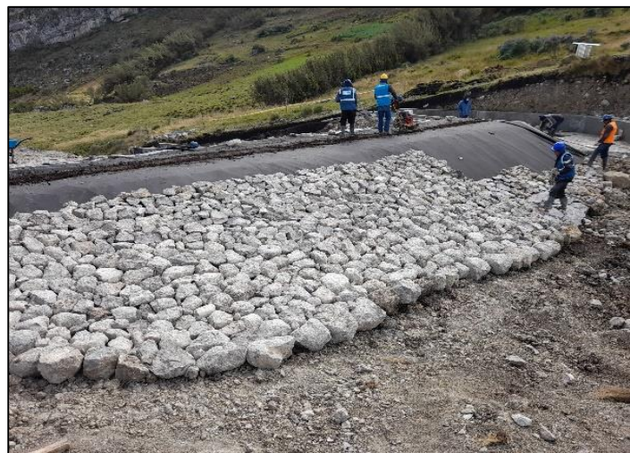
Figura 36: Conformación del espaldón con piedra – cara húmeda
