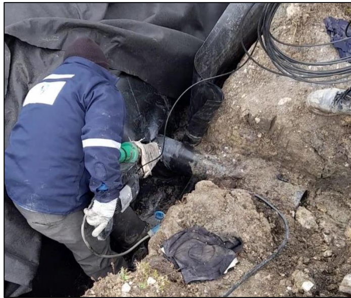
Figura 41: Termofusión entre tubería y geomembrana
