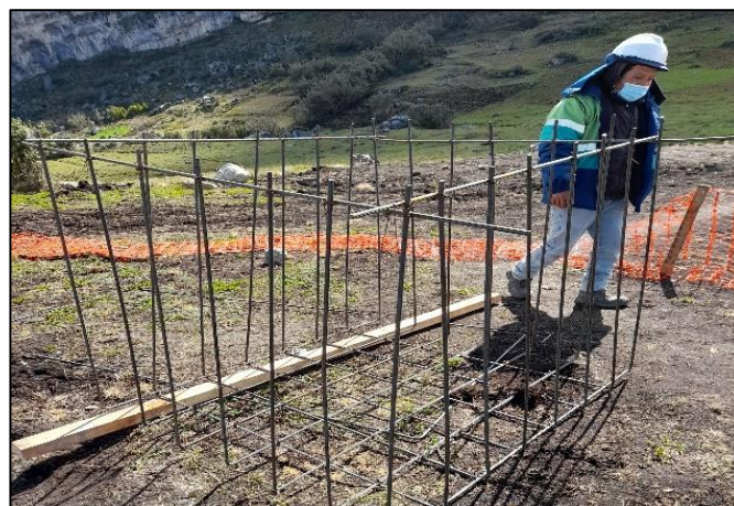
Figura 44: Refuerzos de acero para la caja de válvula
