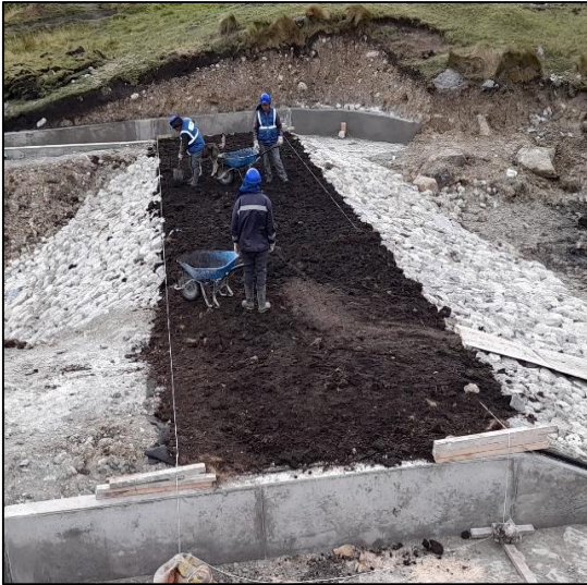
Figura 37: Colocación de tierra orgánica y champas en la corona del dique
