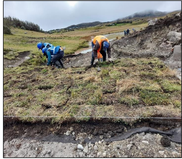
Figura 37: Colocación de tierra orgánica y champas en la corona del dique
