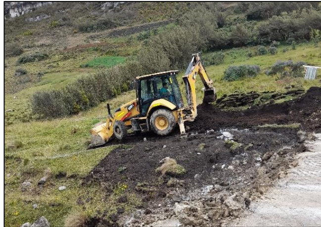
Figura 48: Excavación de la rasante del aliviadero 01
