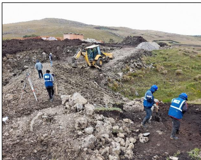
Figura 33: Perfilado de los taludes del dique
