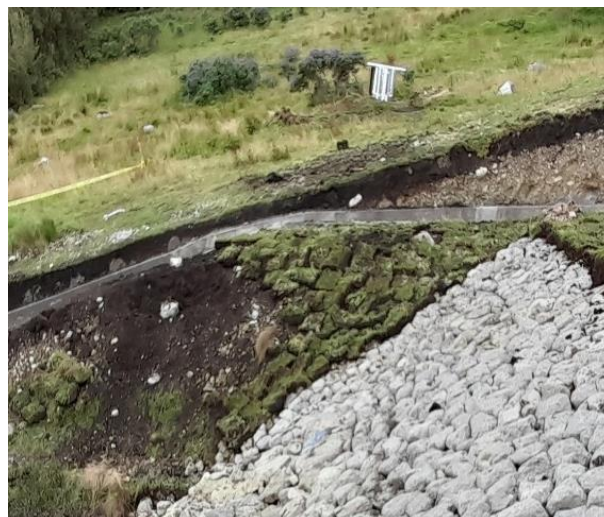
Figura 20: Restauración con champa de áreas afectadas
