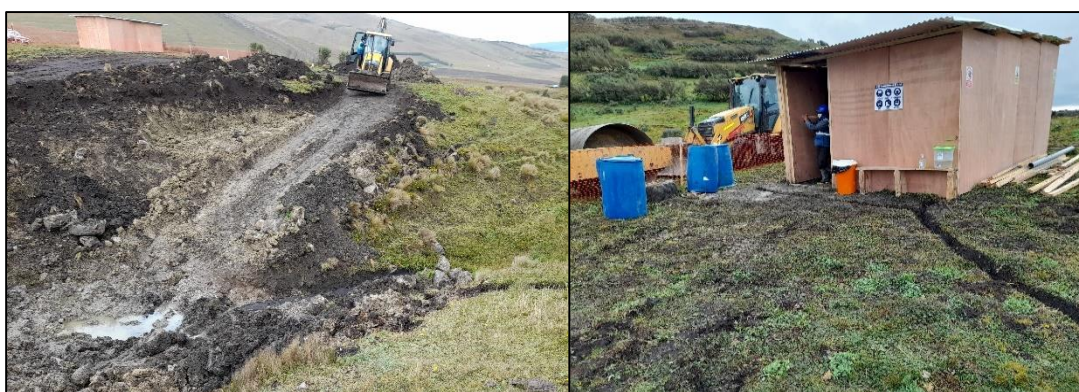
Figura 22: Instalación de almacén de obra
