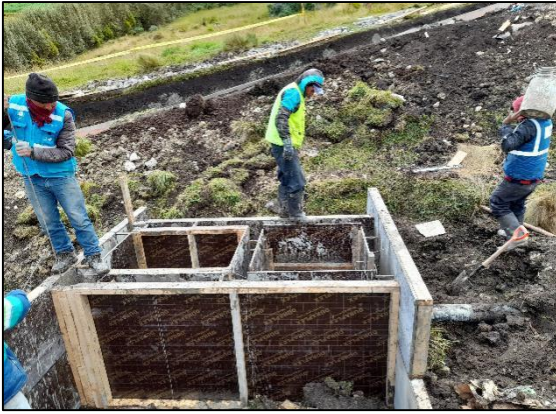
Figura 45: Encofrado de la obra de toma y descarga
