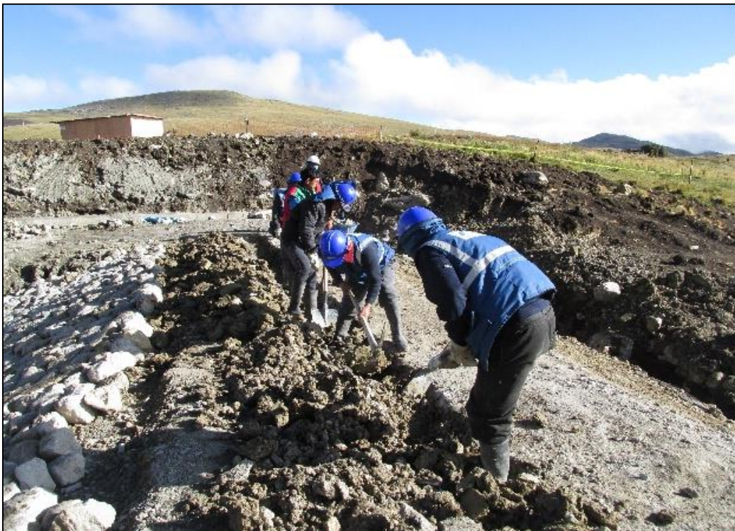
Figura 28: Excavación manual - Zanja de anclaje en la corona del Dique
