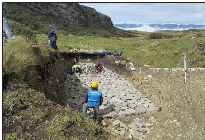
Figura 50: Asentado de piedra en el fondo del aliviadero 01
