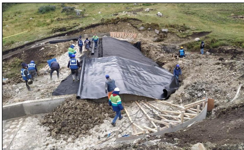
Figura 39: Instalación de geomembrana de HDPE e= 1mm
