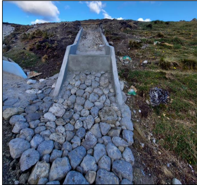
Figura 54: Enrocado de protección a la salida del aliviadero 02
