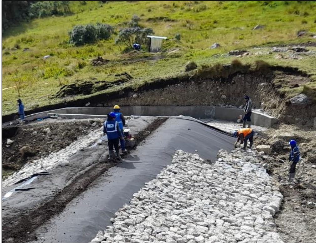
Figura 29: Relleno y compactado - Zanja de anclaje en la corona del Dique
