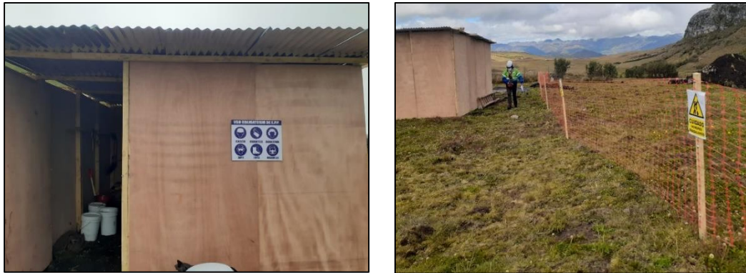
Figura 55: Señalización ambiental para obra
