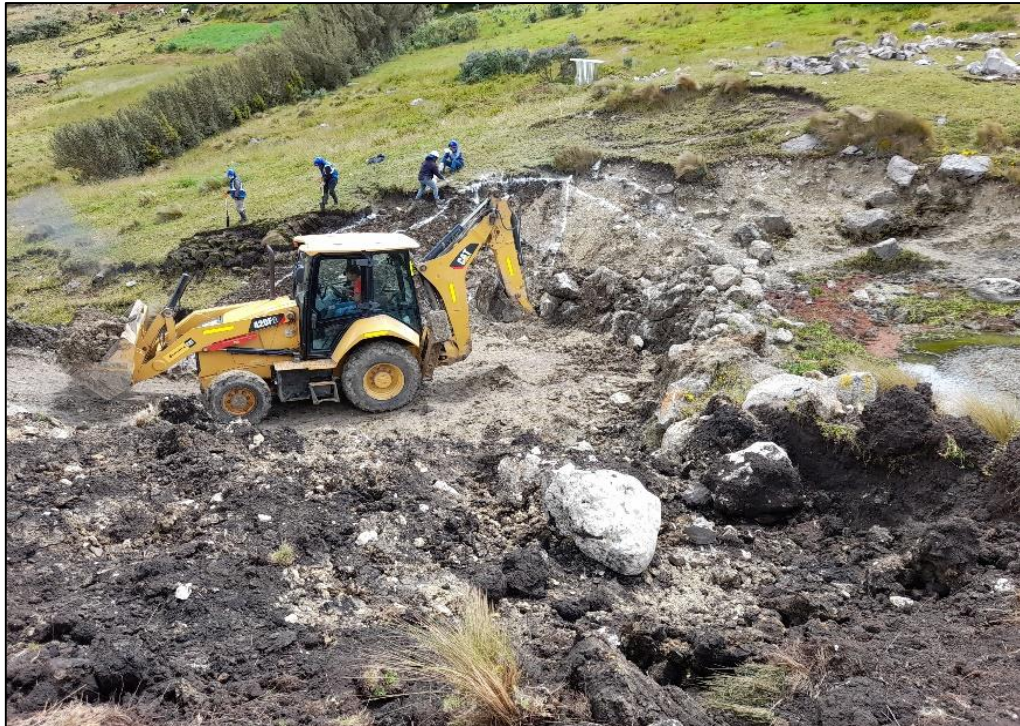
Figura 27: Excavación de material suelto c/maquinaria - Cimentación
