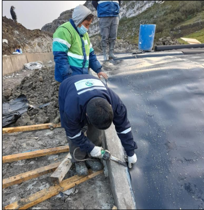
Figura 40: Termofusión entre polylock y geomembrana
