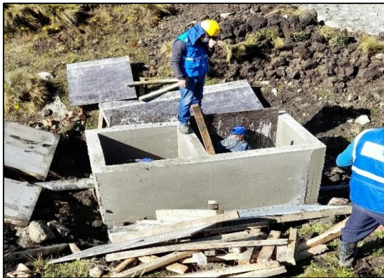
Figura 46: Desencofrado de obra de toma y descarga
