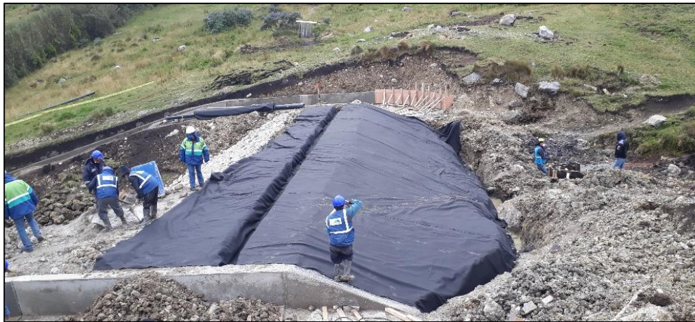
Figura 38: Instalación del geotextil no tejido de 300gr
