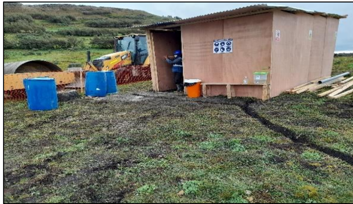
Figura 19: Señalización y contenedores en almacén de obra
