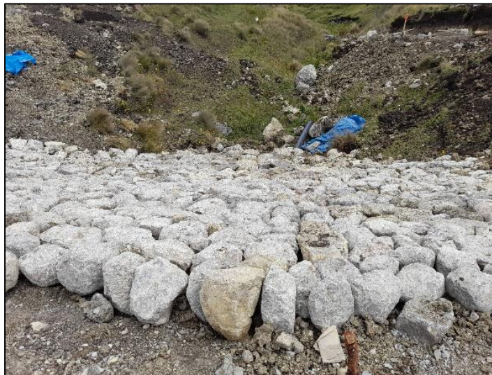
Figura 35: Conformación del espaldón con piedra – cara seca
