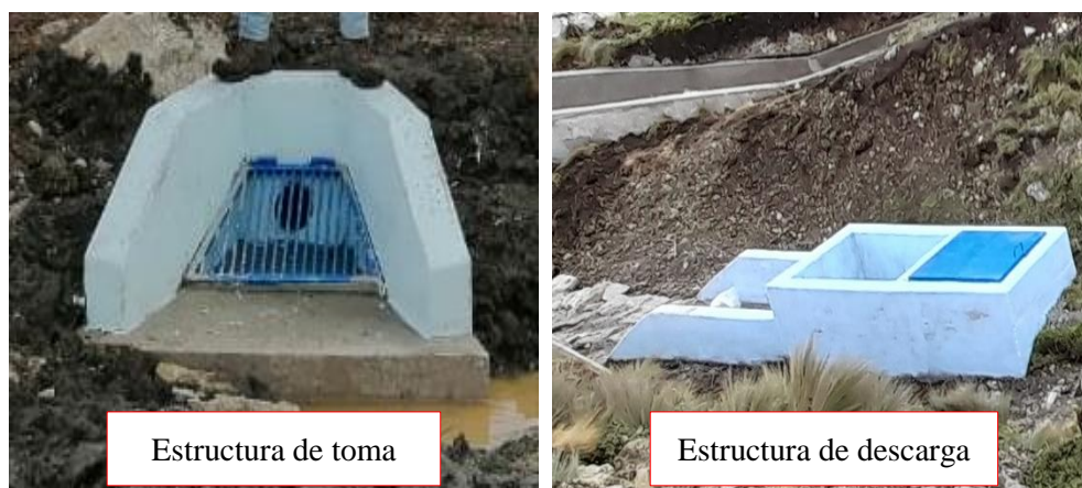
Figura 16: Estructura de toma y descarga concluida
