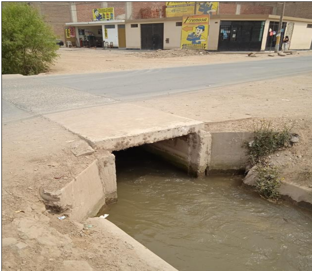
Figura 12: Puente vehicular (Pv2)
