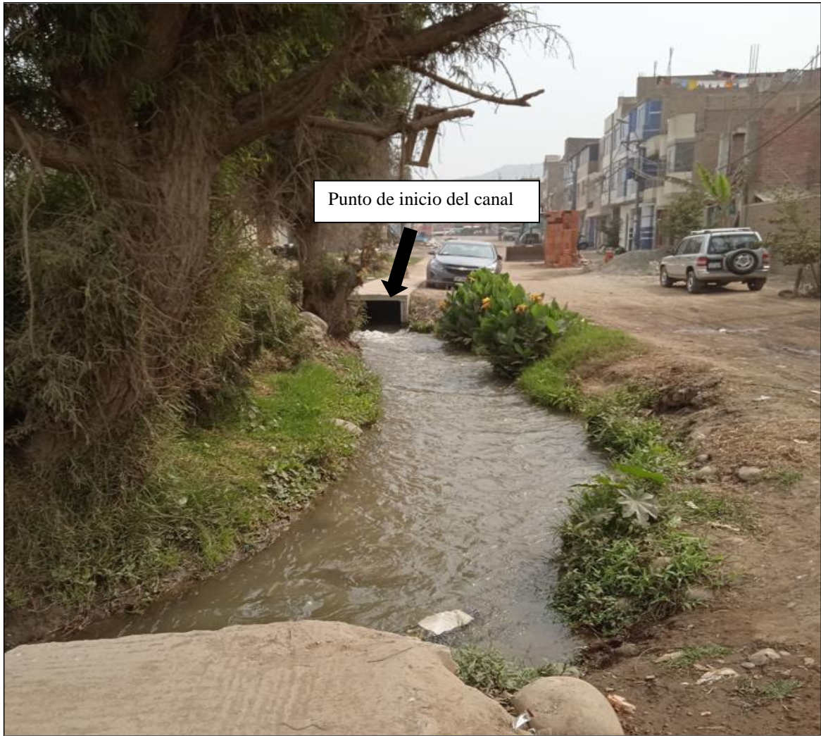
Figura 10: Punto de inicio del canal
