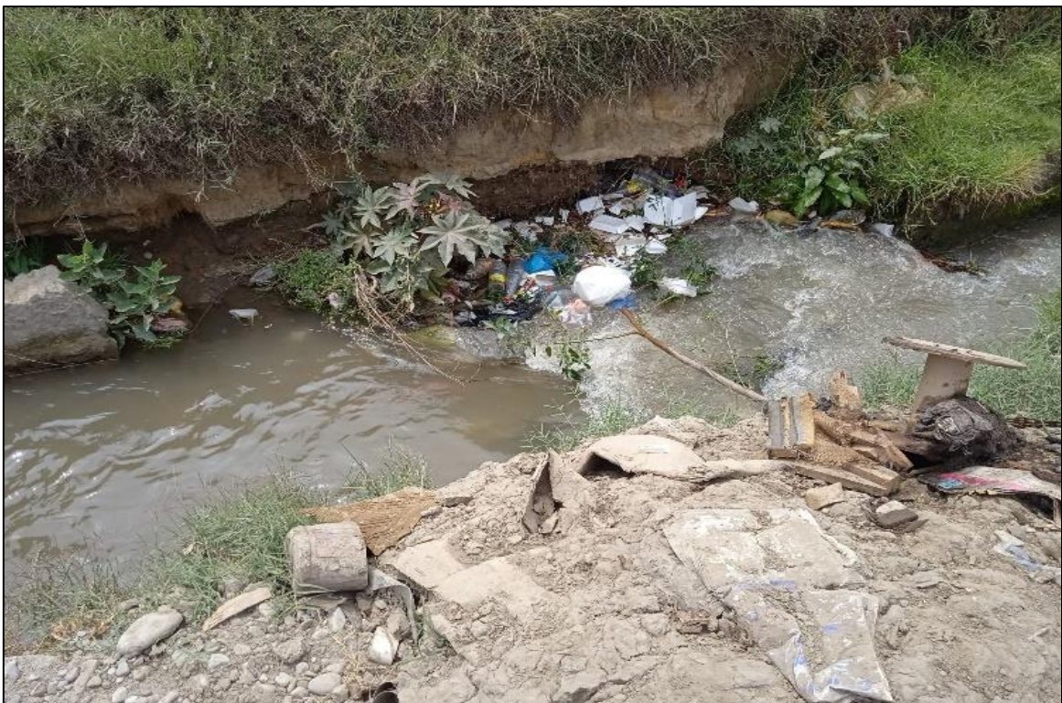
Figura 40: Estado actual del tramo del canal La Estrella
