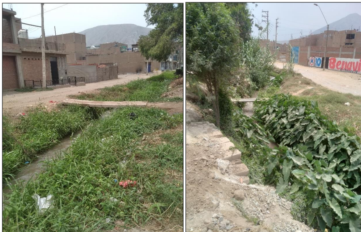
Figura 20: Estado actual del tramo del canal La Estrella
