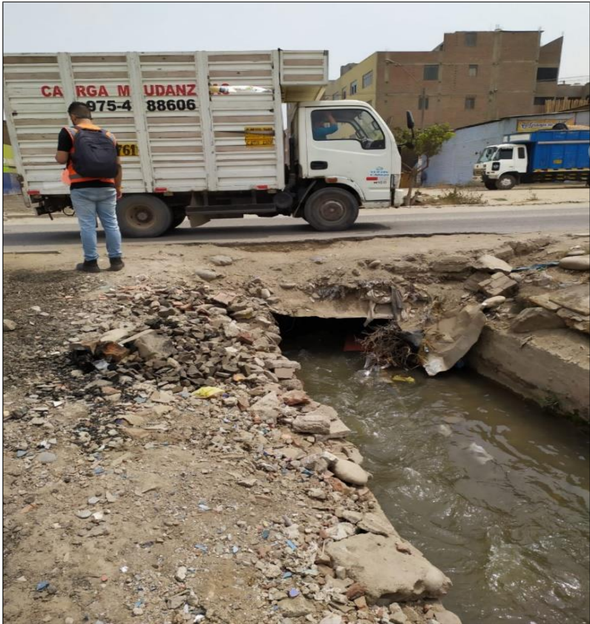
Figura 19: Vía principal - Av. Horacio Zevallos, vista aguas abajo del canal
