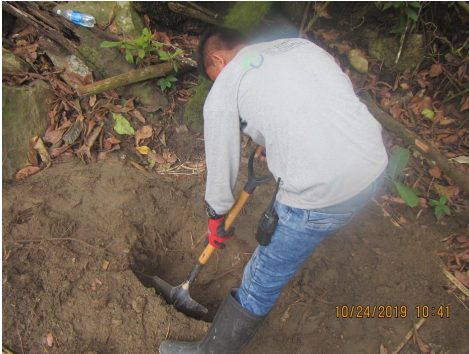
Figura 24: Preparación del terreno para la monumentación
