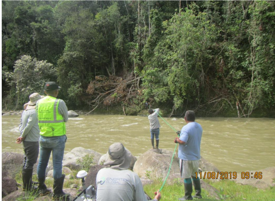
Figura 30: Instalación de cables y cuerdas. para el levantamiento batimétrico
