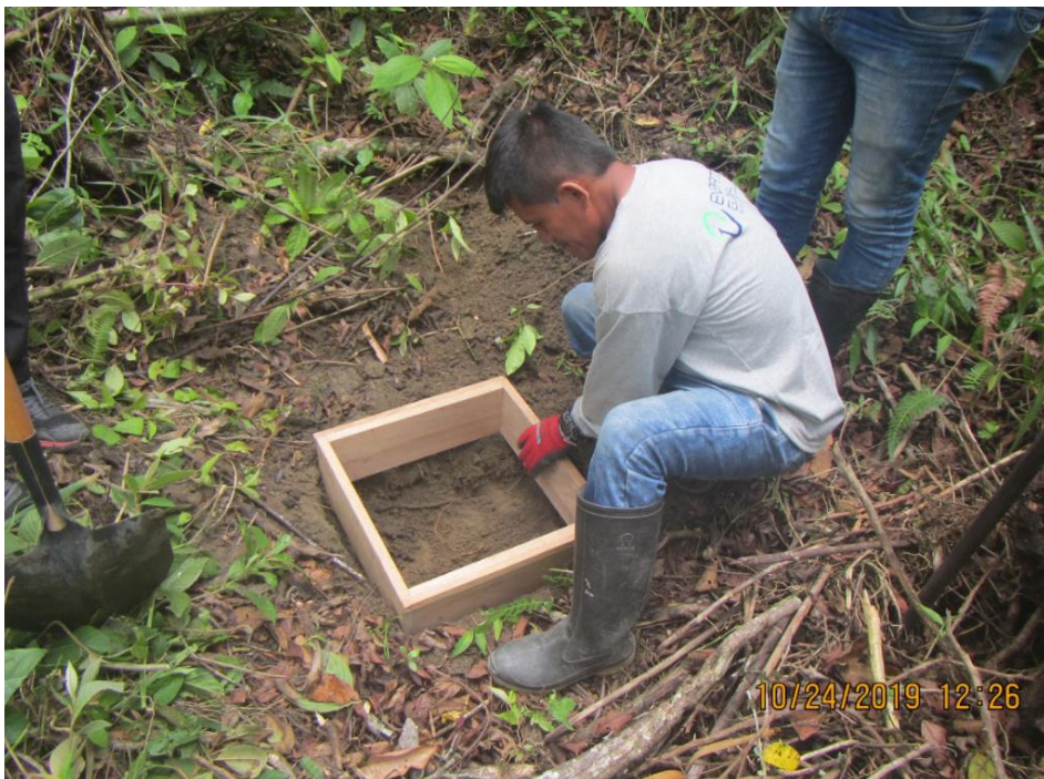
Figura 25: Colocación de encofrado para la monumentación
