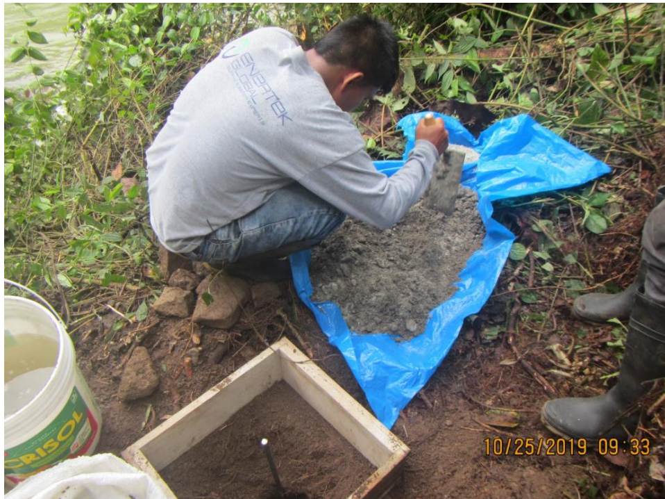
Figura 26: Preparación de la mezcla para la monumentación
