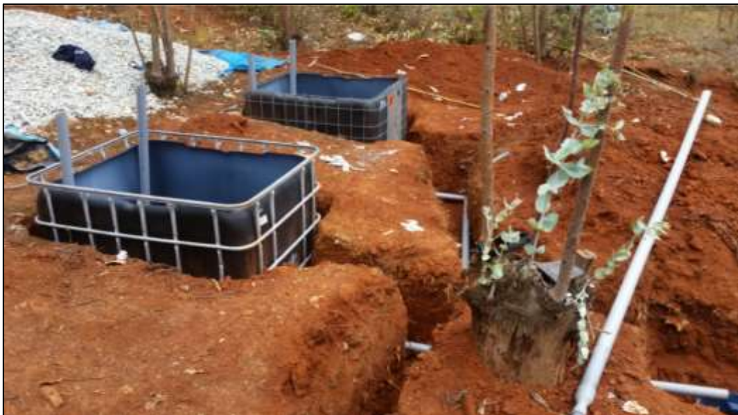
Figura 20: Instalación de tuberías PVC SAL de 2” y sustrato
