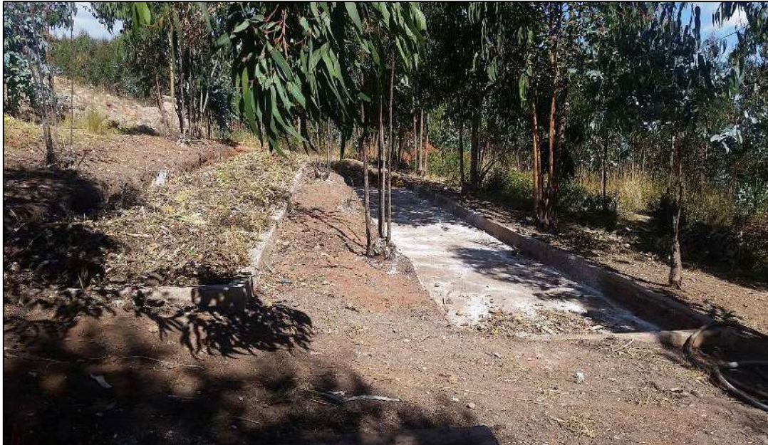
Figura 14: Composteras de concreto en el relleno sanitario de Anta
