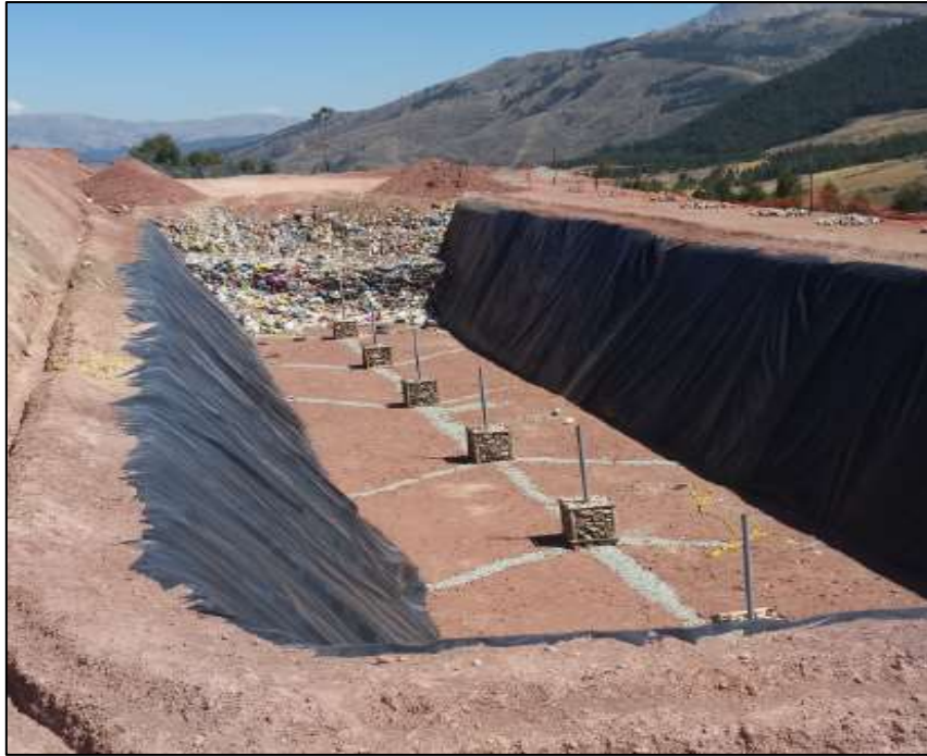
Figura 2: Trinchera de relleno sanitario de Anta
