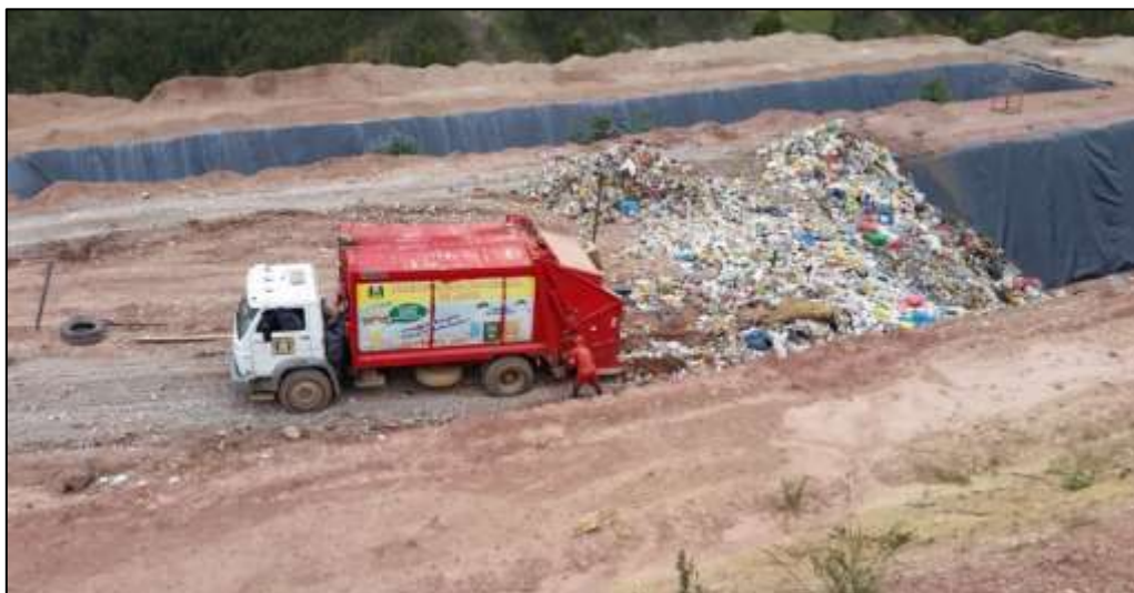
Anexo 1.1. Trincheras del relleno sanitario de Anta
