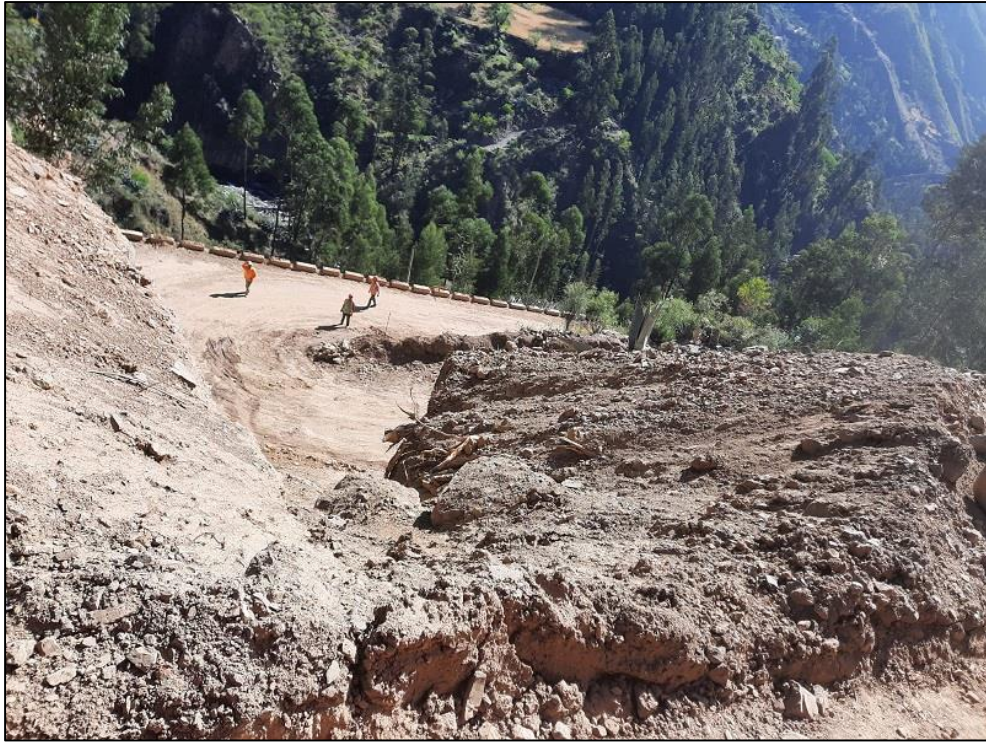
Figura 21: Remoción de la cubierta vegetal
