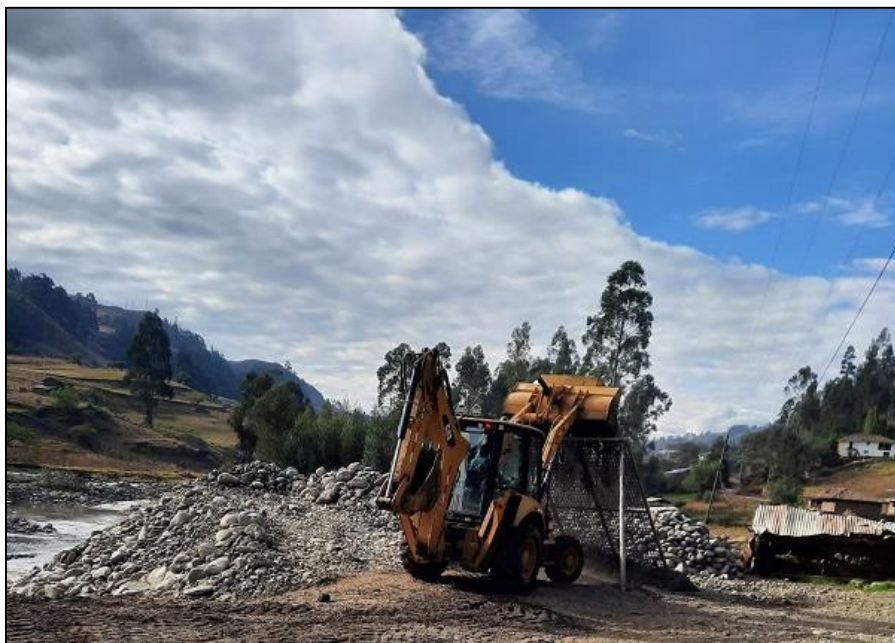
Figura 14: Extracción de Agregados
