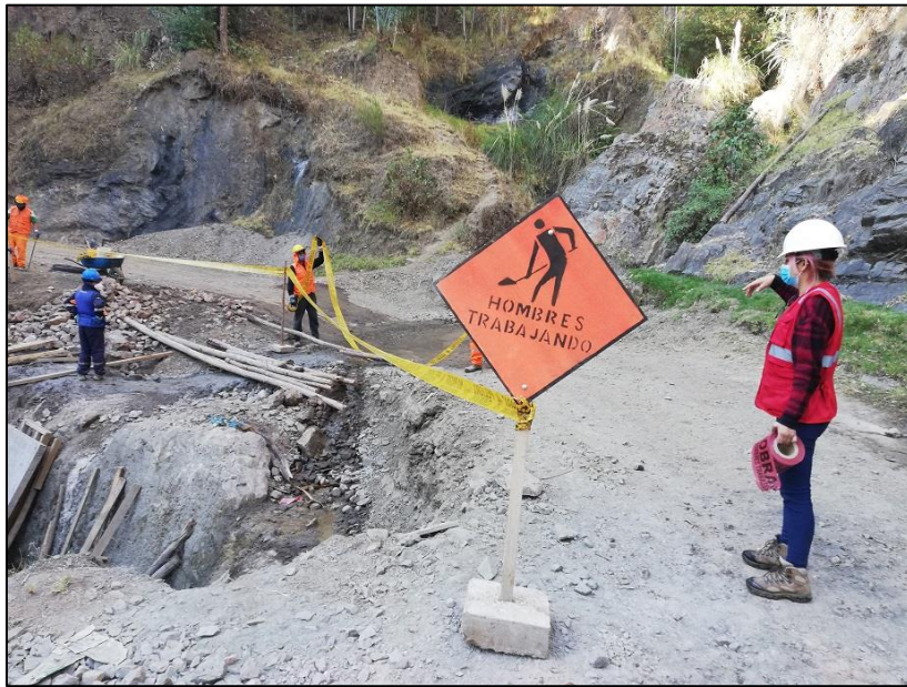
Figura 13: Colocación de Señalizaciones
