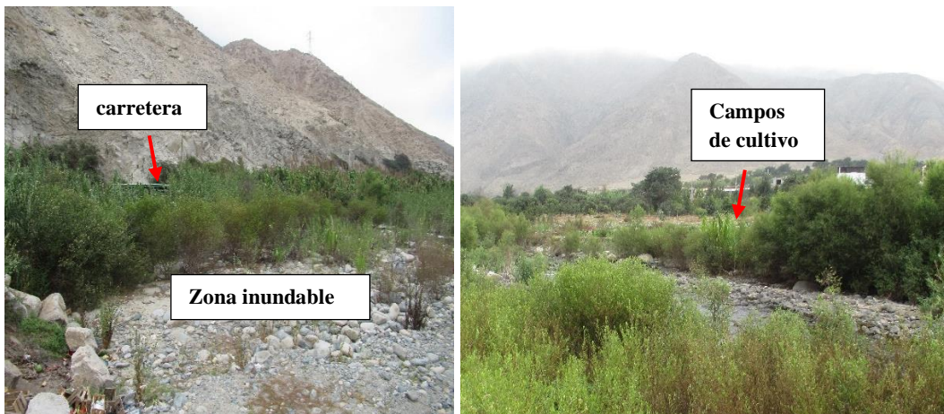
Figura 71: Identificación de las zonas críticas 1 y 2 en la visita al campo
