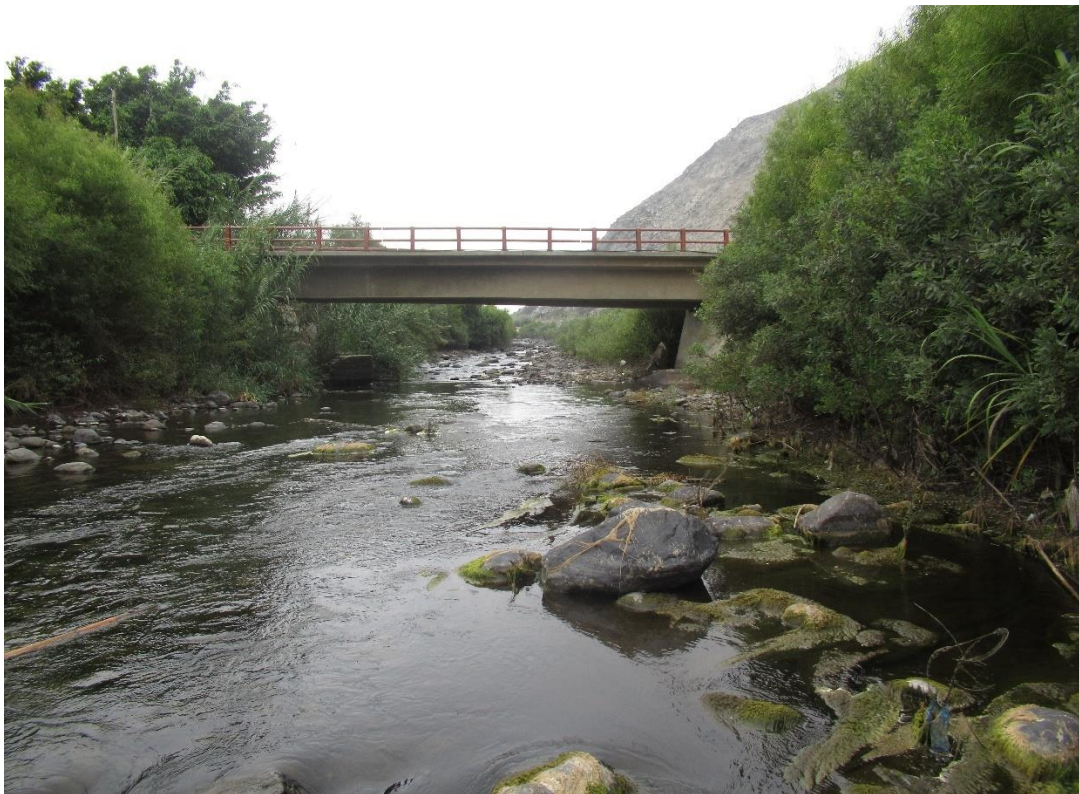
Figura 97: Vista de la sección del puente existente desde aguas abajo
