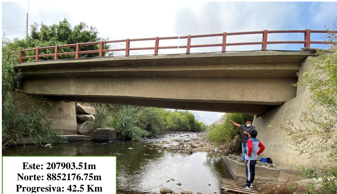
Figura 20: Vista fotográfica aguas abajo del puente actual
