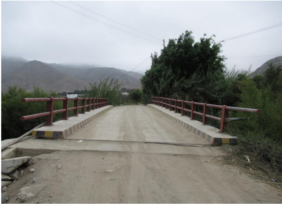
Figura 96: Vista frontal del puente existente con dirección al centro poblado Huáncar
