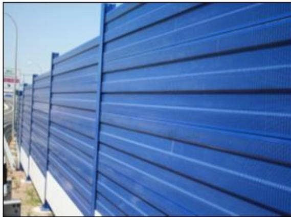
**Figura 9: Pantallas metálicas. Recuperado de Basseda (2015).**
