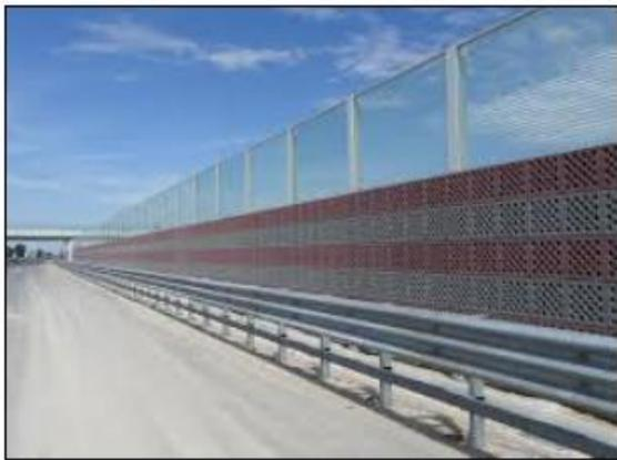
**Figura 14: Pantallas de ladrillos absorbentes. Recuperado de Basseda (2015).**
