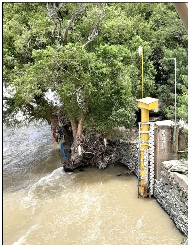
Figura 23: Estación hidrométrica Puente Taruca.
