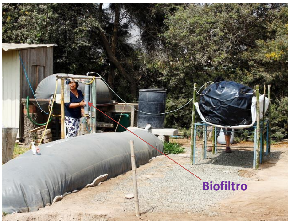
Figura 29: Instalación del Biofiltro de compost para la prueba Piloto
