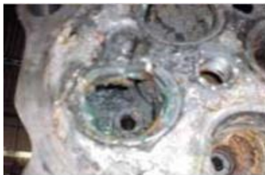
Figura 11: Corrosión ocasionada por el H 2 S Fuente: Víquez (2010)
