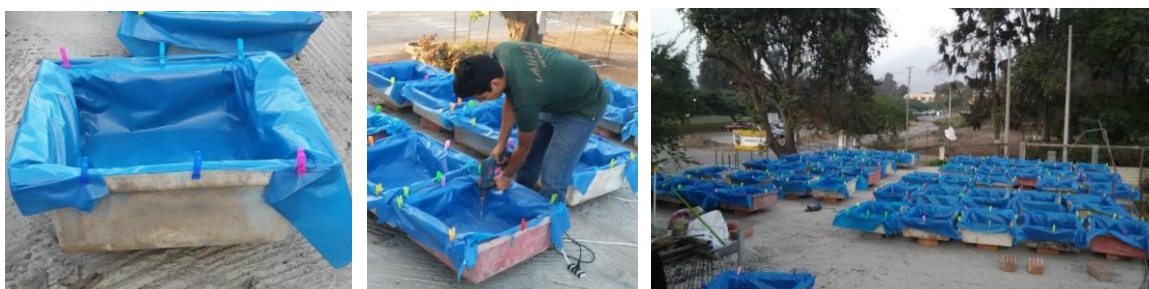
Figura 4, 5 y 6. Contenedores de fibra de vidrio, recubiertos con polietileno de 0.15 mm de espesor en el techo del aula de Cursos electivos del PIPO-UNALM.
