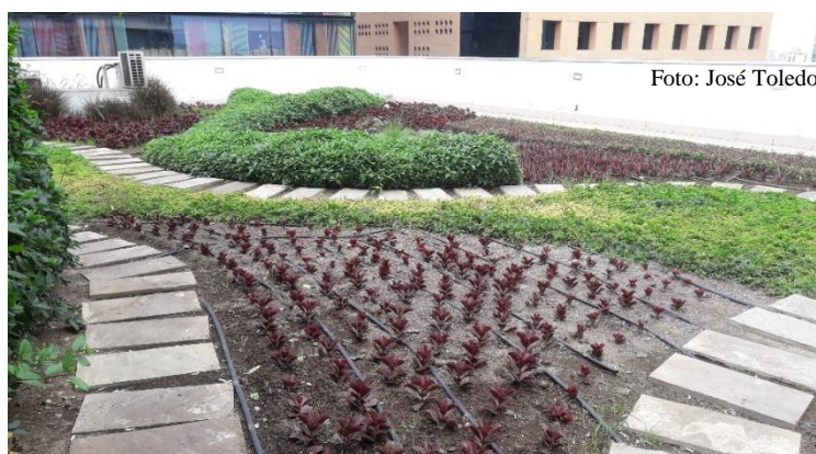
Figura 14: Exposición de las mangueras de riego en los techos verdes reduce la probabilidad de picado de mangueras.
