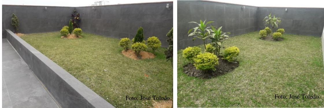
Figura 6: Techo verde intensivo simple en Miraflores, Lima.
