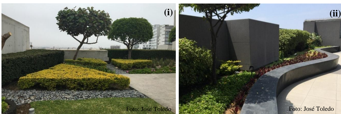
Figura 5. Techos verdes intensivos en los distritos de Barranco y San Isidro de Lima Metropolitana
