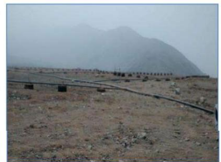
Pozos de extracción de gas
