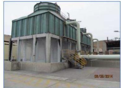
Radiadores del sistema de refrigeración de TV1
