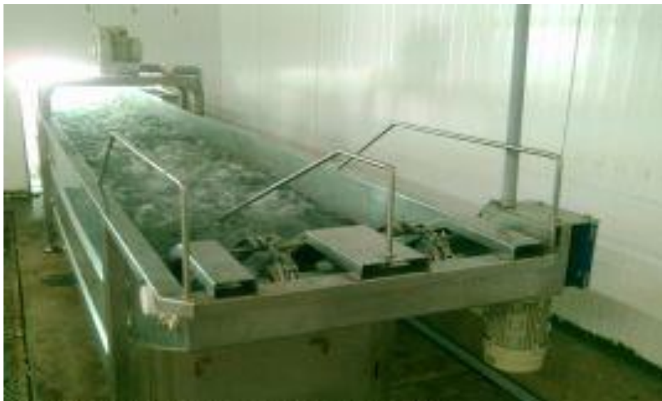
Figura 16. Hidroenfriador de materia prima.
