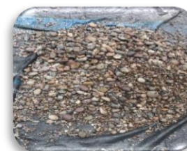
Piedras ya desinfectadas, listas para proceder a instalarlas en las cámaras de subirrigación
