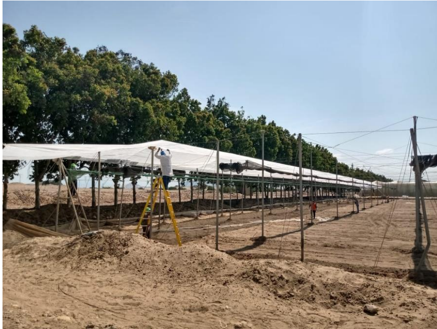
Figura 29: Proceso de renovación de malla antiáfido.
