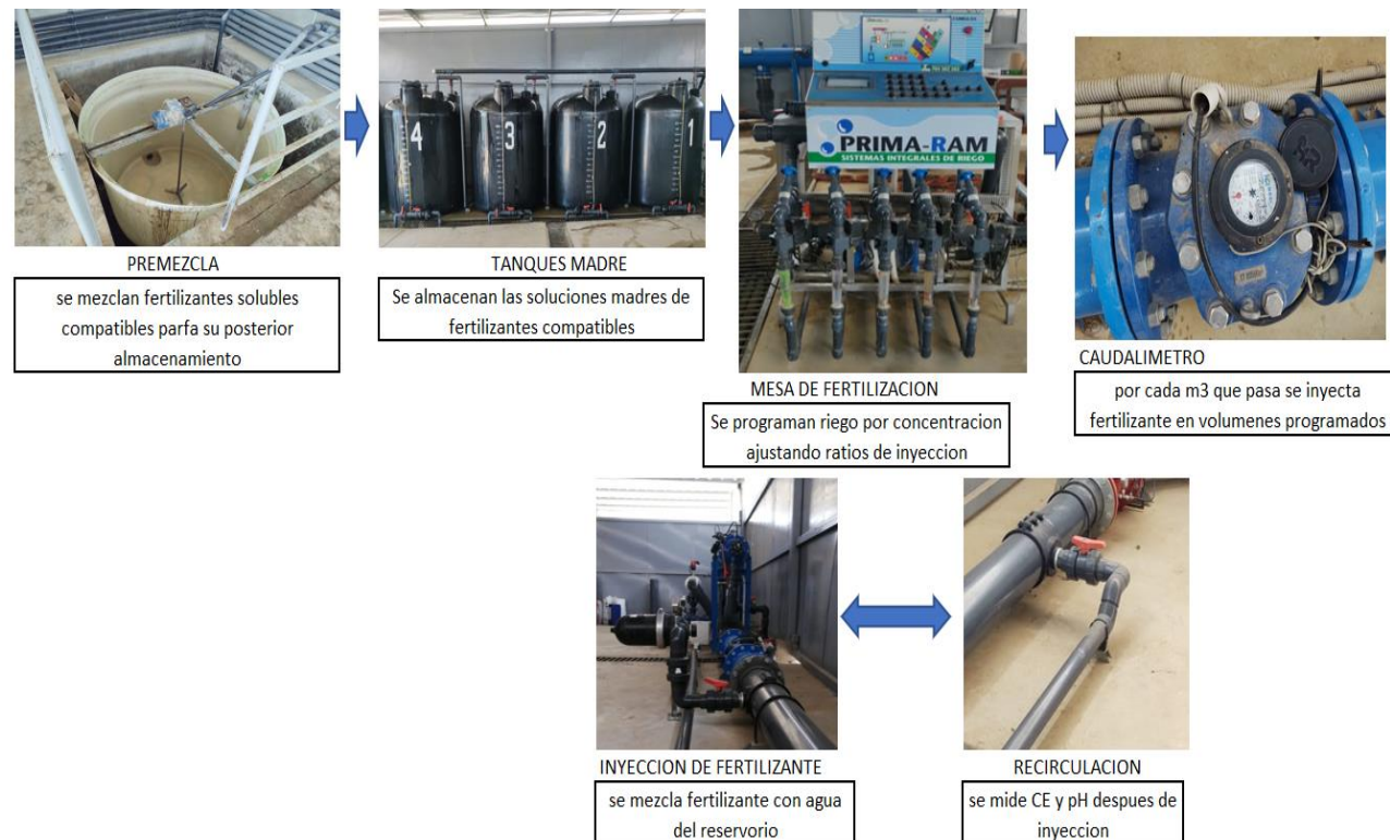
Figura 10: Descripción del sistema de inyección de fertilizantes automatizado utilizado en la producción de arándano
