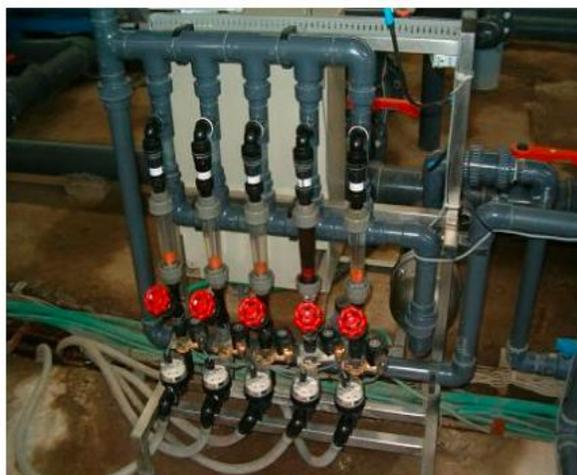
**Figura 12:** Sistema de fertirriego. Mesa de inyección de soluciones con fertilizantes. (Vidal, 2019)
