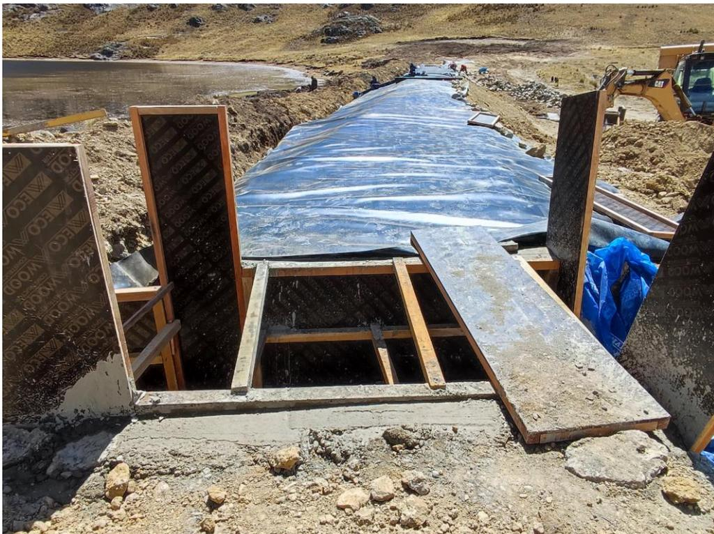
**Figura 20: Instalación de geomembrana de HDPE  $e=1\text{mm}$  y polylock instalado**
