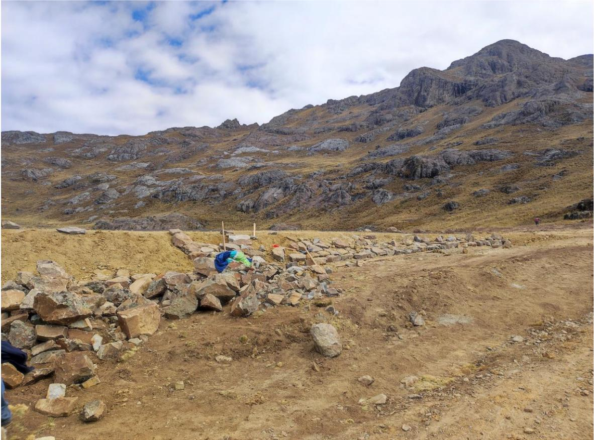
**Figura 42: Conformación de espaldón con piedra**
