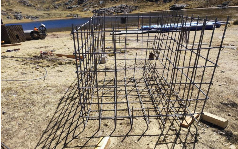
**Figura 21: Estructura de acero parte descarga**
