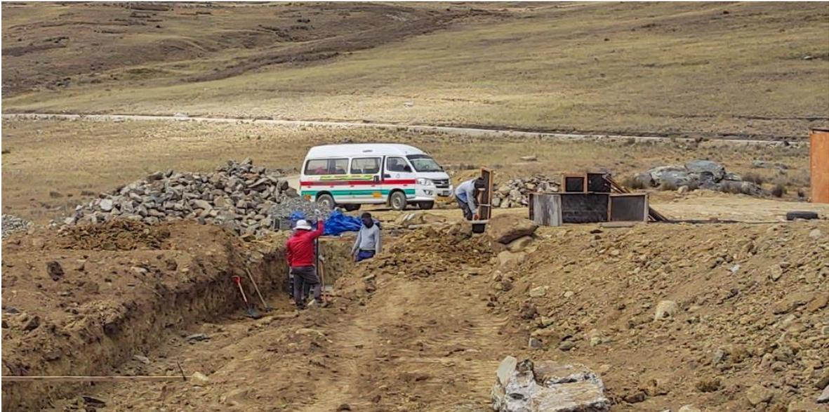
**Figura 25: Elaboración y excavación manual del aliviadero de demasías**
