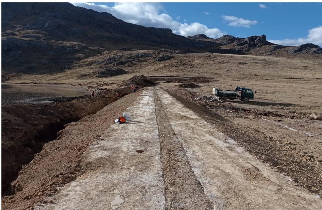
**Figura 17: Relleno compactado con material propio con maquinaria**
