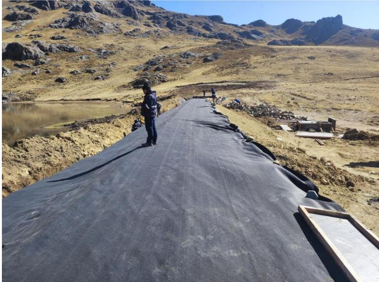
**Figura 19: Instalación de geotextil no tejido de  $300 \text{ gr.m}^{-2}$**
