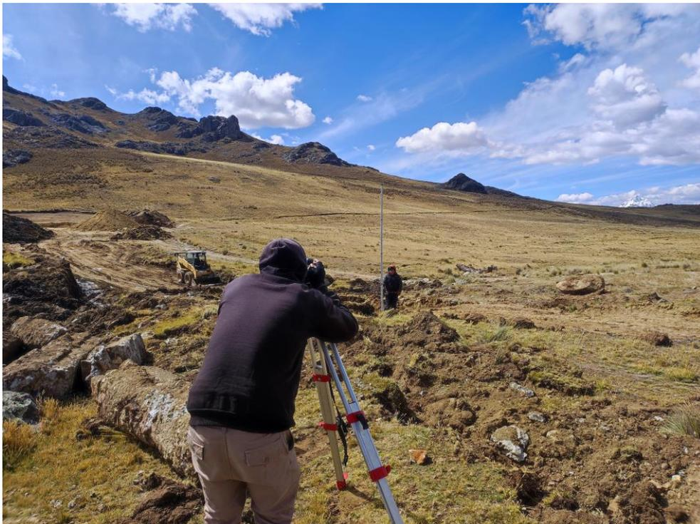
**Figura 14: Medición altimétrica del cuerpo del dique con el terreno ya excavado**
