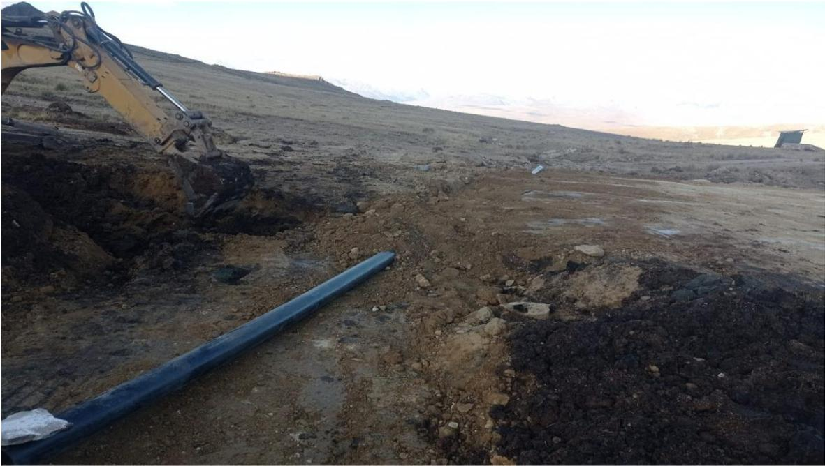
**Figura 40: Suministro e instalación de tubería HDPE 160 mm, SDR26 PN6, ISO 4427, que unirán las estructuras de toma y de descarga, para ello se usaron uniones mecánicas tipo victaulic y la longitud es de 16 metros**
