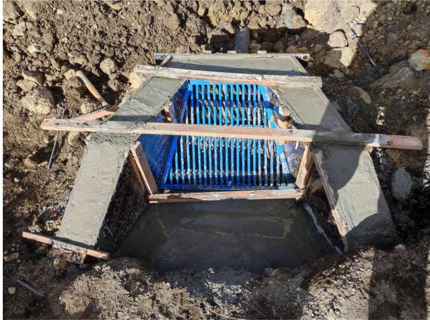
**Figura 23: Formación de estructura de toma**
