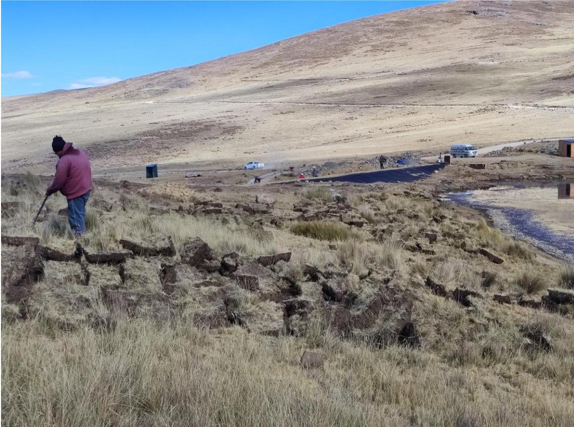
**Figura 26: Selección y extracción de champa para la colocación en la corona del dique de tierra**
