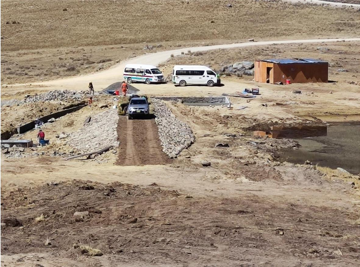
**Figura 27: Traslado y colocación de champa en la corona del dique**
