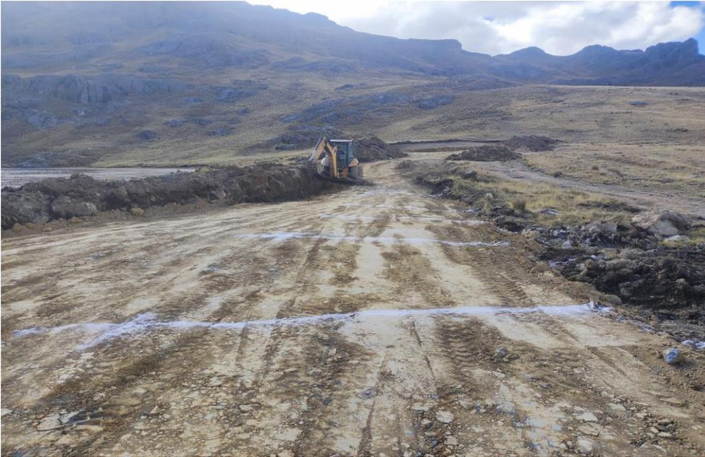
**Figura 38: Eliminación y limpieza de materia orgánica con la maquinaria retroexcavadora**
