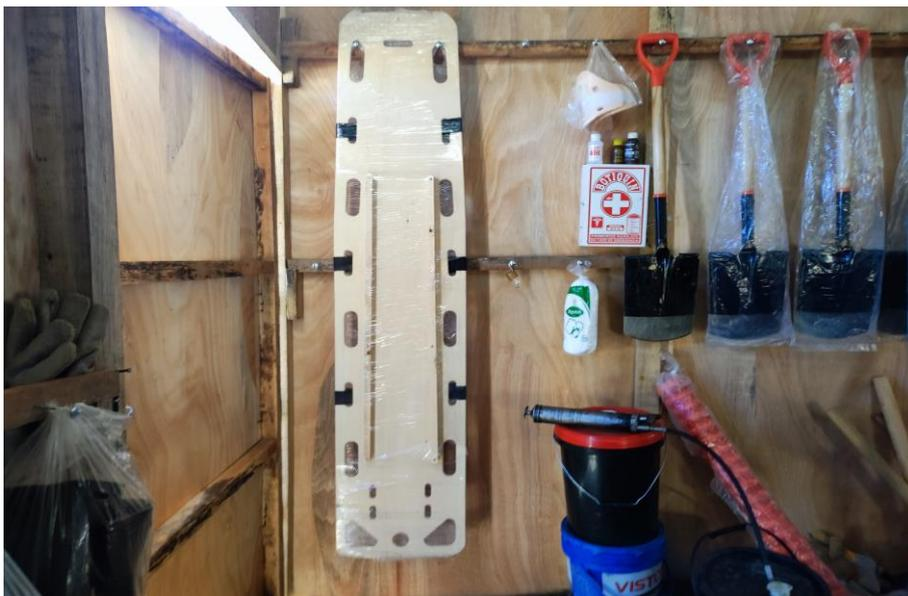
**Figura 35: Colocación de los equipos de emergencia contra accidentes (camilla, botiquín y collarín)**
