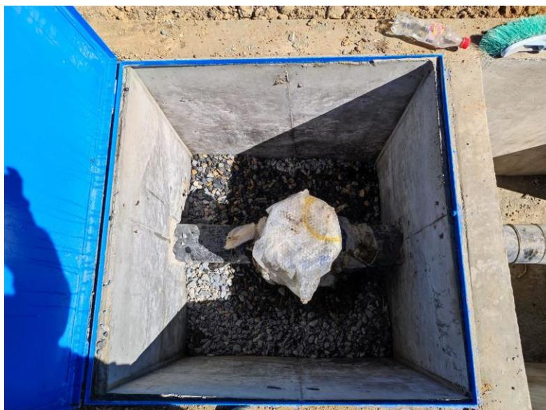
**Figura 24: Colocación y formación de la válvula tipo compuerta de 160 mm y accesorios**
