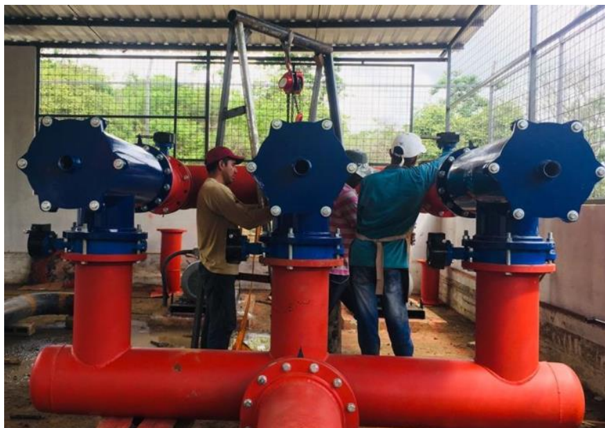
Figura 52: Instalación de los filtros de malla con el caballete de fierro
