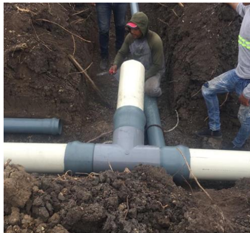
Figura 35: Biselado de espiga de niple entre tee y reducción PVC
