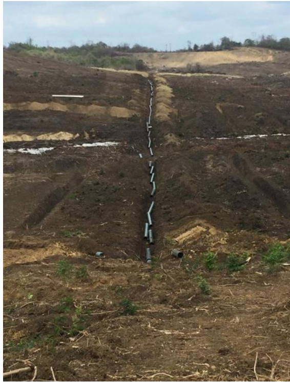
Figura 26: Tendido de tubería matriz luego de nivelar y limpiar la zanja
