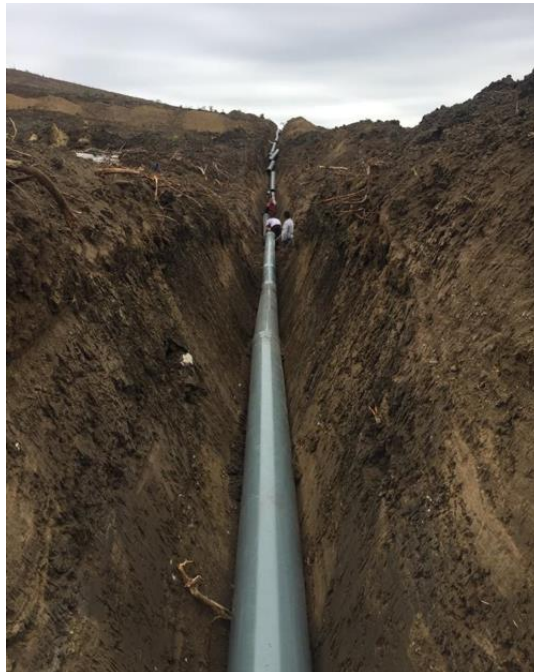
Figura 27: Embone de tubería PVC 315mm U/Z
