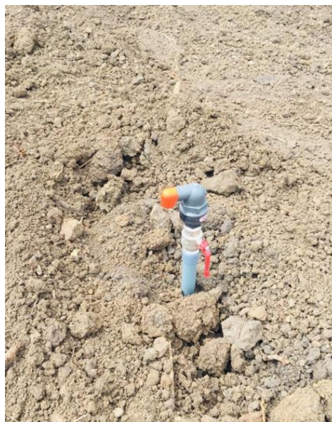
Figura 34: Instalación de válvula de aire de 2" en La Estación
