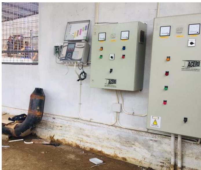
Figura 61: A la derecha se observa el tablero de control de las dos bombas de riego, al medio se encuentra el tablero de control de la bomba de fertilización y a la izquierda el DREAM 2
