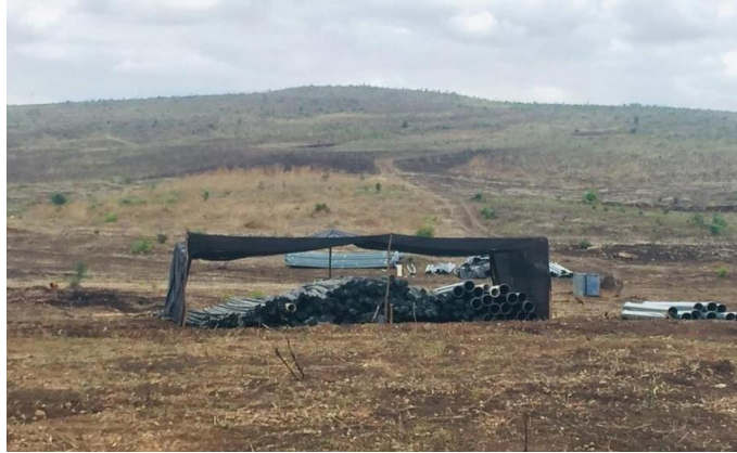
Figura 24: Almacén de tuberías en La Estación
