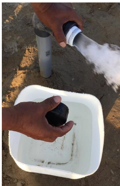
Figura 67: Purgado de matriz junto a recipiente de control de impurezas
