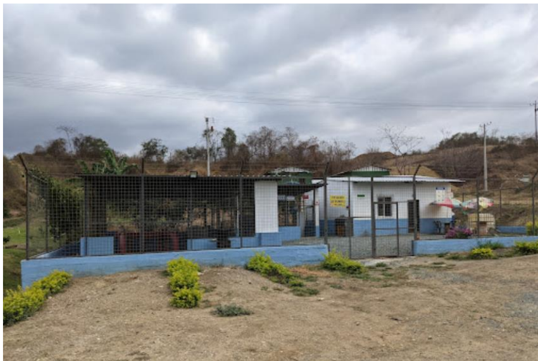
Anexo 32: Centro de Control Hda. La Estación
