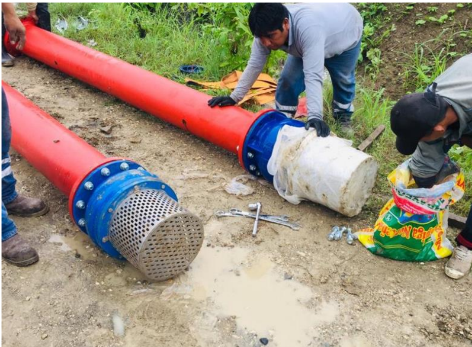
Figura 50: Válvulas de pie de 10" (check) que fueron sumergidas en el canal
