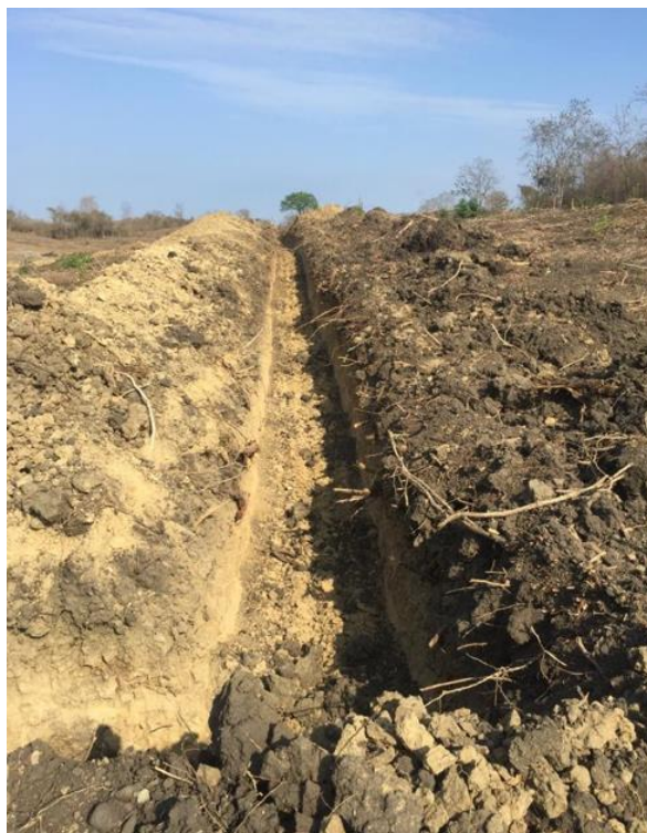
Figura 22: Zanja nivelada y limpia
