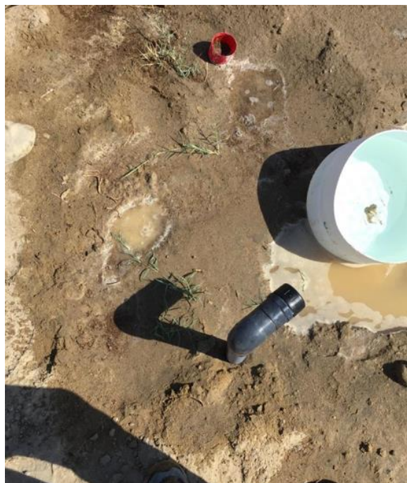
Figura 68: Lavado de laterales de riego de 32mm
