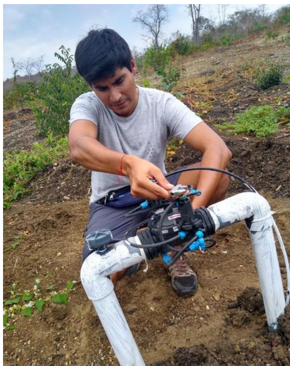
Figura 73: Calibración de presión aguas abajo con piloto 29-100
