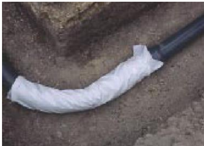
Figura 97: Accesorio cubierto con polietileno grueso
