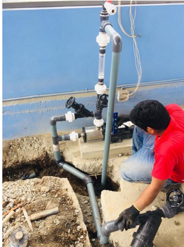
Figura 74: Bomba de inyección MULTI-H 405 con conexiones de recirculación (válvula oblicua), inyección y medidor de caudal instantáneo
