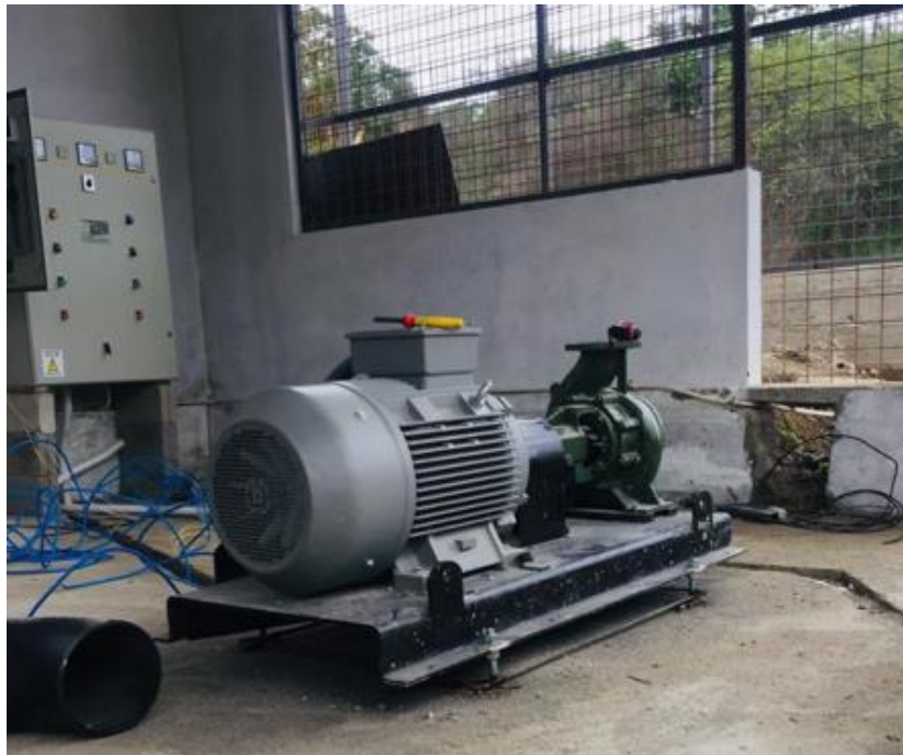
Figura 48: Proceso de instalación de la bomba centrífuga
