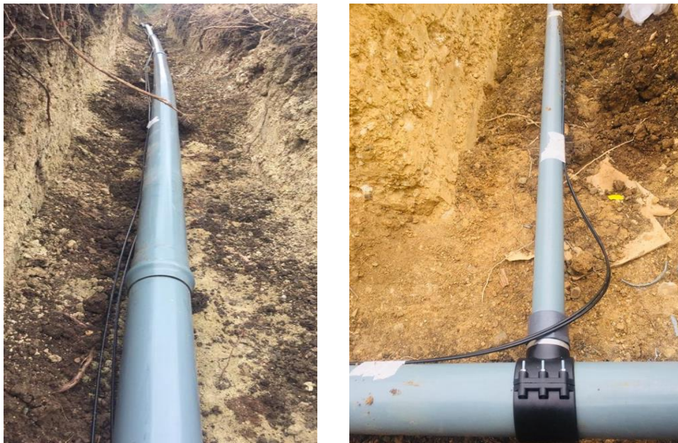
Figura 39: Instalación de microtubo de comando de 8mm
