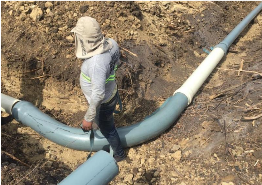
Figura 36: Instalación de curva de largo radio con niple antes de reducción
