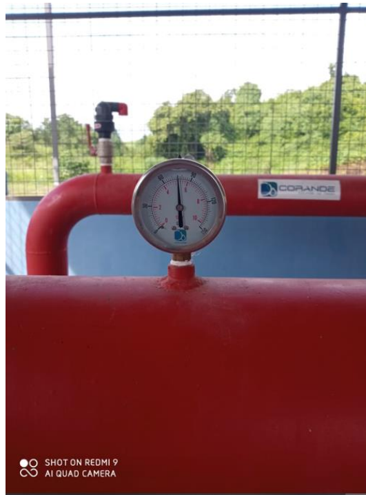
Figura 66: Presión de descarga a 5.2 bar en el lavado de redes
