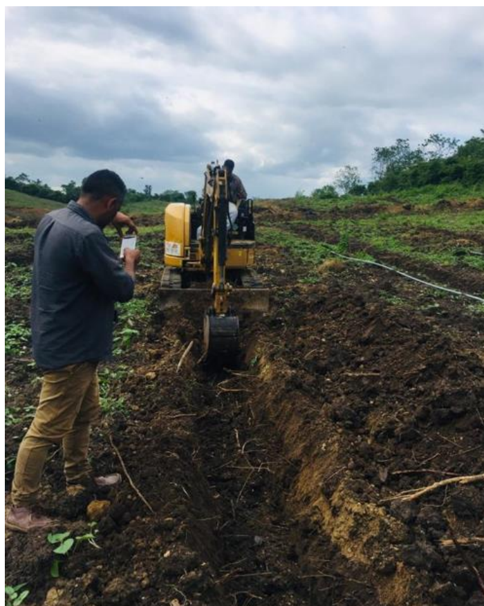
Figura 23: Excavación de zanjas para laterales con Bobcat
