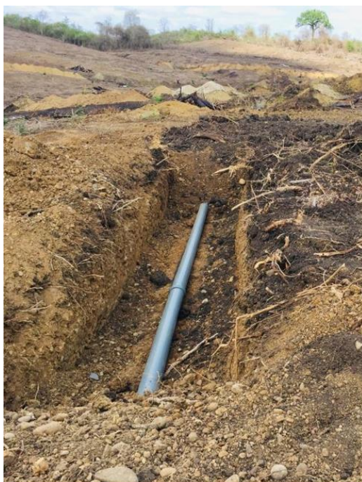
Figura 40: Tapado de tubería matriz y una zona dejada libre para instalar válvula de aire
