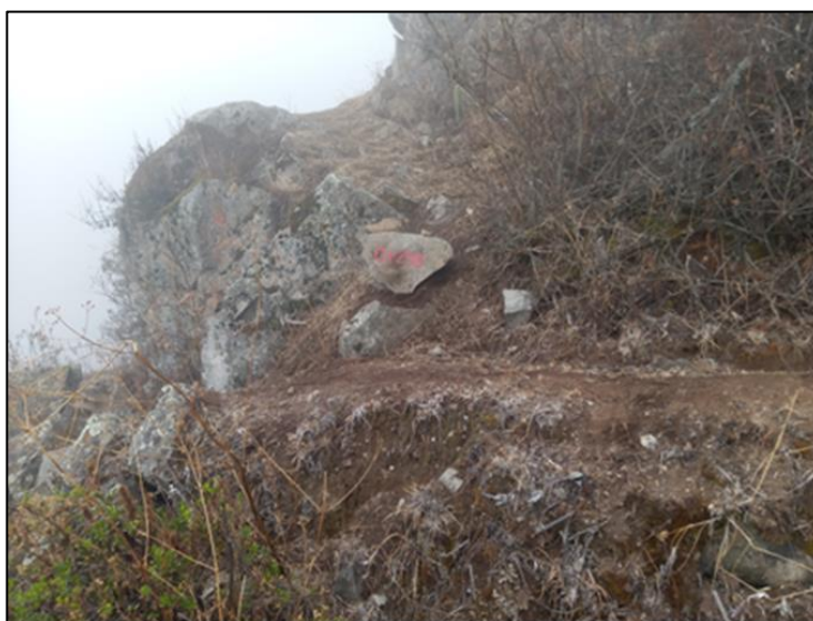
Figura 9: Cantera identificada progresiva 0+240 km.
