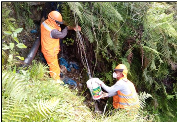
Figura 20: Captación en donde se realizó el aforo.
