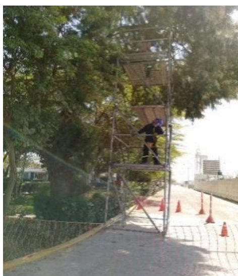
Figura 13. Situación de podas con andamios. Armado de la estructura.
