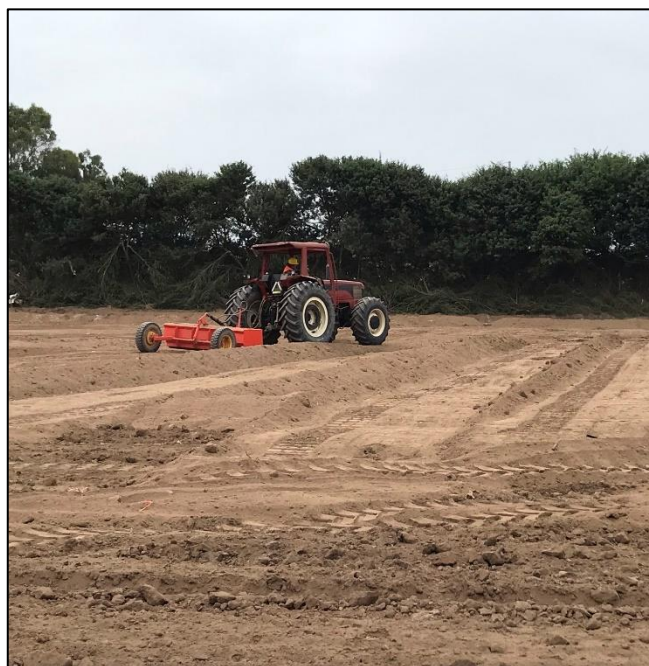
Figura 22. Tractor con rufa hidráulica en nivelación final
