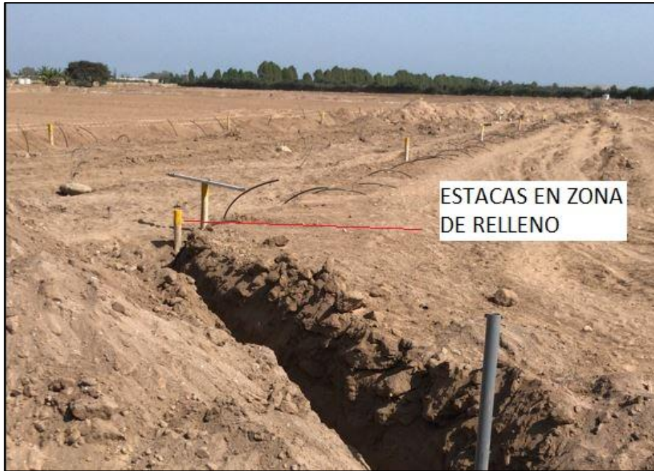
Figura 19. Ubicación de estacas en campo en secciones de relleno
