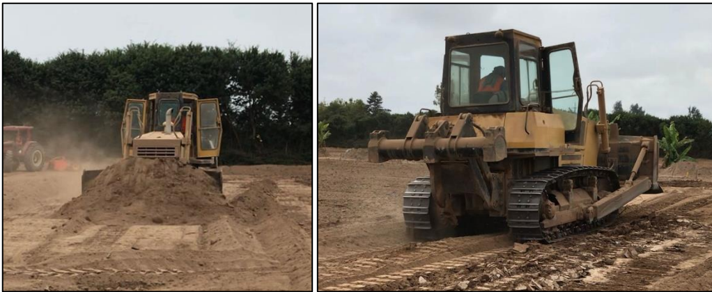
Figura 21. Tractor Bulldozer realizando corte de suelo
