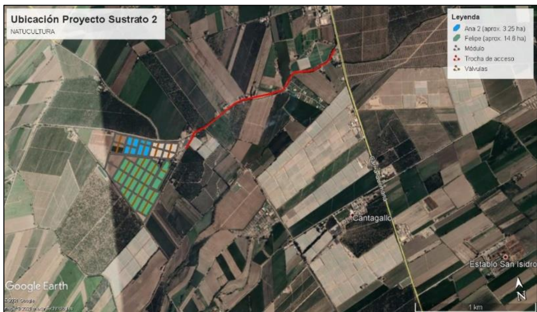
Figura 10. Ubicación del proyecto de nivelación y movimiento de tierras
