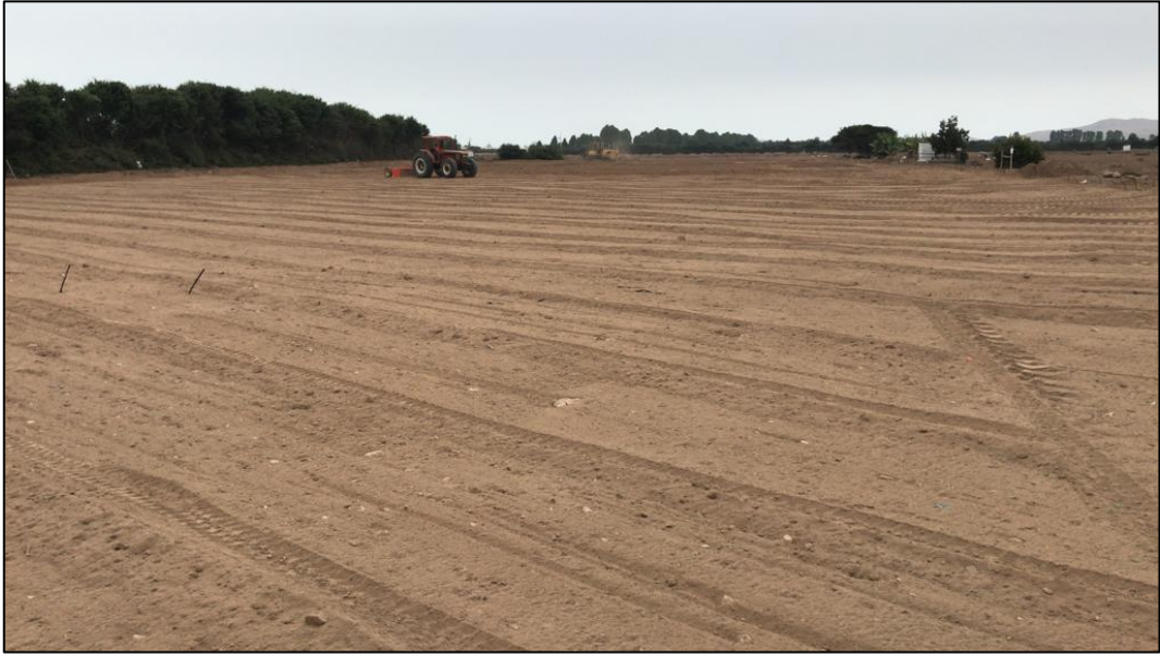
Figura 23. Nivelación final del plano de nivelación válvula 21
