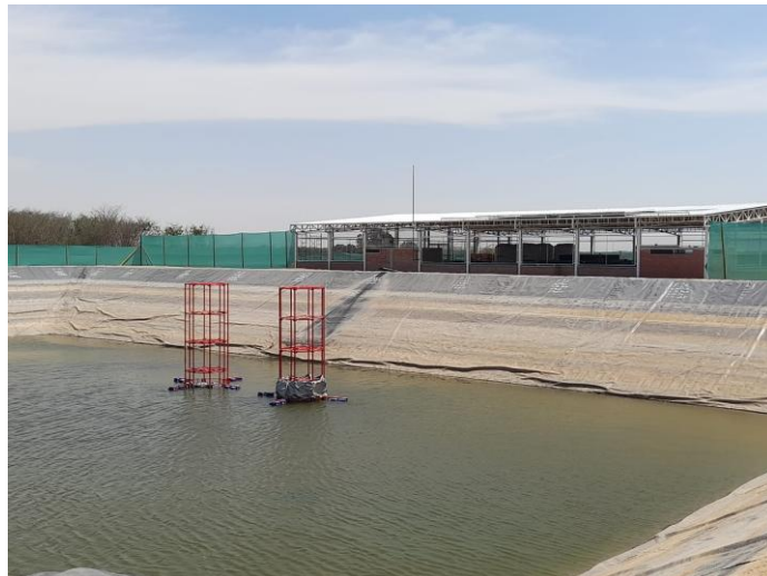
Figura 20: Reservorio con toma flotante
