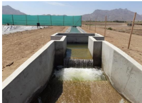
Figura 19: Entrada al desarenador
