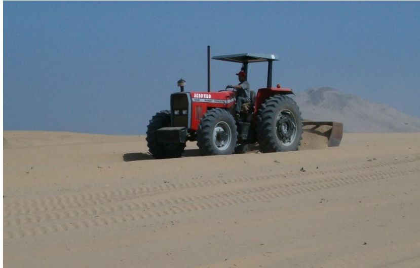
Figura 10: Nivelación mediante tractor de ruedas y apero.
