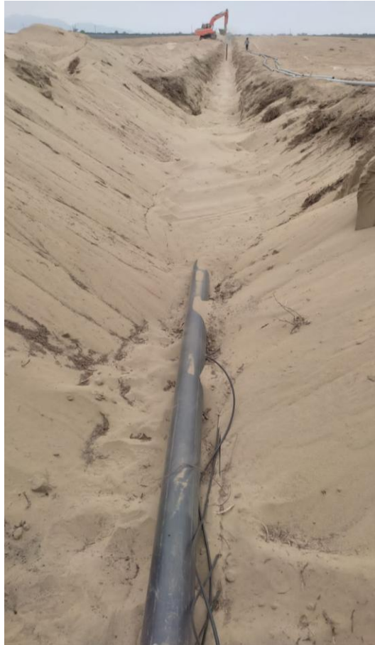
Figura 16: Instalación de tuberías y manguera de comando. Fuente: Cortesía de GERMINA S.A.
