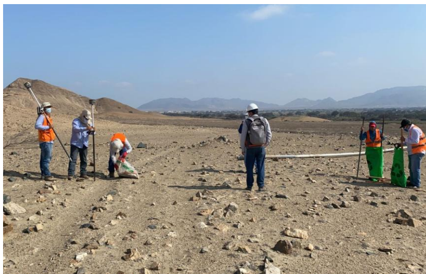
Figura 12: Topografía y estacado de terreno. Fuente: Cortesía de GERMINA S.A.
