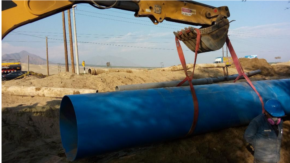
Figura 14: Instalación de matrices.
