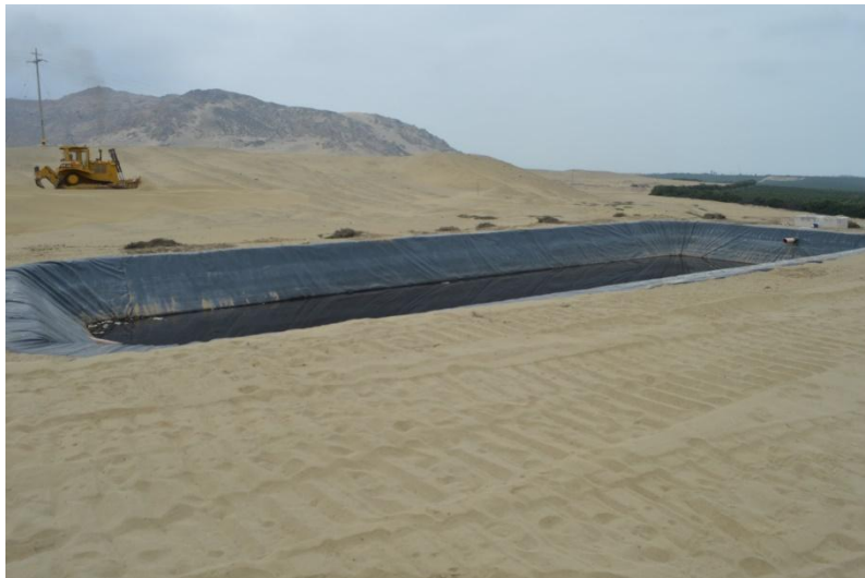
Figura 15: Reservorio hecho a base de geomembrana de HDPE (High Density Polyethylene), usados comúnmente en la Irrigación.
