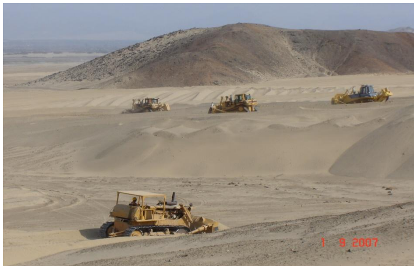
Figura 9: Nivelación gruesa mediante tractor oruga.
