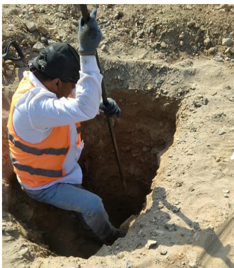
Figura 11: Calicata realizada al terreno. Fuente: Cortesía de GERMINA S.A.
