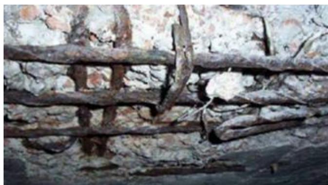
**Figura 3: Daños por carbonatación del concreto**
