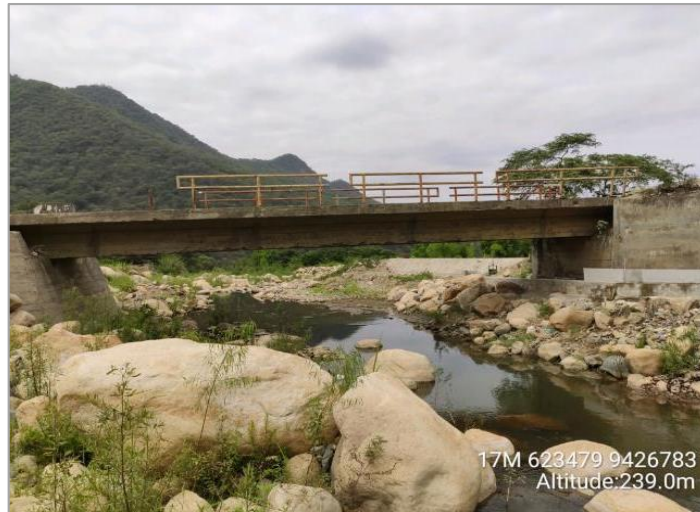
Figura 13: Vista Longitudinal de Puente Chalaco
