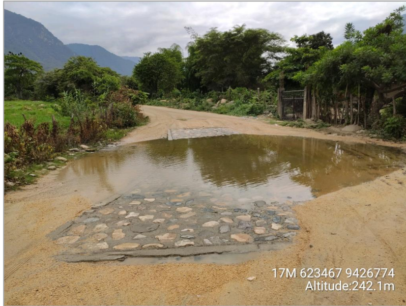
Figura 18: Vista lateral de badén cercano a puente chalaco
