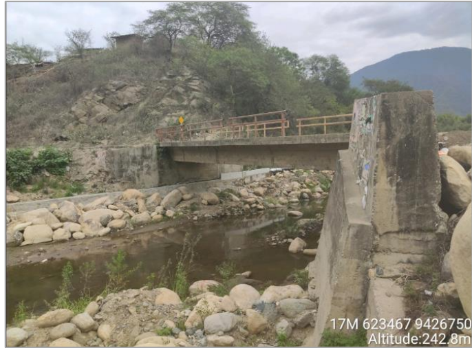
Figura 11: Vista Lateral de Puente Chalaco
