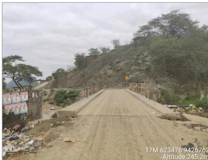
Figura 14: Vista de Tablero y vía respectiva de Puente Chalaco
