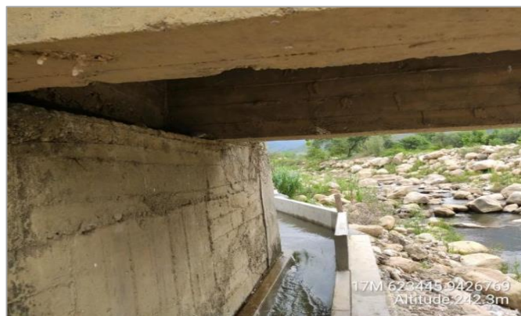
Figura 16: Canal de concreto en Puente Chalaco.
