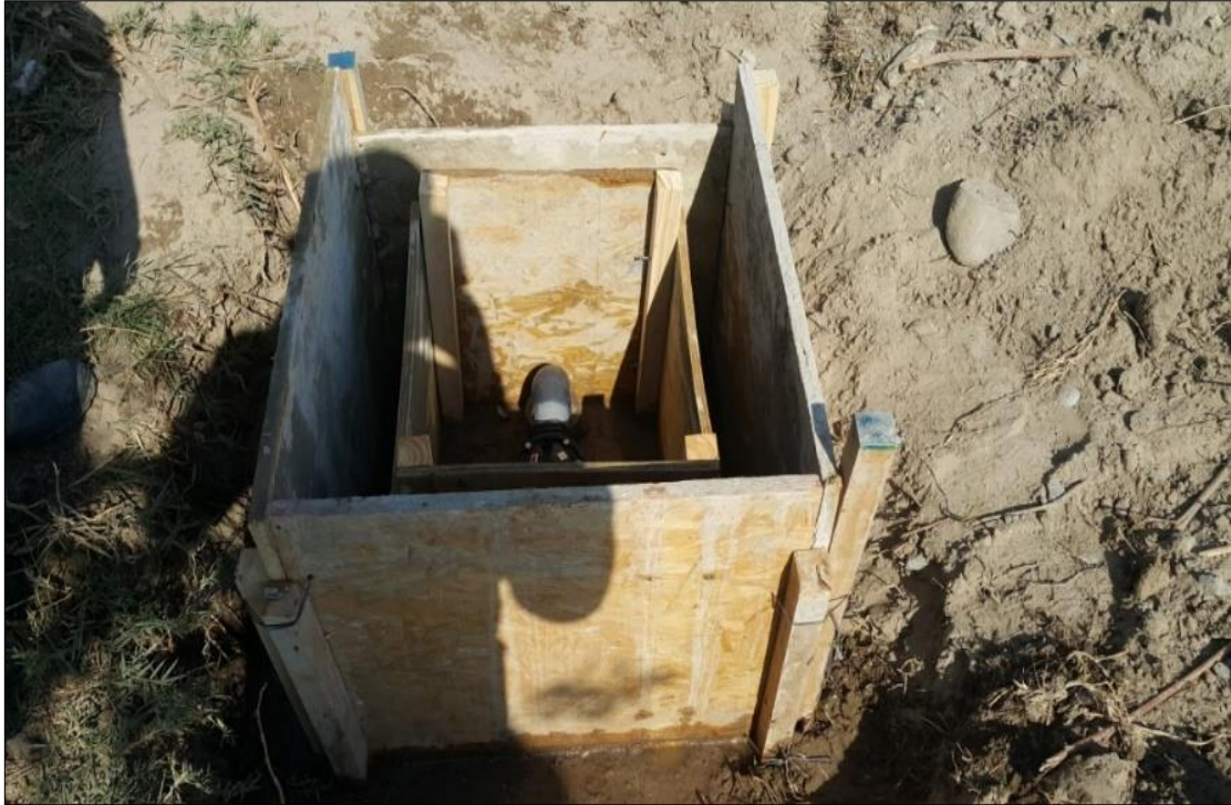
Figura 21: Construcción de cajas de concreto
