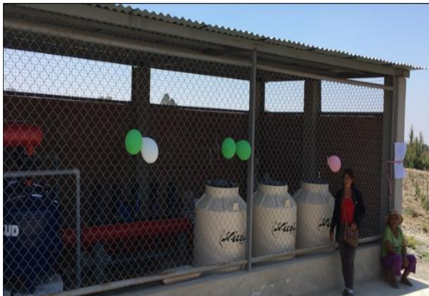
Figura 22: Construcción de caseta de riego
