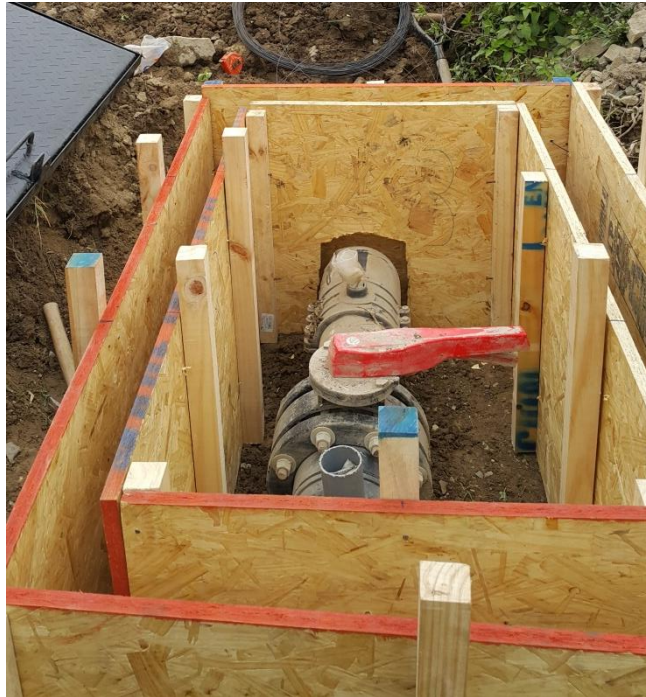
Figura 38: Encofrado de las cajas para las válvulas
