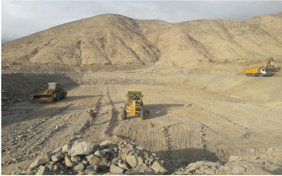
Figura 29: Movimiento de tierra en la construcción del reservorio
