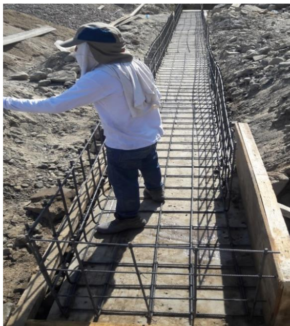
Figura 34: Construcción del canal de entrada
