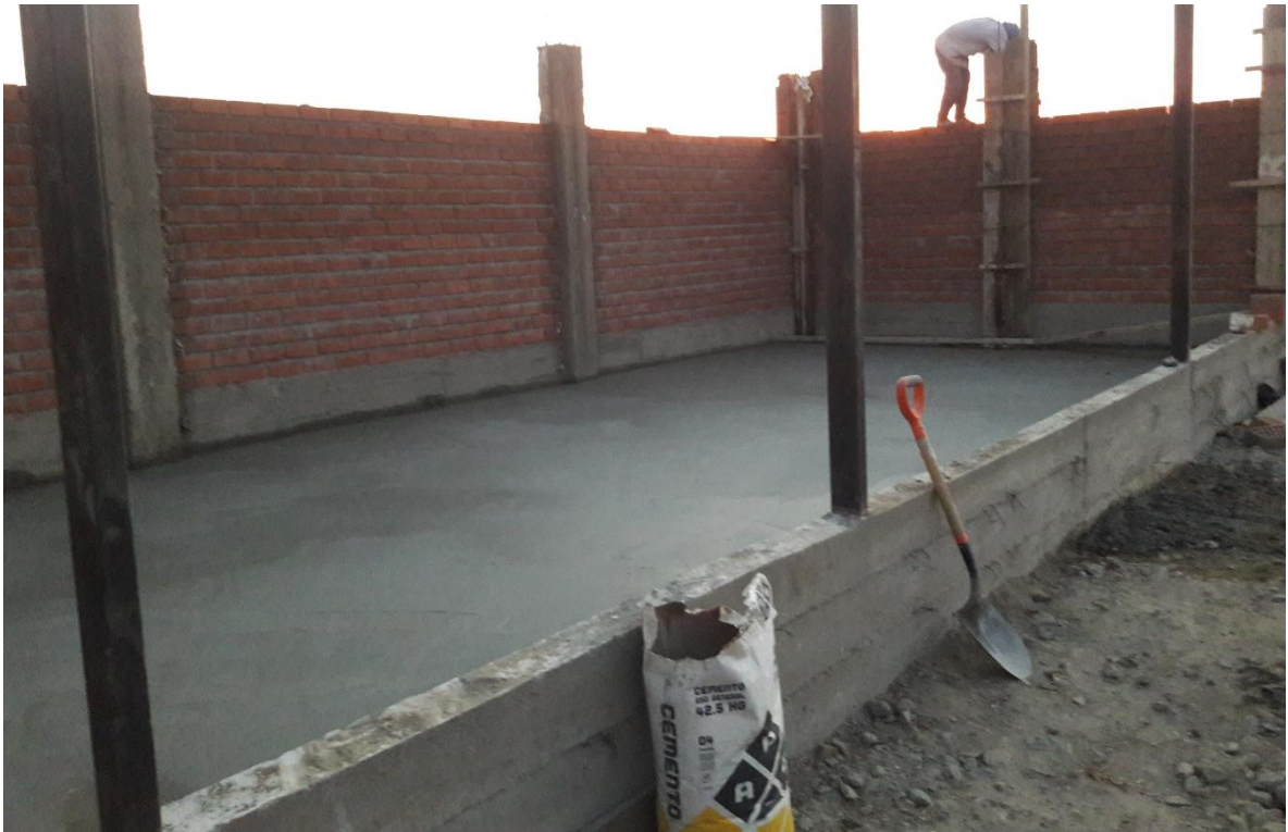
Figura 35: Construcción de la caseta
