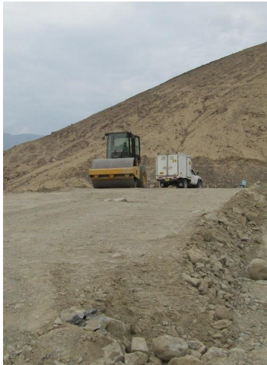
Figura 30: Compactación del dique del reservorio
