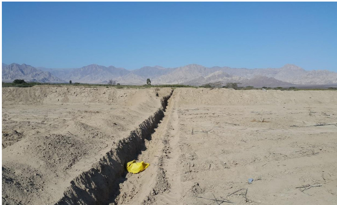
Figura 44: Excavación de zanja para tubería
