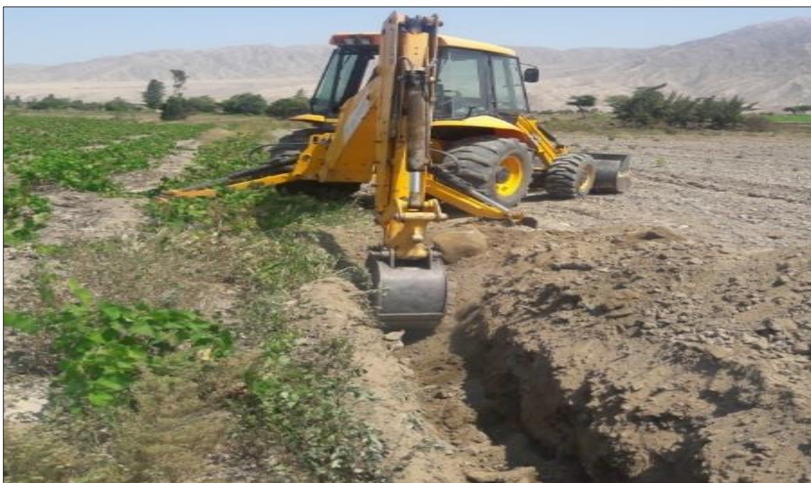
Figura 16: Excavación de zanja con retroexcavadora
