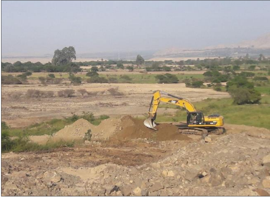
Figura 24: Construcción de reservorio
