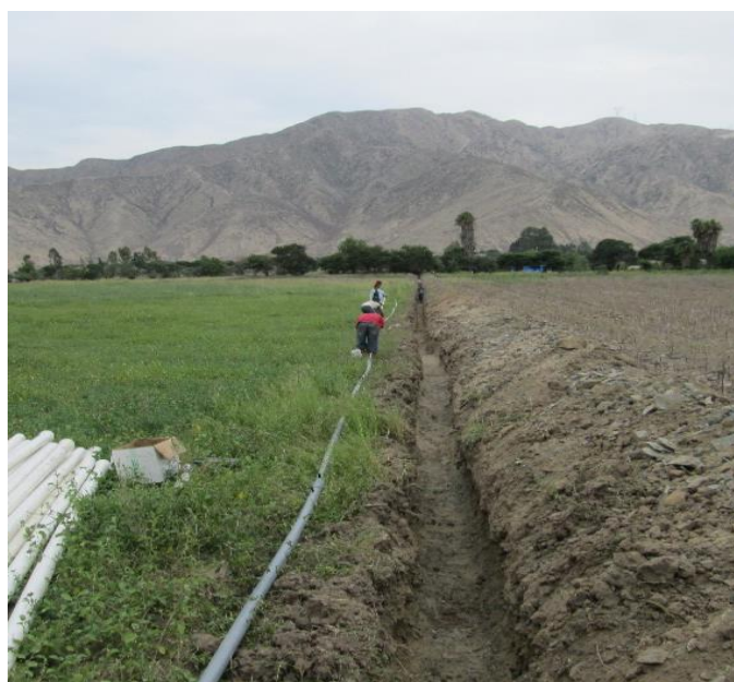
Figura 28: Tendido de red de tuberías
