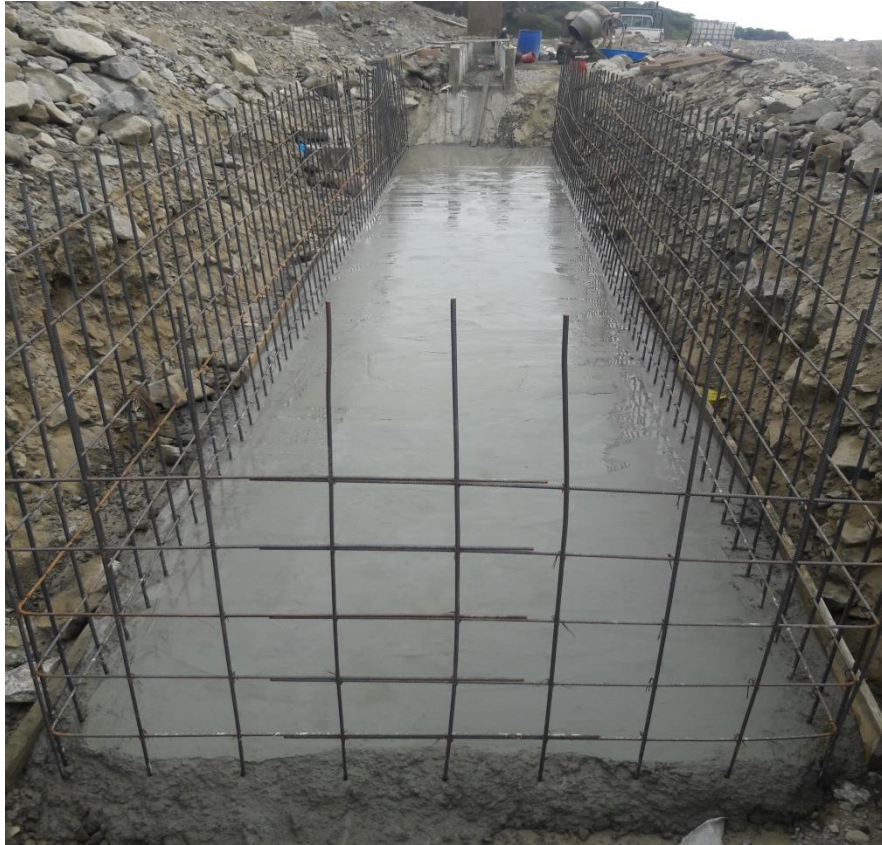
Figura 33: Construcción del Desarenador
