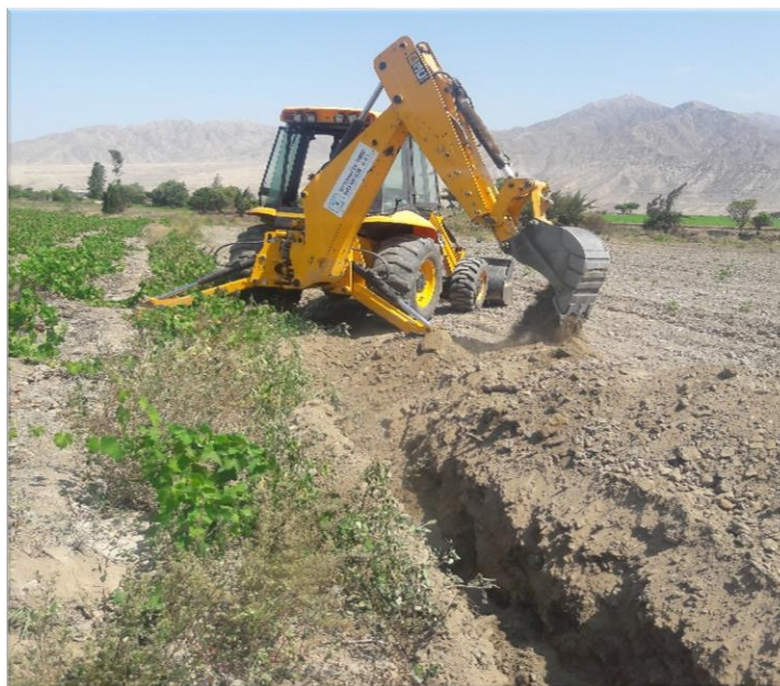
Figura 27: Excavación de zanja
