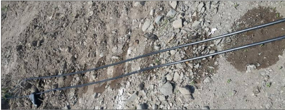
Figura 20: Instalación de emisores de riego
