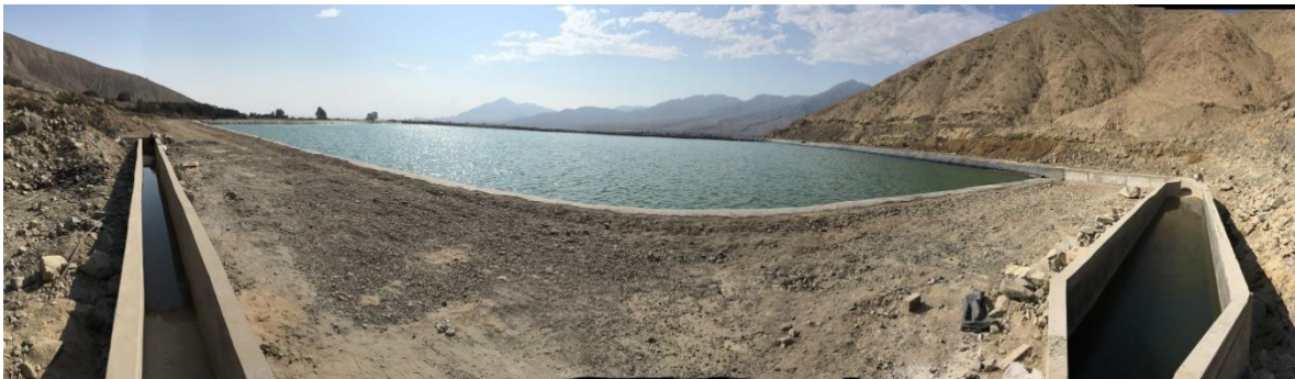
Figura 32: Vista Panorámica del reservorio lleno, canal y desarenador
