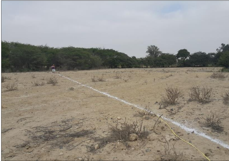
Figura 15: Trazado y replanteo de campo
