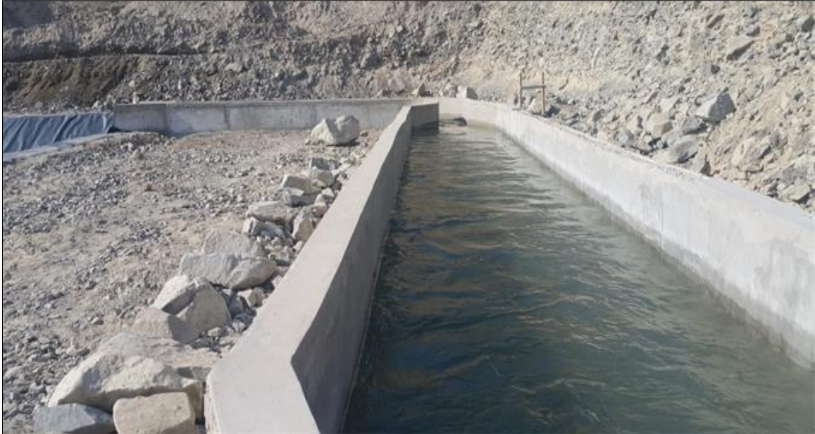
Figura 23: Construcción de desarenador
