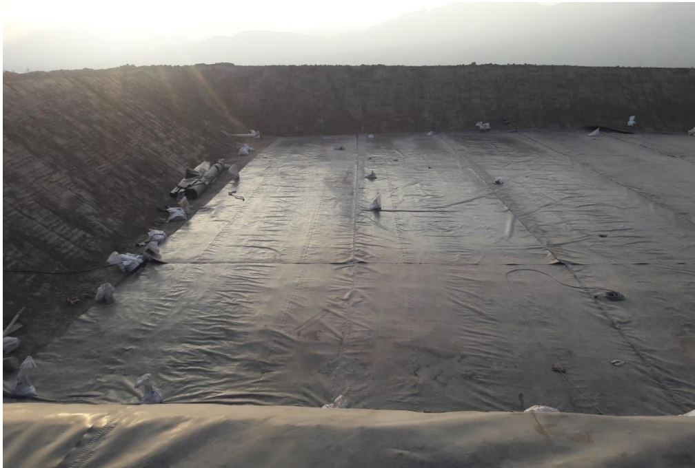
Figura 31: Instalación de Geomembrana
