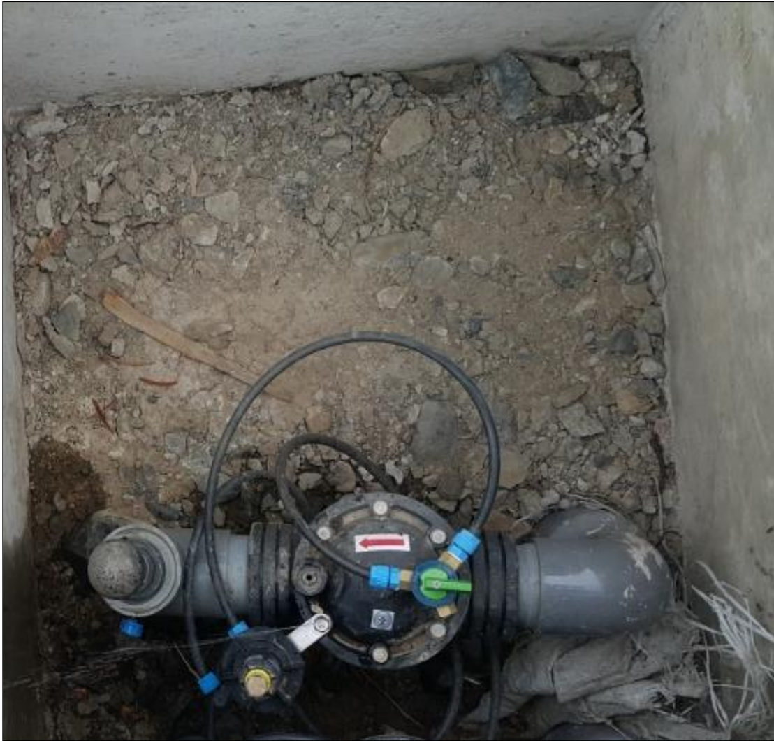
Figura 18: Instalación de arco de riego
