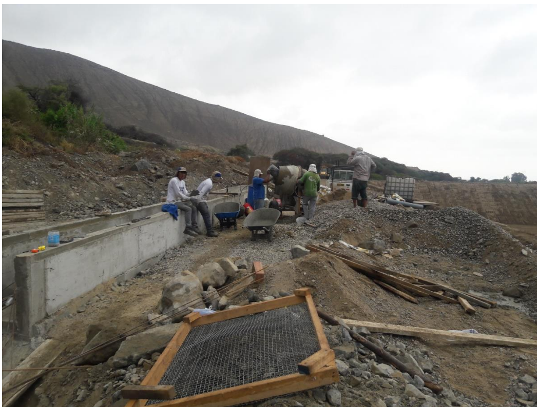
Figura 43: Vaciado de concreto en desarenador
