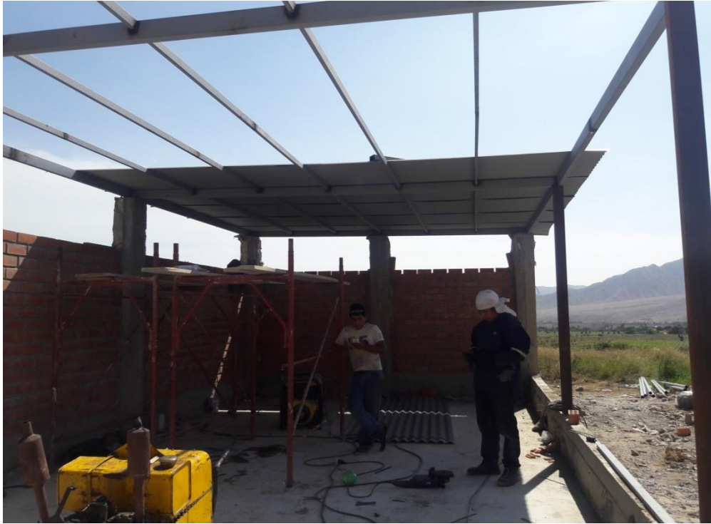
Figura 41: Construcción de techo de caseta
