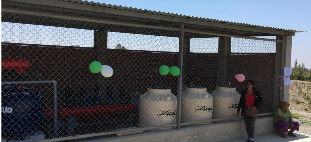
Figura 37: Caseta de riego
