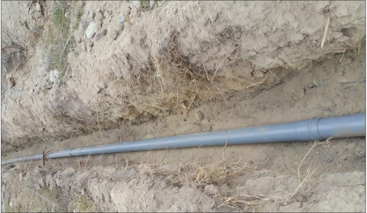
Figura 17: Instalación de tubería matriz
