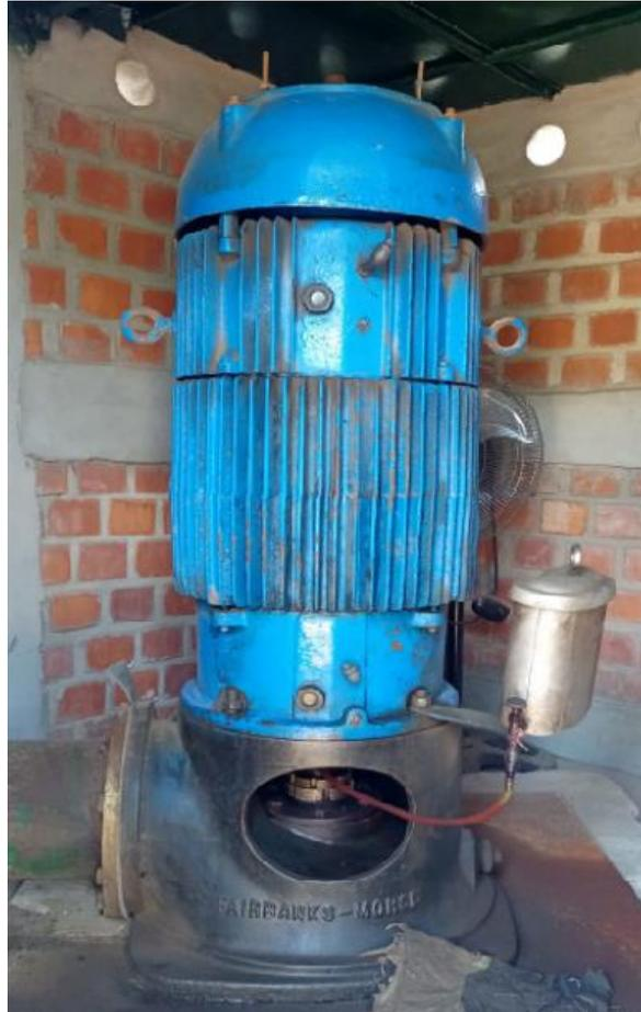
**Figura 7: Bomba turbina vertical con motor de eje sólido en el fundo San Miguel**
