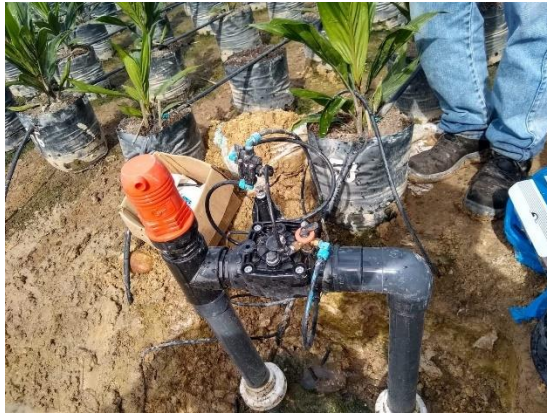
Figura 36: Válvula de aire instaladas en arcos de riego
