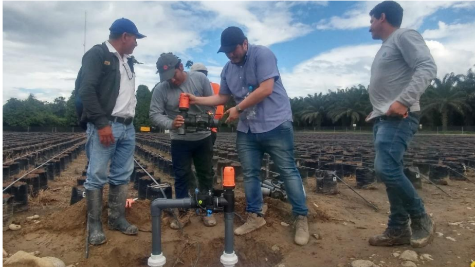
Figura 31: Instalación de arcos de riego en vivero
