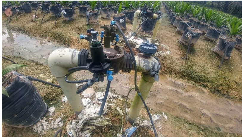
Figura 30: Arco de riego de vivero de almácigo por cambiar
