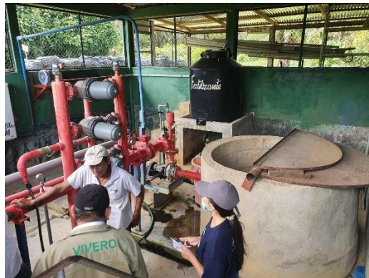
Figura 27: Caseta de riego donde se ubica el pozo
