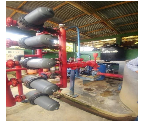
EVALUACIÓN DEL ESQUEMA DE FILTRADO A LA SALIDA DEL POZO
