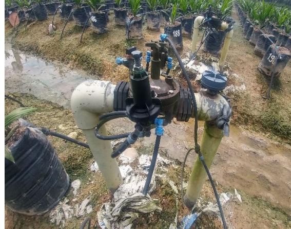
REVISIÓN DE LOS ANILLOS DE FILTROS UBICADOS EN CASETA
