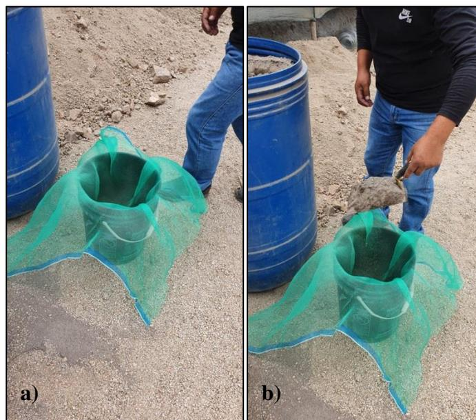
**Figura 16:** Zarandeo de arena. a) Se realizó el zarandeo de la arena de río para eliminar piedrecillas u otros materiales que afecten al sistema y b) Llenado de la malla con arena de río
