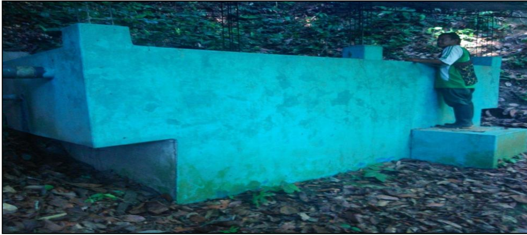
Figura 6: Sedimentador del sistema de conducción de agua
