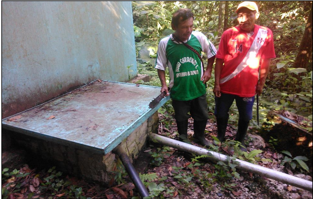
Figura 8: Reservorio Apoyado Existente
