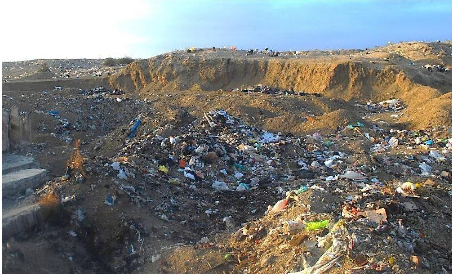
Figura 45: Relleno sanitario colapsado
