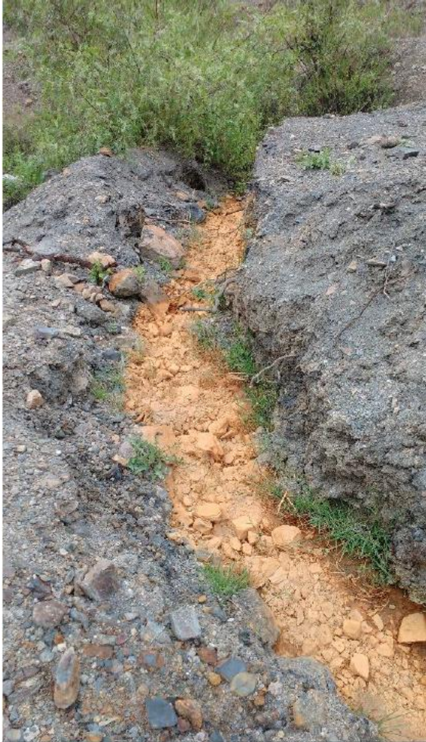
Figura 16: Canal de riego encontrado antes de la ejecución del mejoramiento del sistema de conducción y distribución de agua en la Comunidad Campesina de Tongos
