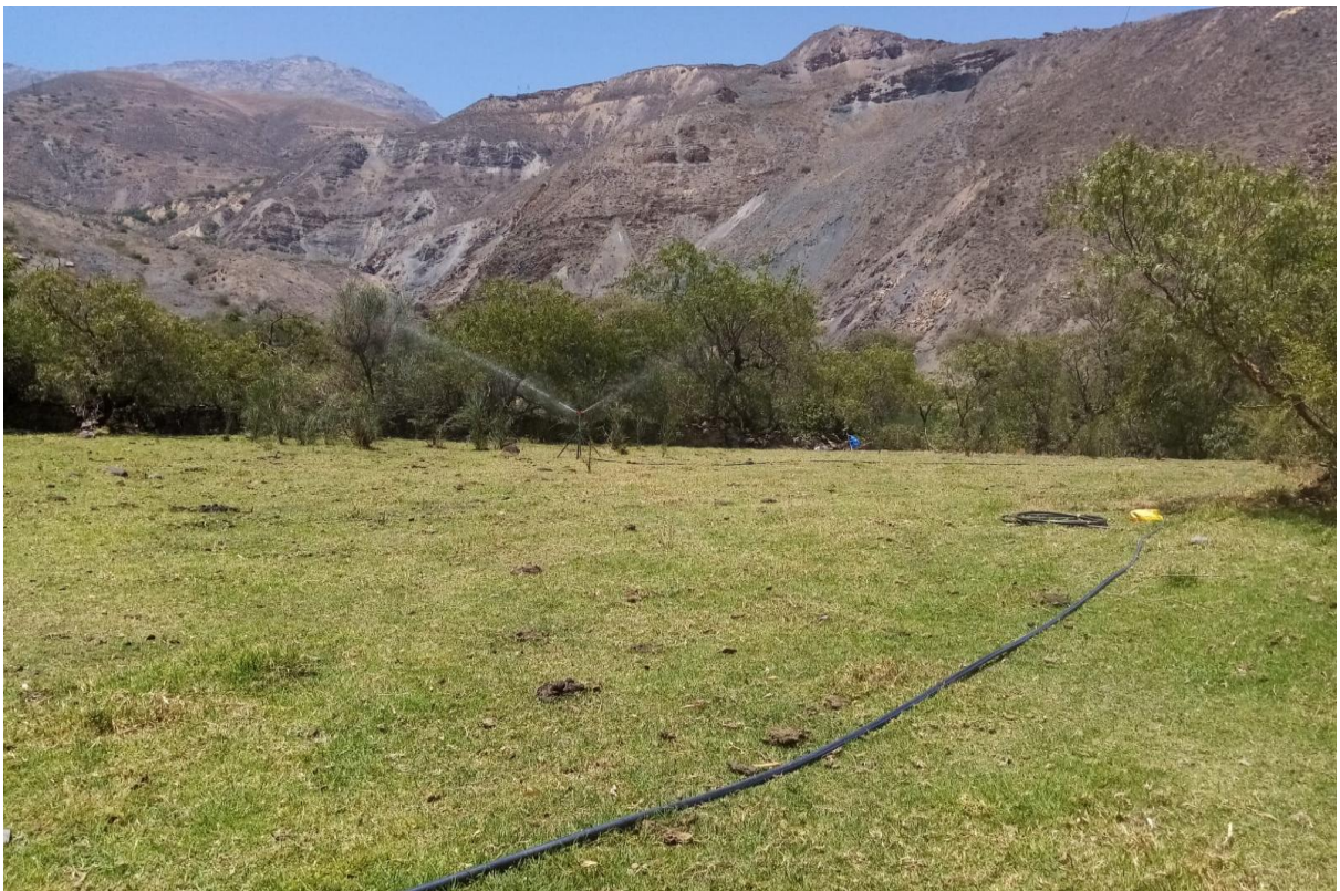
Figura 15: Prueba hidráulica del mejoramiento del sistema de conducción y distribución de agua en la Comunidad Campesina de Tongos
