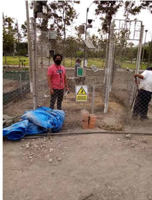
Figura 158: Habilitación de la zona de instalación para colocación de grass americano.
