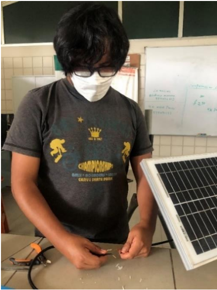
Figura 126: Unión de cables de panel solar para conexión.
