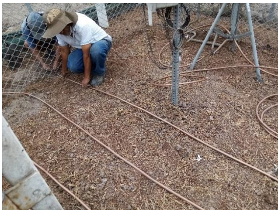
Figura 159: Colocación de mangueras para riego por goteo subterráneo para grass americano.
