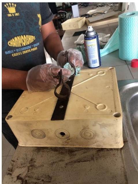
Figura 166: Mantenimiento y limpieza de la caja de protección de la batería y regulador de carga.
