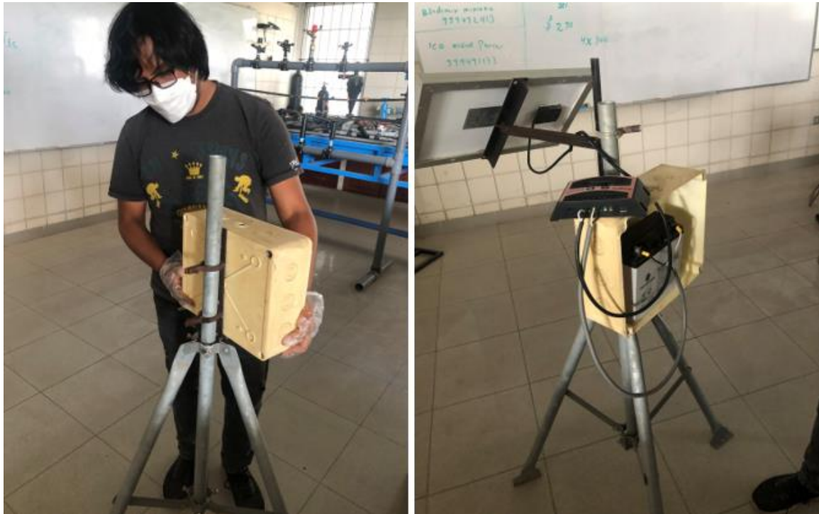
Figura 97: Instalación de caja de protección para batería y regulador de carga.
