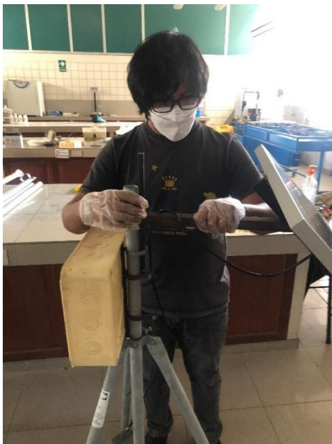
Figura 128: Instalación de estructura de soporte de panel sobre mástil.
