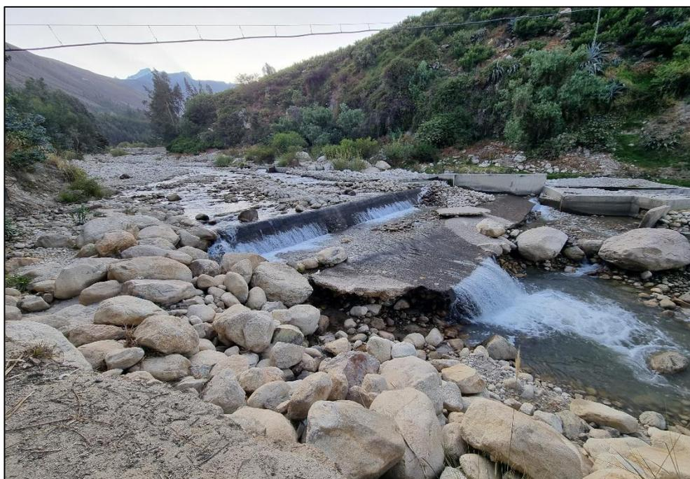
**Figura 71: Colchón disipador de la bocatoma existente aguas abajo de la bocatoma Lullán en muy mal estado**
