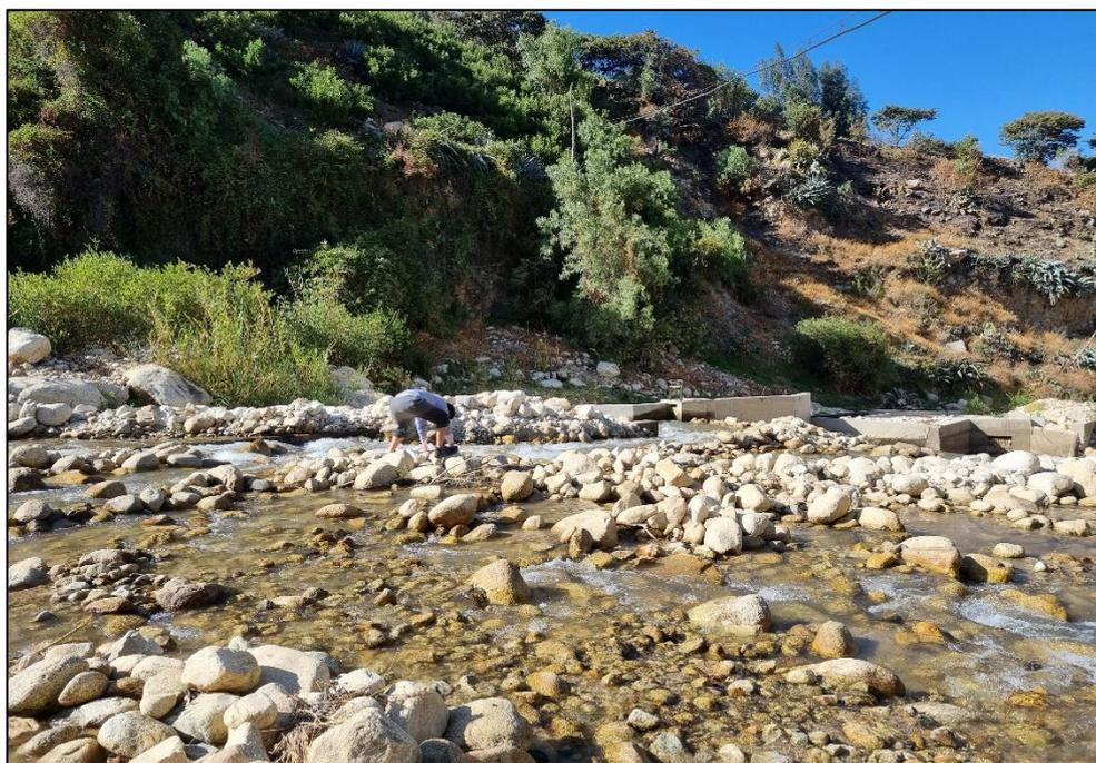
**Figura 72: Medición de diámetro de rocas acumuladas en la bocatoma existentes aguas abajo de la bocatoma Llullán**
