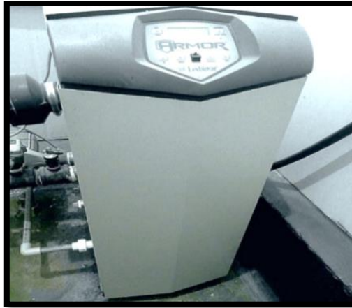
Figura 8: Calentador de agua Lochinvar modelo AWN285PM
