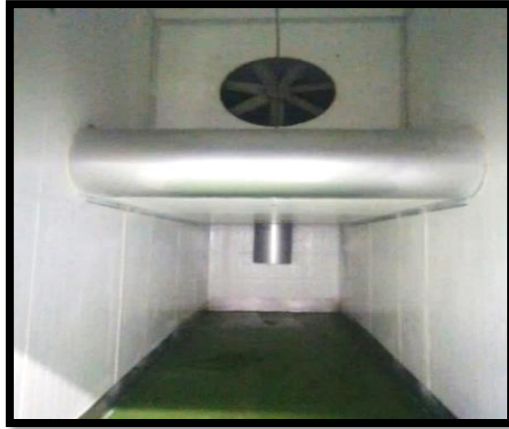
Figura 10: Extractor de aire
