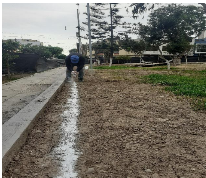
Figura 20: Marcado del terreno
