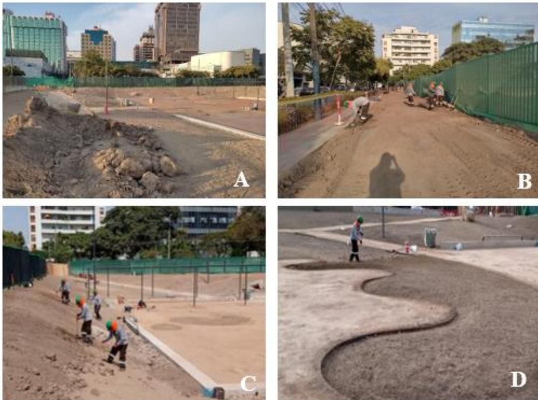
**Figura 17.** A. Presencia de terrones y suelo sin nivelación en sector Plaza. B. Nivelación de terreno en sector Playa. C. Nivelación en sector Plaza. D. Retiro de tierra excedente durante el proceso de nivelación, considerando una diferencia de altura de 5 cm por debajo del piso terminado.
