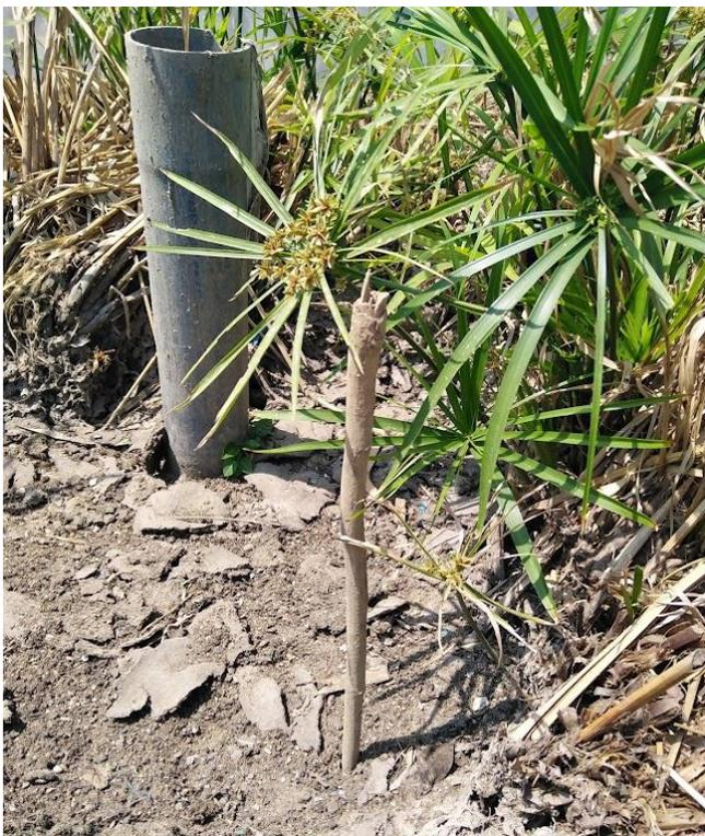
Foto 9. Lodo acumulado alrededor de la tubería de alimentación. Platos de distribución cubiertos de lodo.
