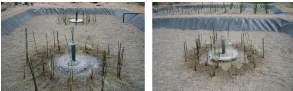
**Figura 17. Distribución del agua sobre la superficie de la celda francesa (flujo ascendente). A la izquierda, línea 1 en funcionamiento; a la derecha, línea 2. Cada línea funciona por 3 días alternándose entre ellas.**
