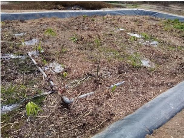
Foto 12. Distribución del agua residual pretratada en la segunda etapa del sistema.
