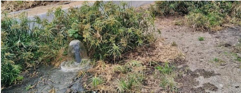
Foto 11. Funcionamiento de la línea 1 en la primera etapa del SF. Flujo ascendente en la distribución del agua residual cruda.
