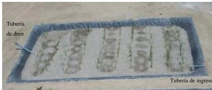
**Figura 18. Humedal vertical de la segunda etapa del SF, recién plantado y en funcionamiento (año 2011).**
