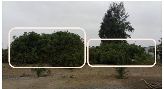
Foto 2. Vista lateral del Sistema Francés. A la izquierda, segunda etapa y a la derecha, primera etapa. Inaccesibilidad a las tuberías de alimentación.
