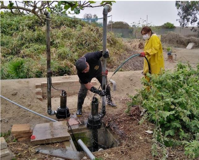
Foto 3. Limpieza y revisión de bombas de la EB1.
