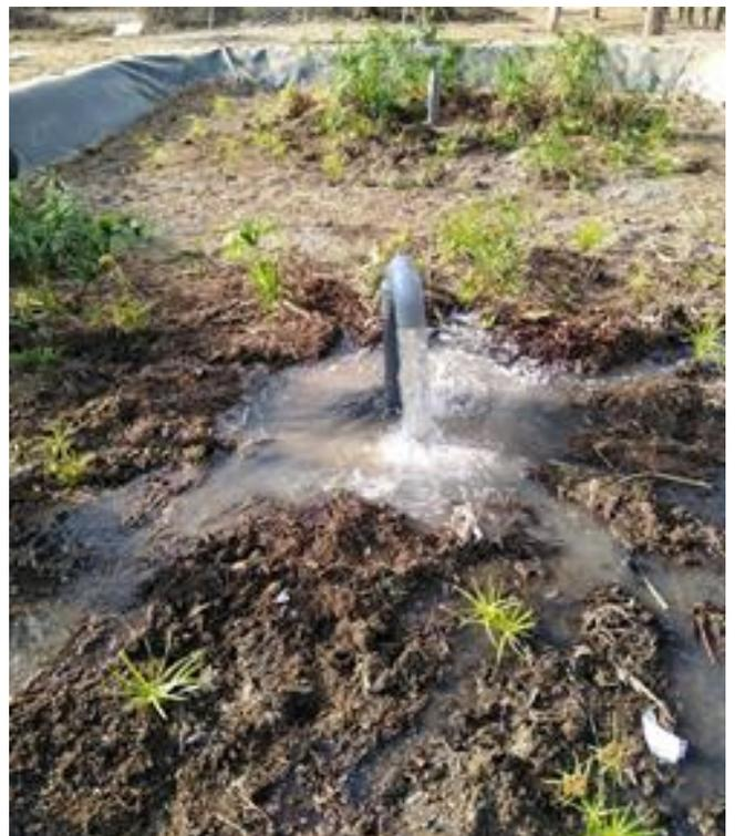
Foto 10. Apertura de surcos sobre la superficie de la celda francesa para mejorar la distribución del afluente. Instalación provisional de codos de pvc para facilitar la medición del caudal de ingreso.
