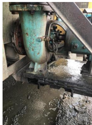
Figura 11: Bombas de difusor con fugas de jugo crudo
