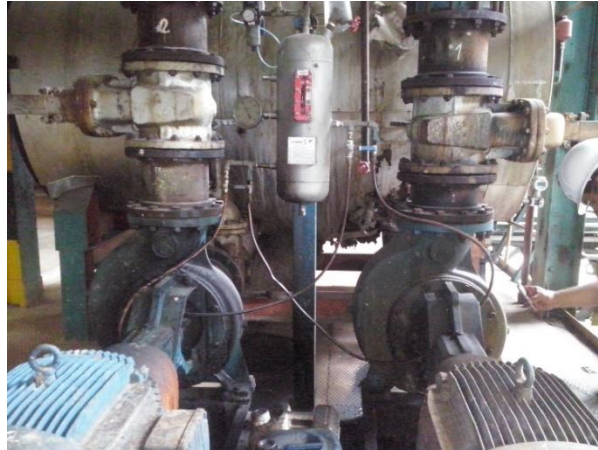
Sello mecánico propuesto 250 + tanque
