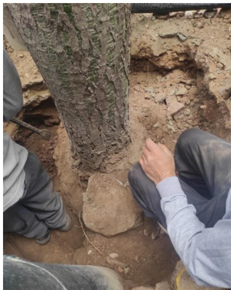
Figura 4: Apertura de zanja
