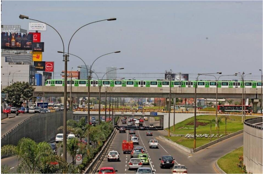
Figura 2: Línea 1 del Tren Eléctrico
