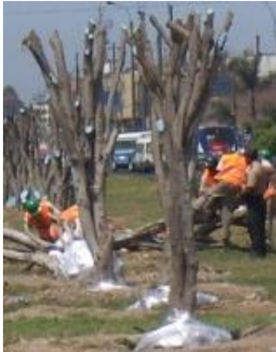
Figura 7: Árboles enretados listos para el carguío al camión grúa
