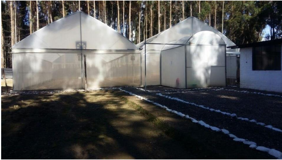
Figura 22. Módulos del Invernadero.
