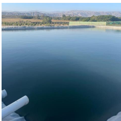
Figura 12. Reservorio con geomembrana
