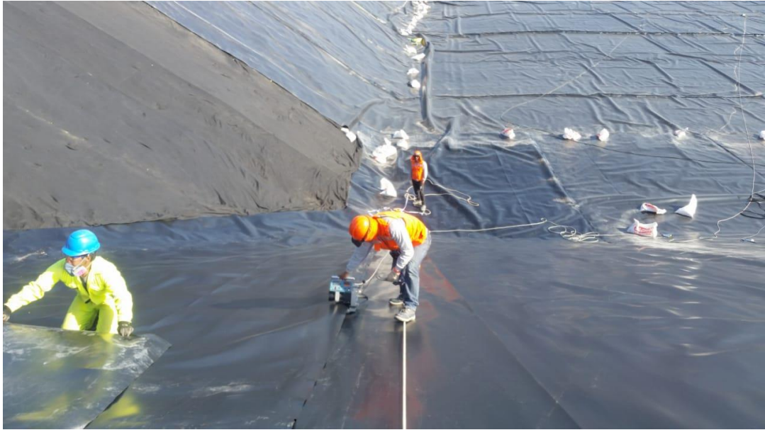
Figura 10. Utilización de cuña para unir pliegos de geomembrana
