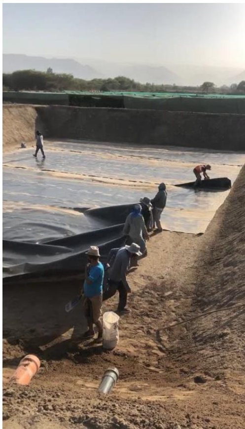
Figura 9. Colocación de geomembrana para reservorio
