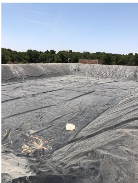
Figura 12. Reservorio con geomembrana
