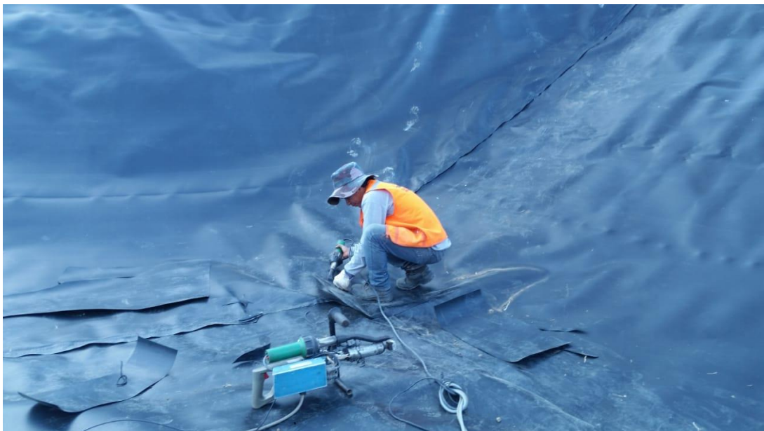
Figura 11. Uso de máquina extrusora para sellar esquinas del reservorio
