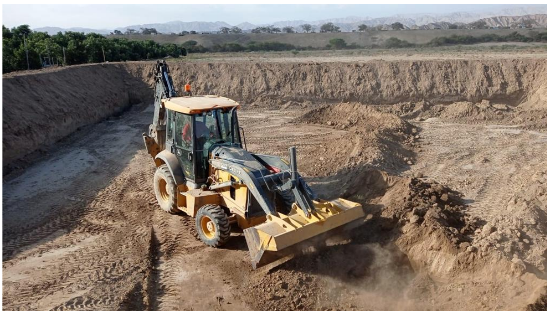
Figura 7. Excavadora haciendo reservorio
