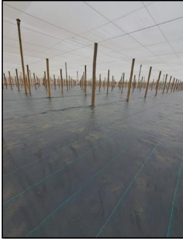
Figura 3. Instalación de manta ground cover.
