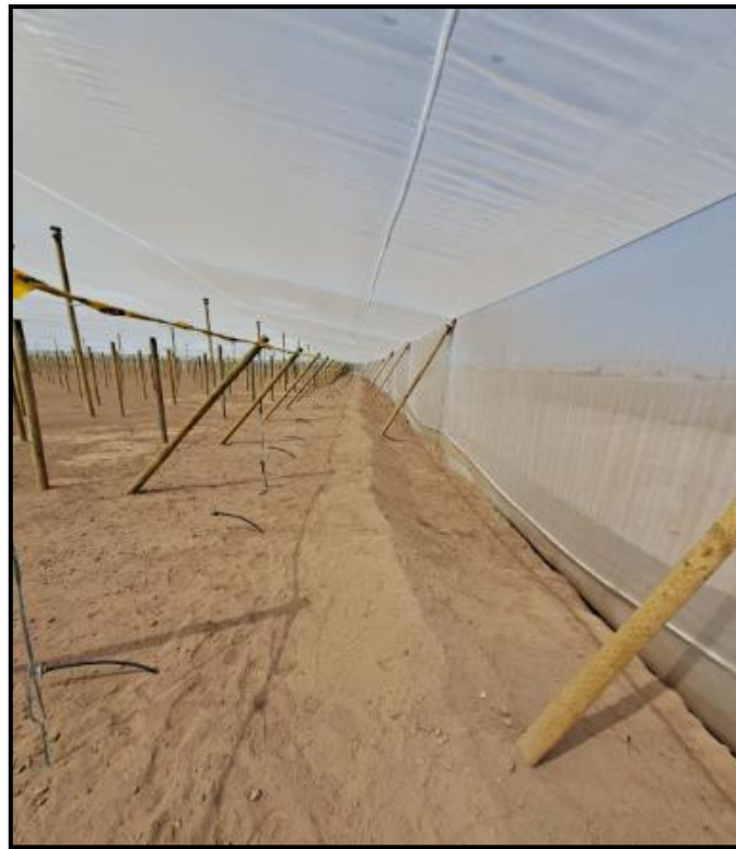
Figura 2. Instalación de casa malla.
