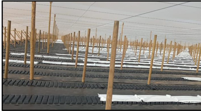
Figura 8. Ubicación de separadores.
