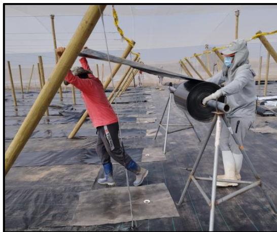
Figura 7. Tendido de geomembrana.
