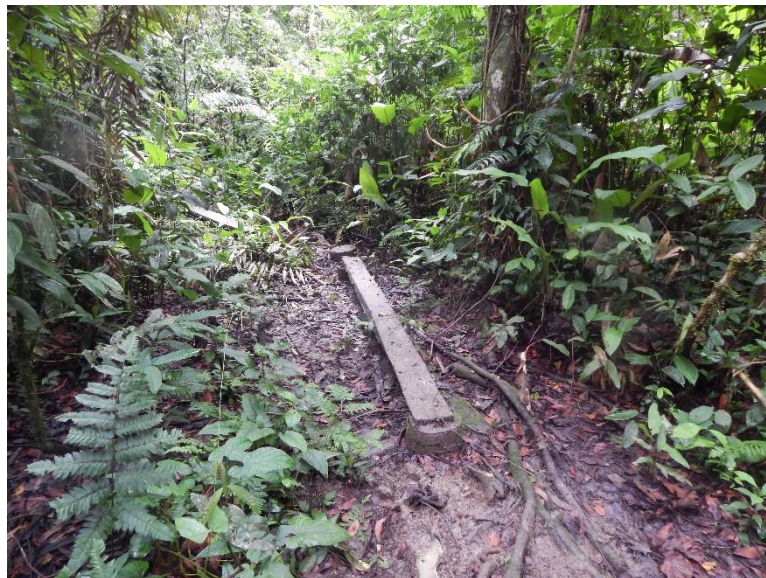
Figura 17. Andamio de madera para cruce peatonal en trocha inundable. Estación Biológica Los Amigos, Madre De Dios. Marzo a Abril 2016.
