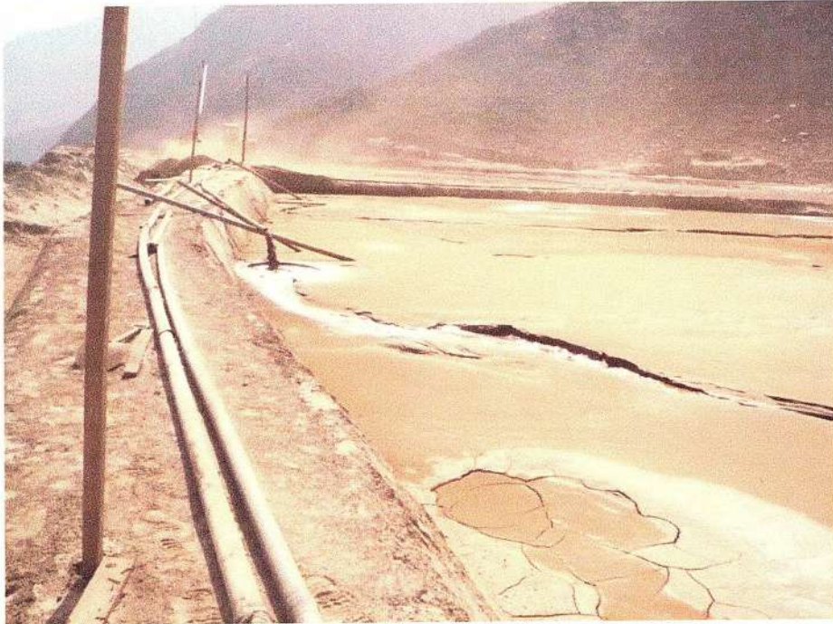
Fotografía N° 02: Vista de la descarga de los relaves en el depósito actual Metalex.
