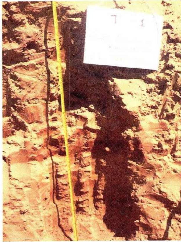
Fotografía N° 16: Vista de la Trinchera T-1 ubicada en el talud del antiguo depósito de relaves. Se observa la presencia de limos de alta humedad, medianamente compacto, con lentes de arena y arcilla.
