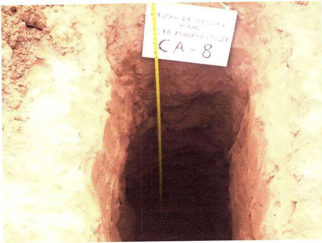
Fotografía N° 12: Vista de la Calicata CA-8 ubicada en la corona del depósito de relaves en operación. Se observa la presencia de limo húmedo y blando con arcillas.
