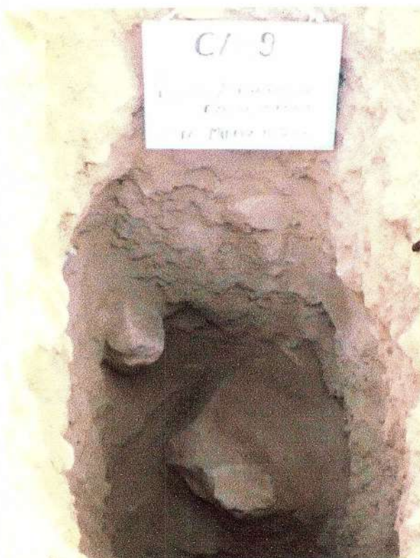
Fotografía N° 14: Vista de la Calicata CA-9 ubicada en la cimentación de la ampliación del depósito de relaves. Se observa la presencia de arena limosa con lentes de arcilla, bolonería y material heterogéneo.
