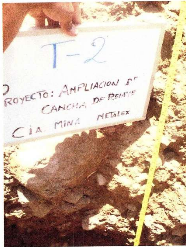
Fotografía N° 18: Vista de la Trinchera T-2 ubicada en el talud del depósito de relaves en operación. Se observa la presencia de arena limosa con bolonería de 20 a 30 cm.
