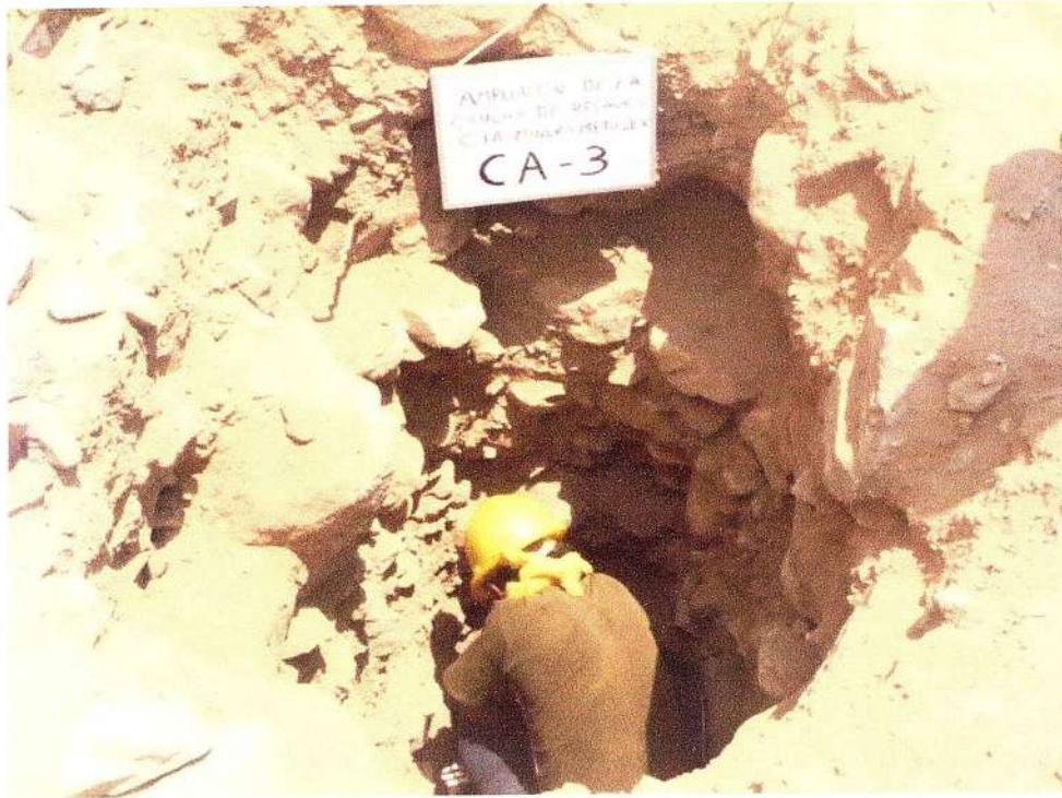
Fotografía N° 06: Vista de la Calicata CA-3 ubicada en la cimentación de la ampliación del depósito de relaves. Se observa la presencia de limo arenoso superficial y grava con mala gradación en niveles inferiores. Presencia de bolonería de 0.30 –0.40 m.
